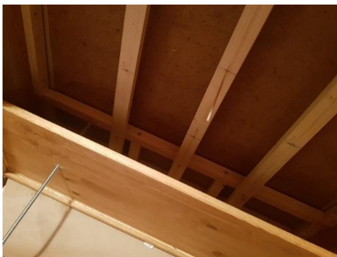
Obrázek 41: Dřevěná kostra pro otáčivý mechanismus
