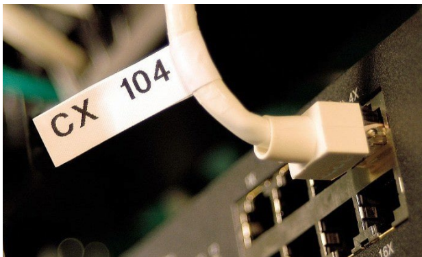
Obrázek 8: Příklad označeného vodiče [11]
