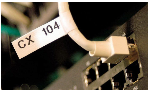
Obrázek 8: Příklad označeného vodiče [11]
