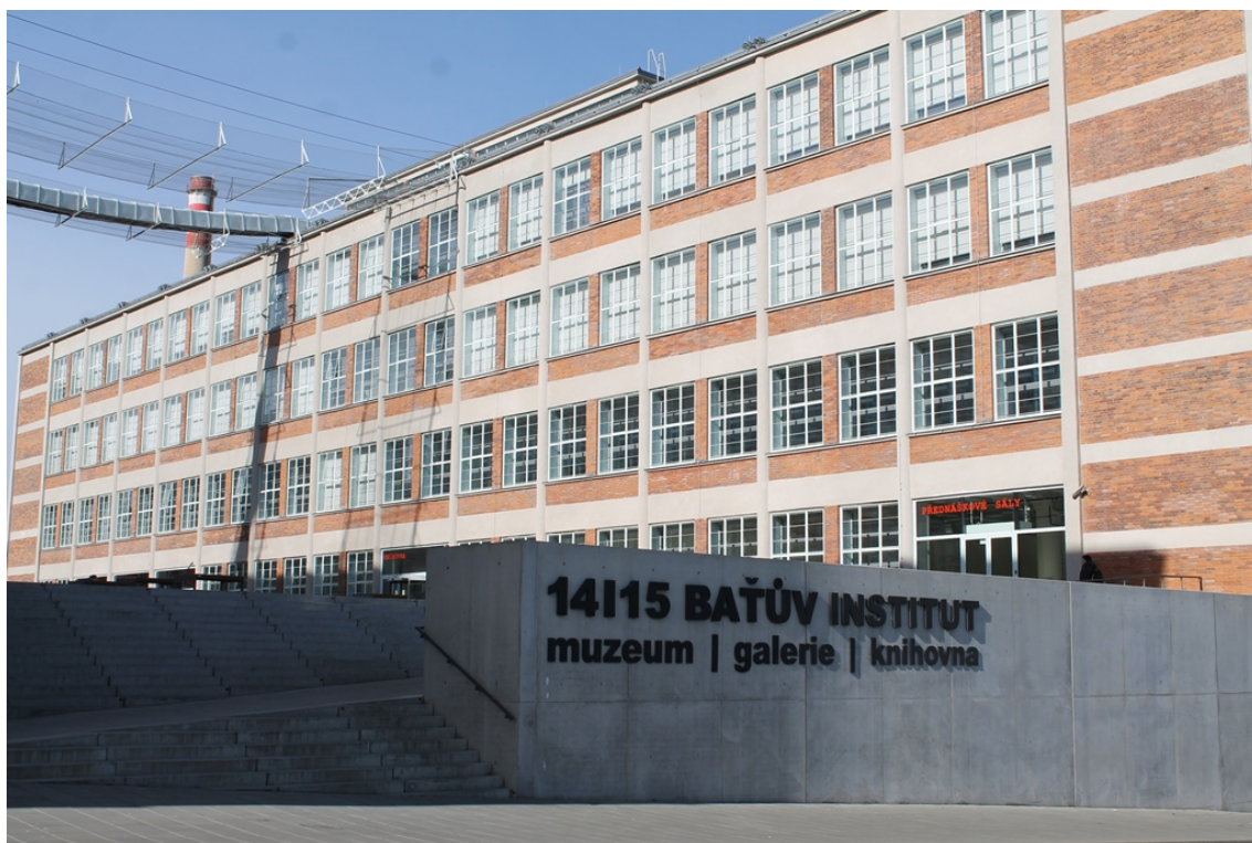
Obrázek 4 Exteriér budovy 14|15 Bařův institut (zdroj: 14-15.cz)
