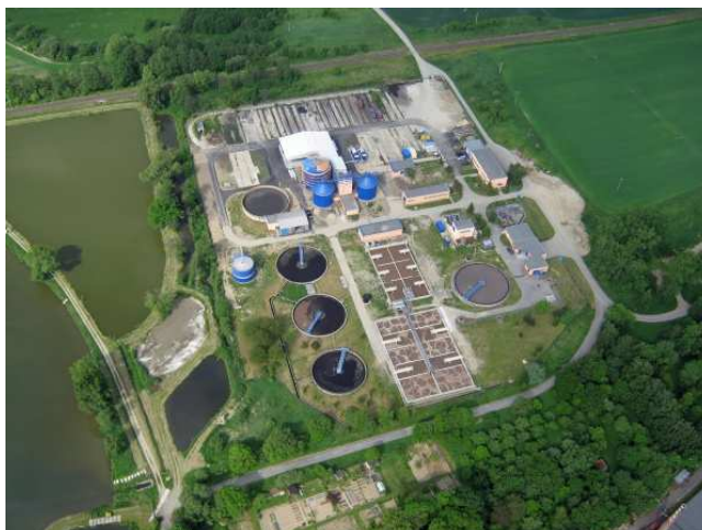
Obr. 3 Čistírna odpadních vod Krnov [11]
