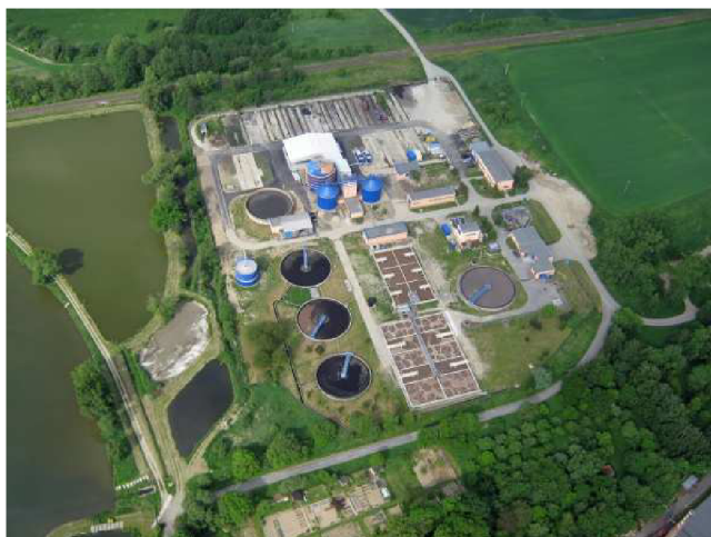
Obr. 3 Čistírna odpadních vod Krnov [11]
