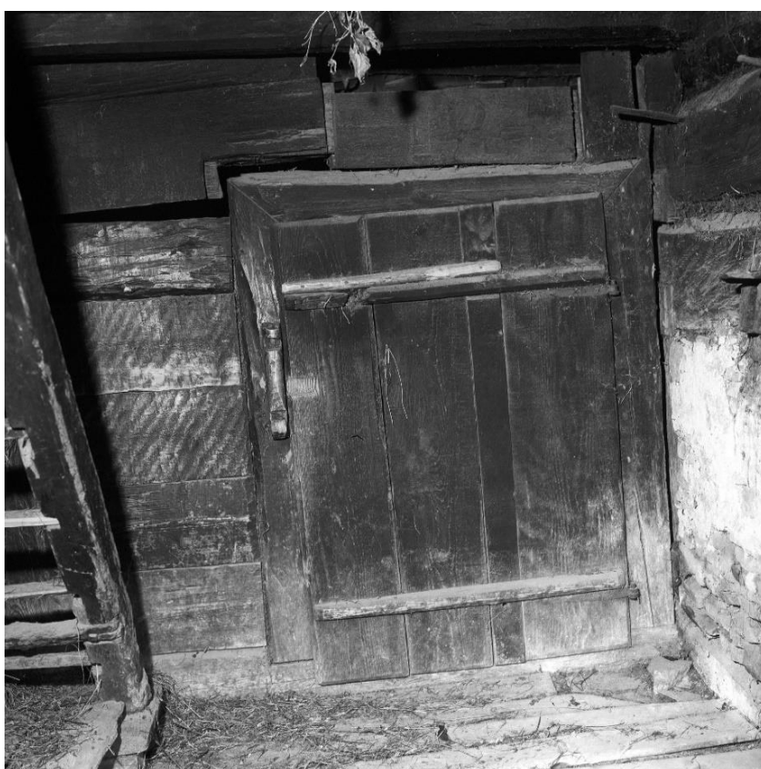
Obr. 5.1.263: Původní umístění prvku 137 před rozebráním objektu.
