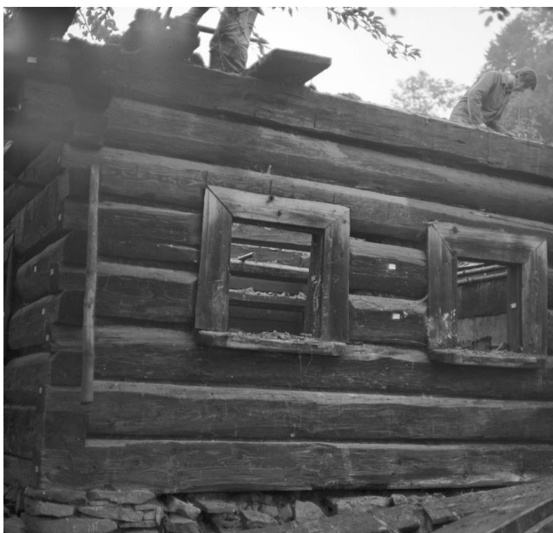
Obr. 5.1.173: Původní umístění prvku 87 před rozebráním objektu.
