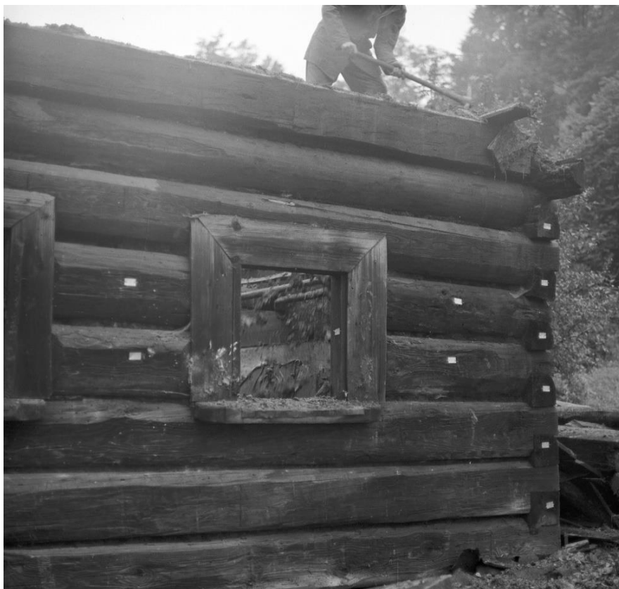
Obr. 5.1.181: Původní umístění prvku 91 před rozebráním objektu.
