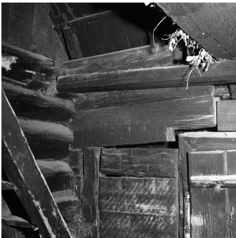
Obr. 5.1.283: Původní umístění prvku 142 před rozebráním objektu.
