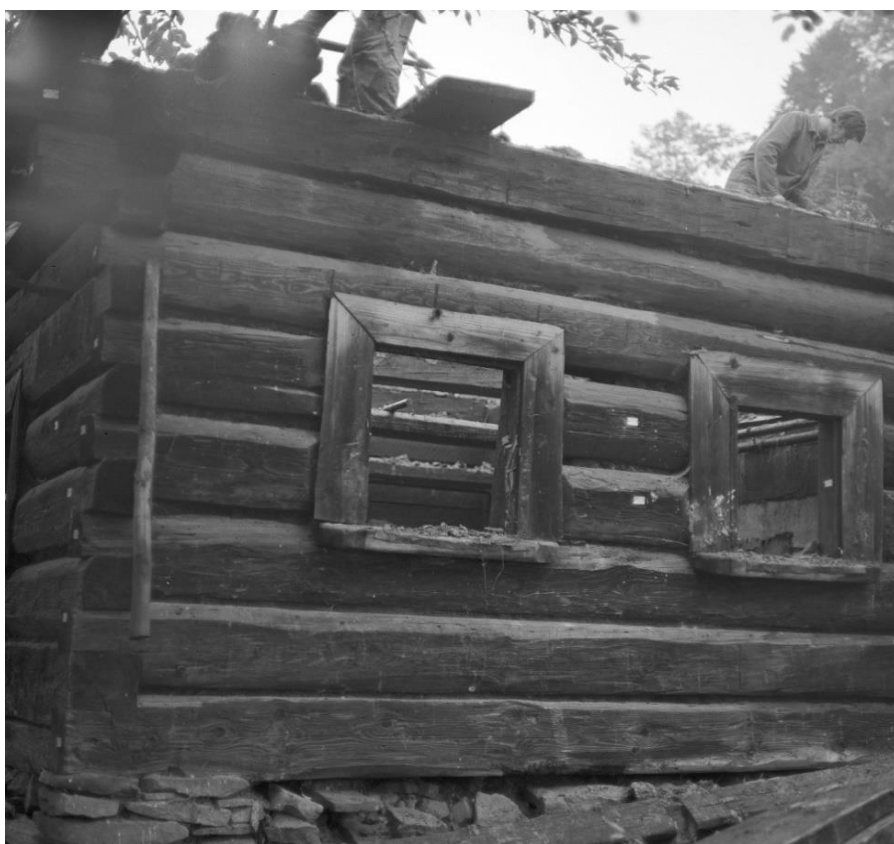
Obr. 5.1.158: Původní umístění prvku 75 před rozebráním objektu.
