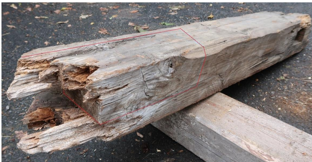
Obr. 5.1.217: Detail označení místa konstrukční sanace – vložka 0,5 m.
