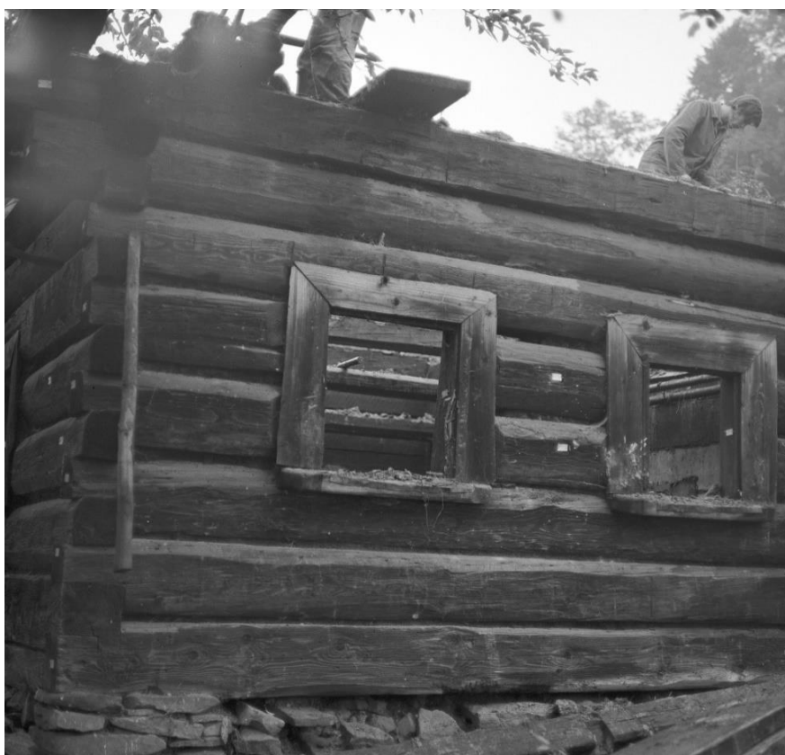
Obr. 5.1.127: Původní umístění prvku 55 před rozebráním objektu.
