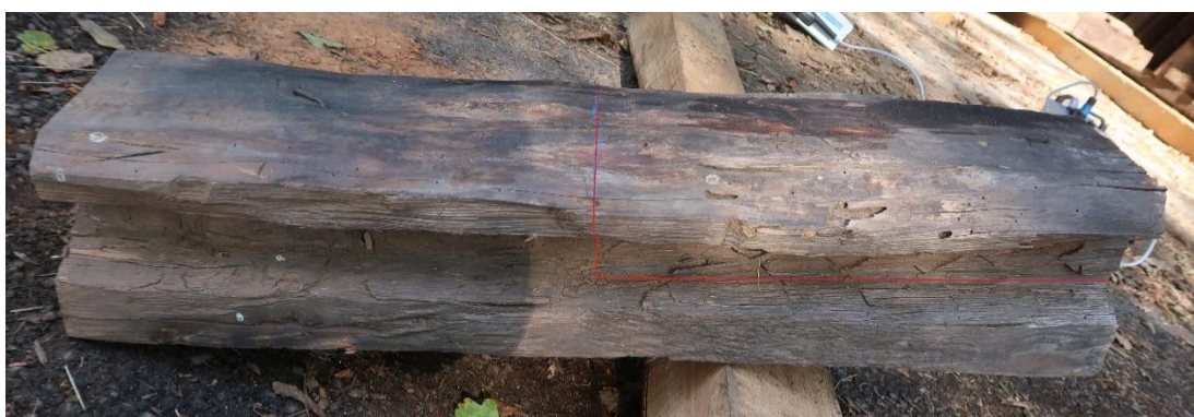
Obr. 5.1.169: Detail označení místa konstrukční sanace – vložka 0,4 m.
