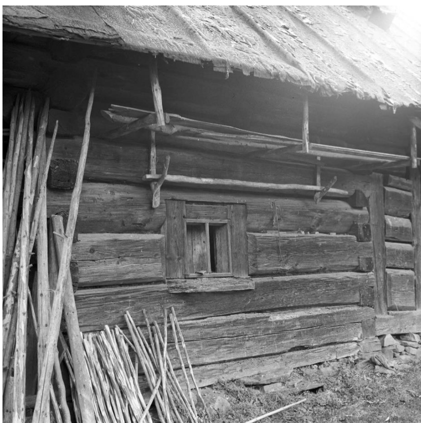
Obr. 5.1.36: Původní umístění prvku 12 před rozebráním objektu.
