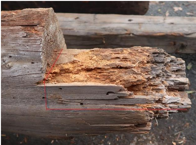
Obr. 4.4.4: Vyznačení místa budoucího zásahu částečné konstrukční sanace.
