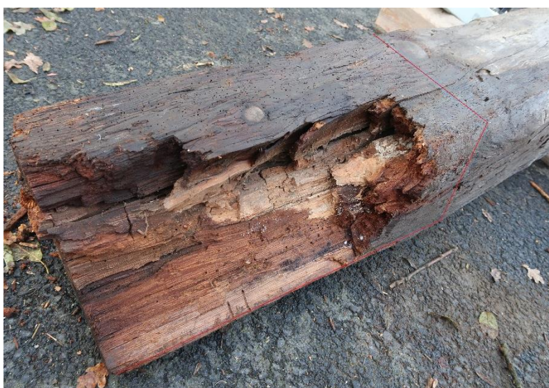
Obr. 5.1.53: Detail označení místa konstrukční sanace – vložka 0,6 m.
