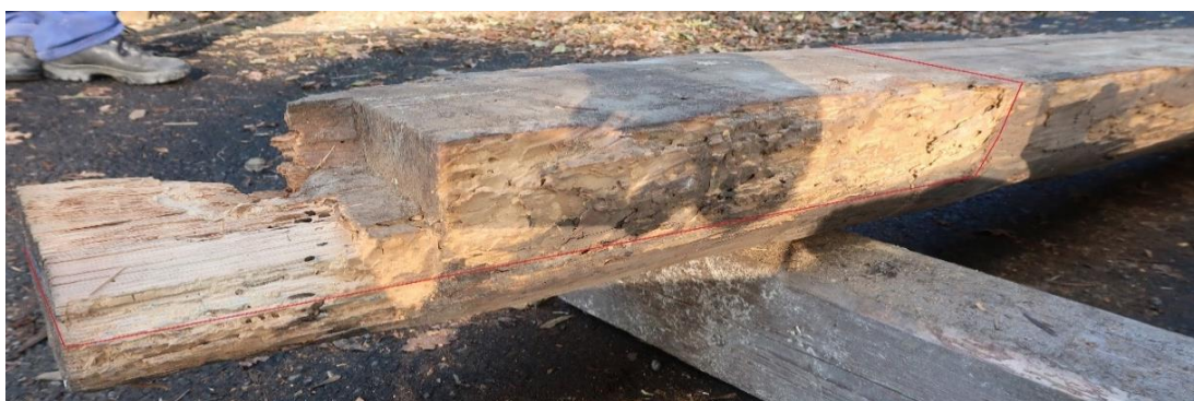
Obr. 5.1.132: Detail označení místa konstrukční sanace – vložka 0,7 m.
