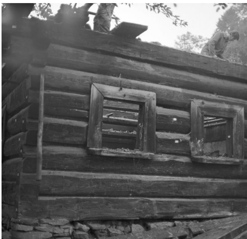
Obr. 5.1.185: Původní umístění prvku 94 před rozebráním objektu.
