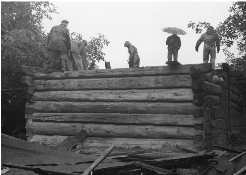
Obr. 5.1.22: Původní umístění prvku 8 před rozebráním objektu.
