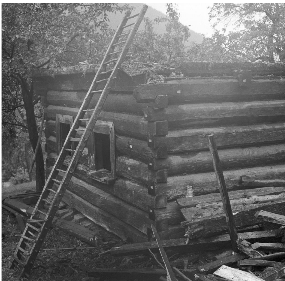
Obr. 5.1.202: Původní umístění prvku 100 před rozebráním objektu.
