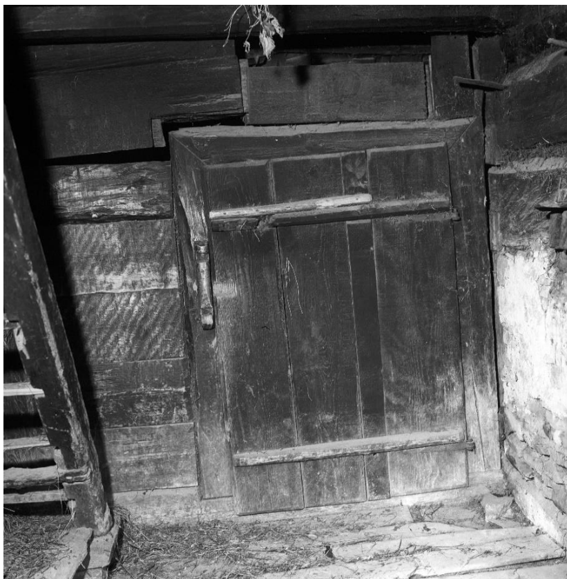
Obr. 5.1.249: Původní umístění prvku 133 před rozebráním objektu.
