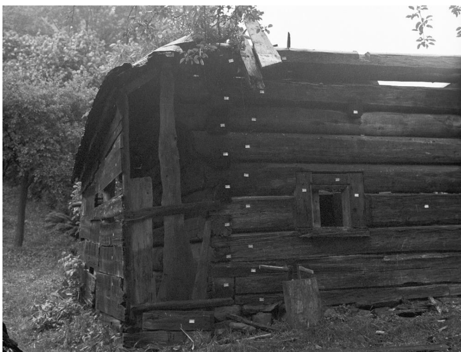
Obr. 5.1.71: Původní umístění prvku 29 před rozebráním objektu.
