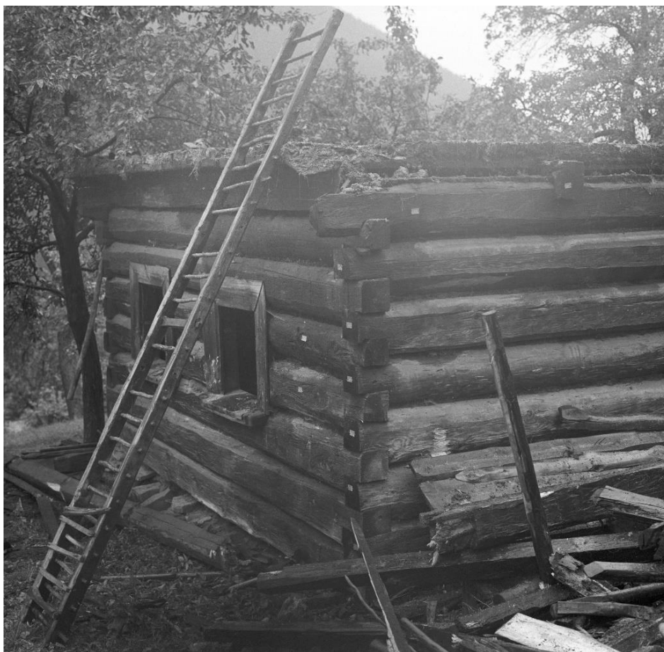
Obr. 5.1.198: Původní umístění prvku 99 před rozebráním objektu.
