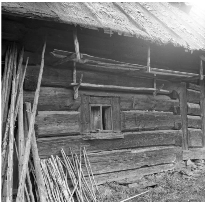
Obr. 5.1.31: Původní umístění prvku 11 před rozebráním objektu.
