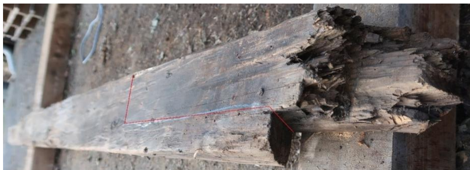
Obr. 5.1.302: Detail označení místa konstrukční sanace – vložka 0,5 m.
