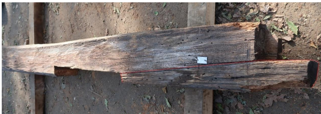
Obr. 5.1.32: Detail označení místa konstrukční sanace – vložka 1,1 m.
