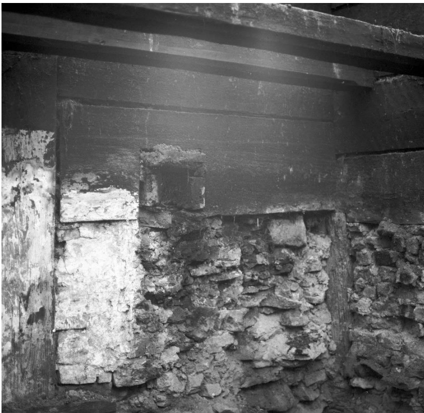
Obr. 5.1.224: Původní umístění prvku 120 před rozebráním objektu.
