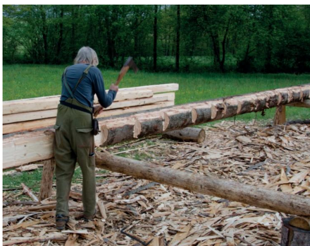
Obr. 3.4.1.1: Vrubování (Kloiber a kol., 2020).
