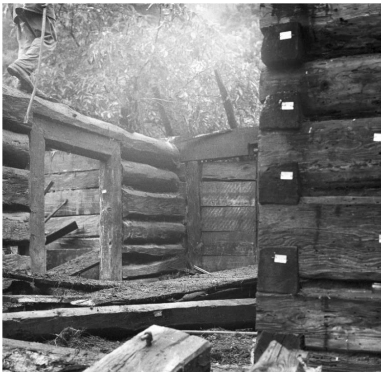
Obr. 5.1.237: Původní umístění prvku 128 před rozebráním objektu.
