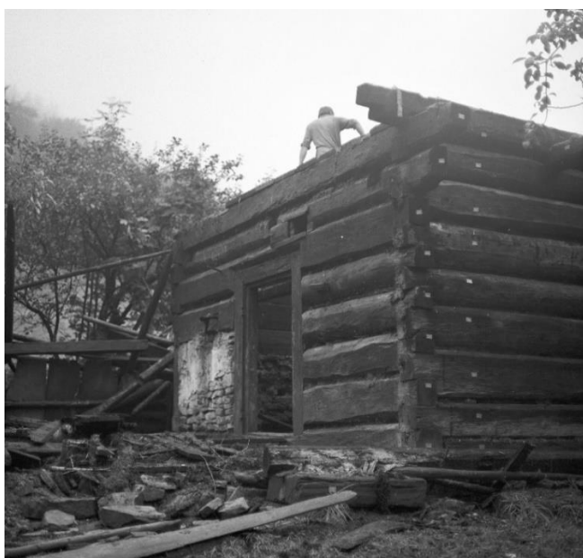
Obr. 5.1.216: Původní umístění prvku 117 před rozebráním objektu.
