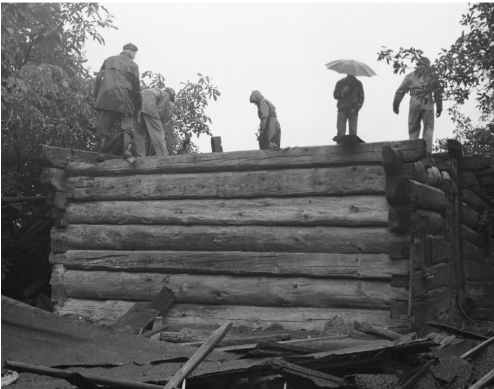
Obr. 5.1.14: Původní umístění prvku 6 před rozebráním objektu.
