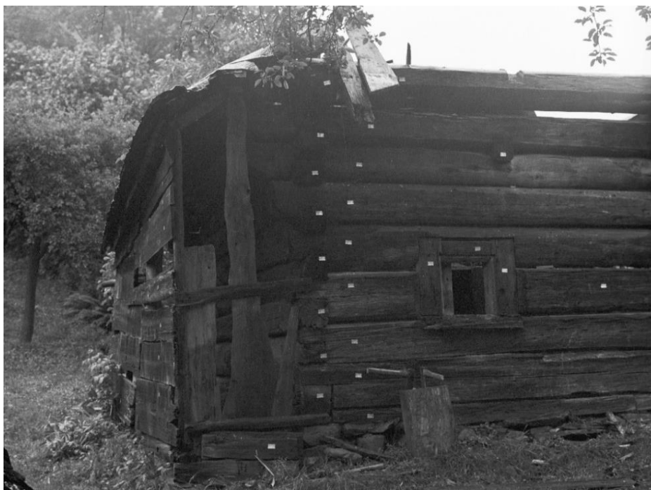
Obr. 5.1.67: Původní umístění prvku 27 před rozebráním objektu.
