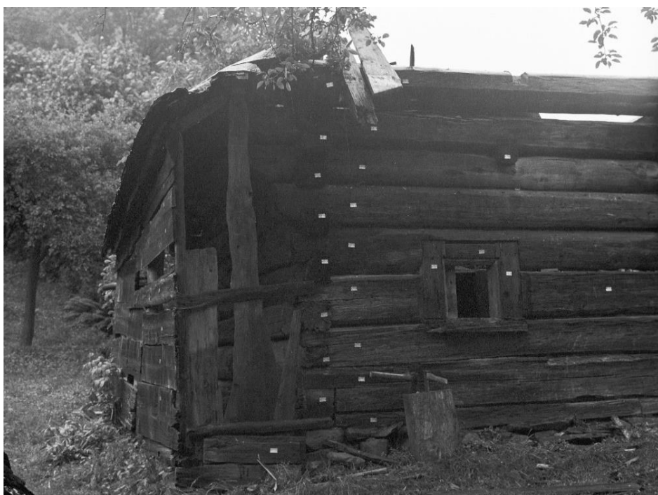
Obr. 5.1.75: Původní umístění prvku 31 před rozebráním objektu.
