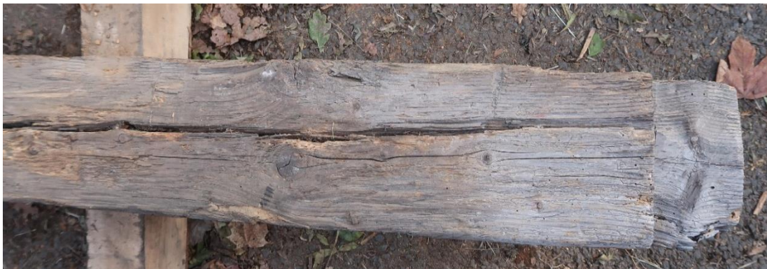
Obr. 5.1.27: Pravděpodobné nastavení pomocí přeplátování.
