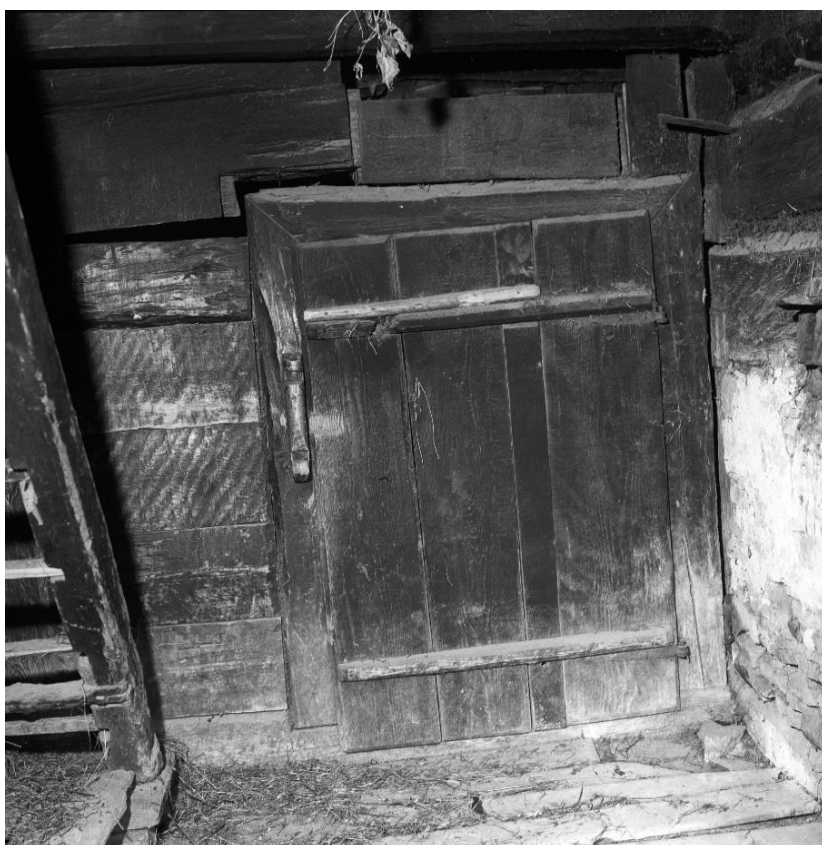
Obr. 5.1.241: Původní umístění prvku 131 před rozebráním objektu.
