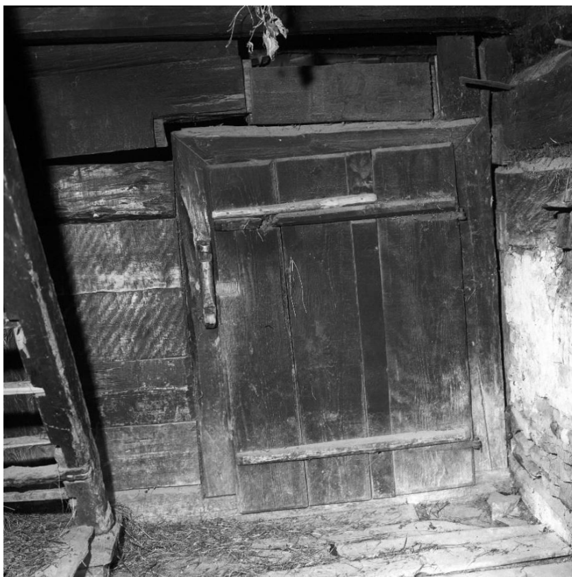
Obr. 5.1.275: Původní umístění prvku 140 před rozebráním objektu.
