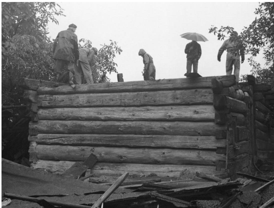
Obr. 5.1.18: Původní umístění prvku 7 před rozebráním objektu.
