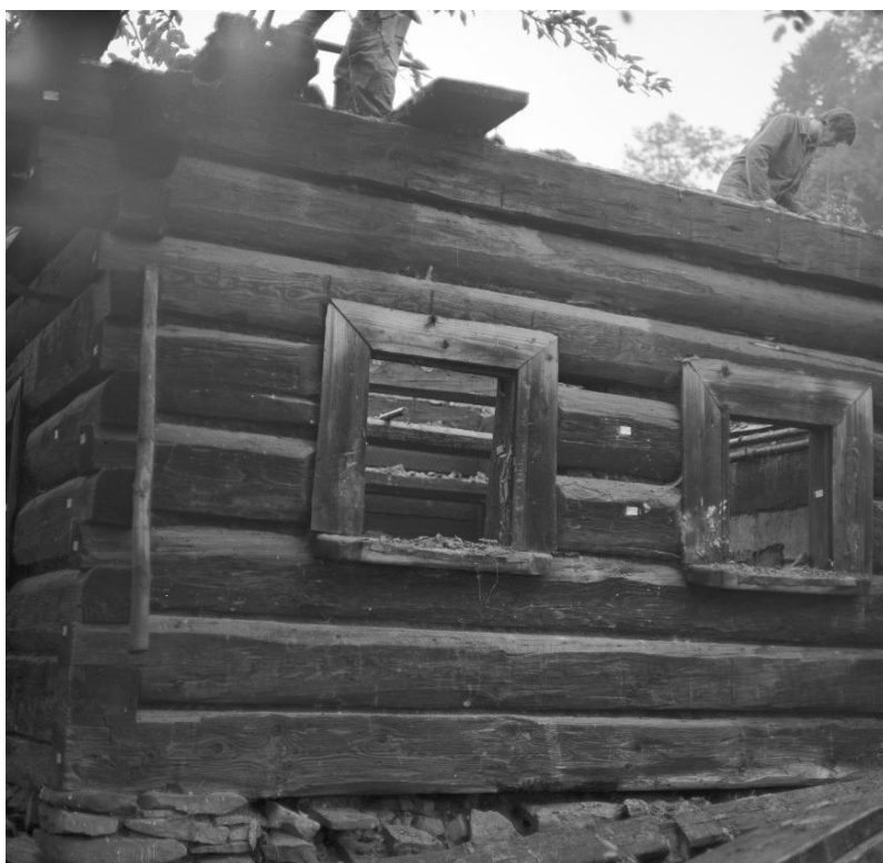
Obr. 5.1.168: Původní umístění prvku 84 před rozebráním objektu.
