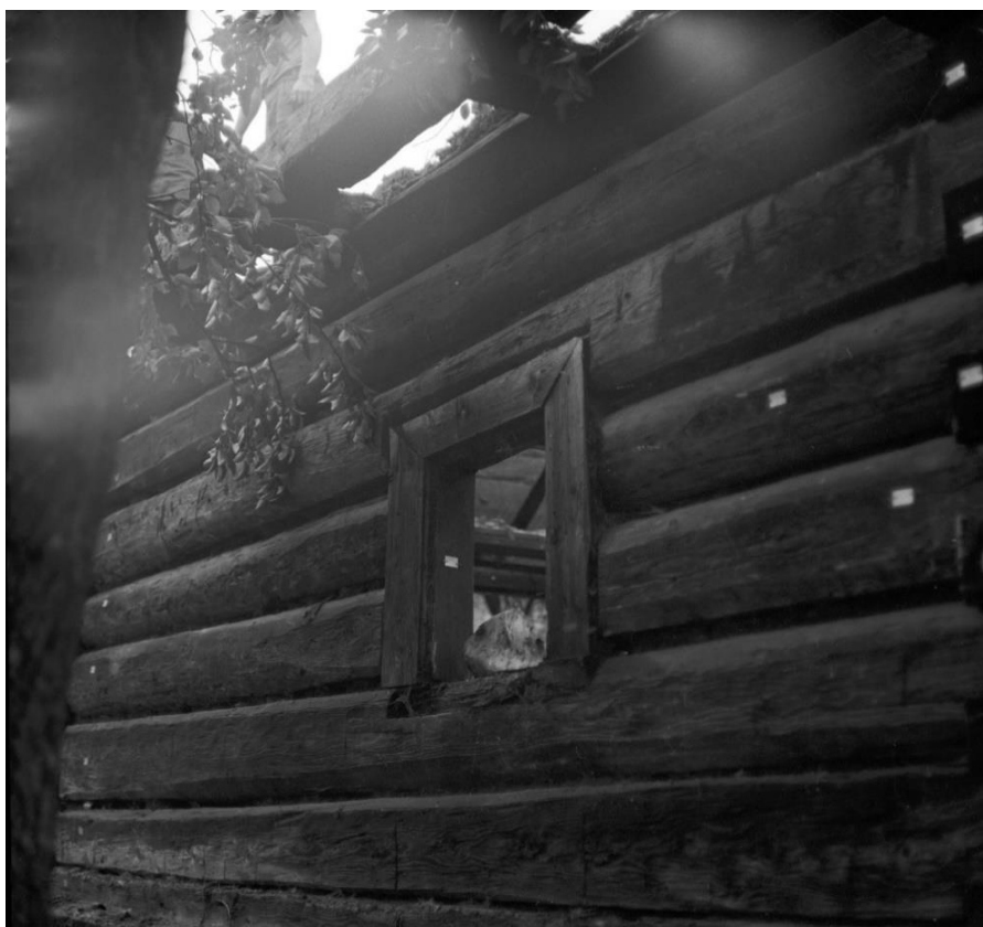
Obr. 5.1.140: Původní umístění prvku 59 před rozebráním objektu.
