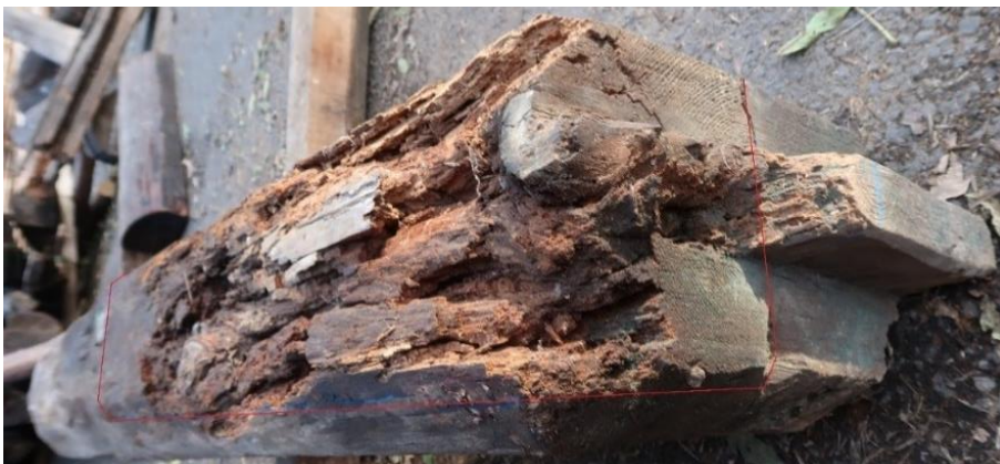
Obr. 5.1.287: Detail označení místa konstrukční sanace – vložka 0,9 m.
