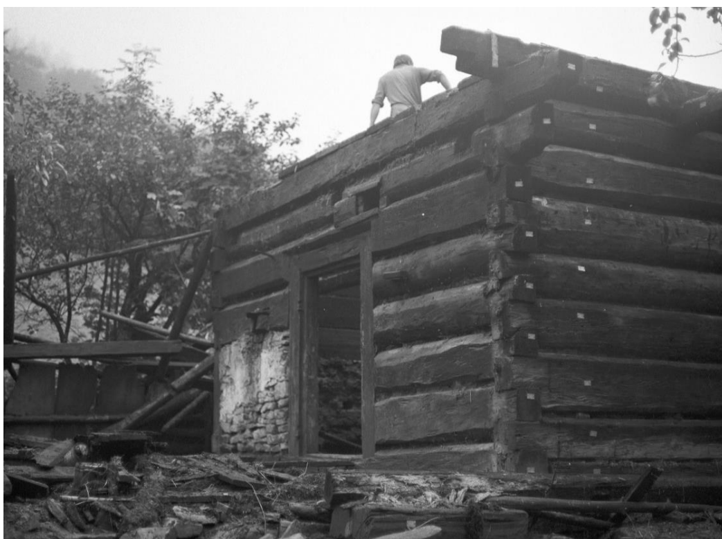
Obr. 5.1.123: Původní umístění prvku 49 před rozebráním objektu.
