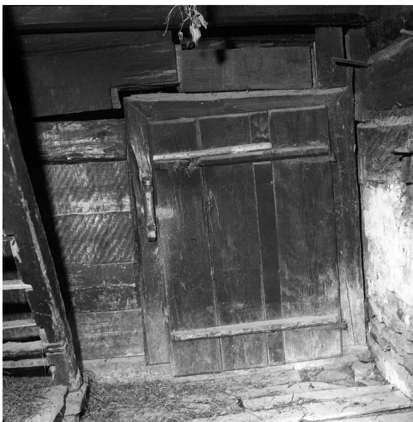
Obr. 5.1.253: Původní umístění prvku 134 před rozebráním objektu.
