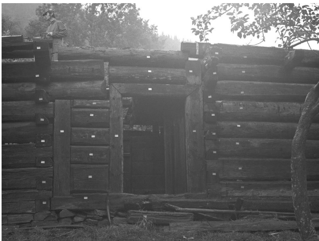
Obr. 5.1.119: Původní umístění prvku 43 před rozebráním objektu.
