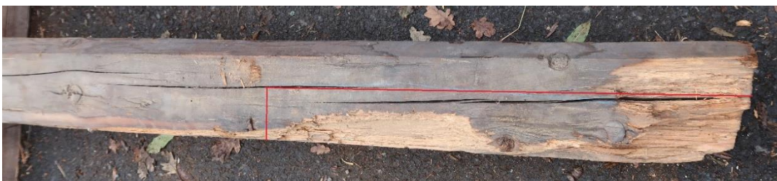
Obr. 5.1.233: Detail označení místa konstrukční sanace – vložka 0,6 m.
