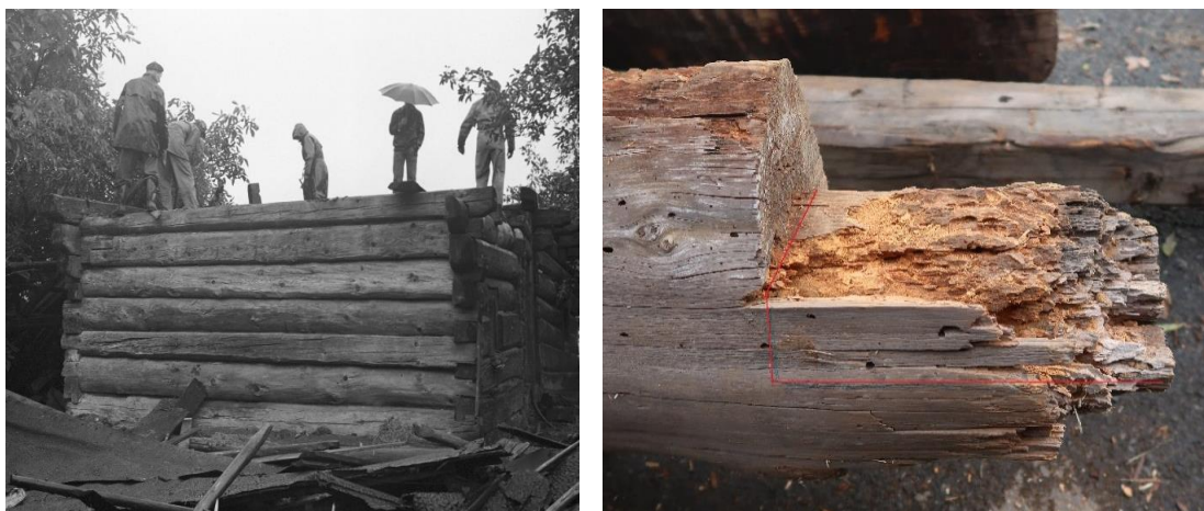
Obr. 5.1.4: Původní umístění prvku 2 před rozebráním objektu.
