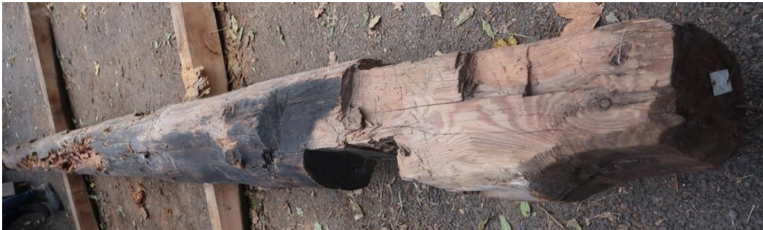
Obr. 5.1.21: Aktuální stav prvku 8 při diagnostice.
