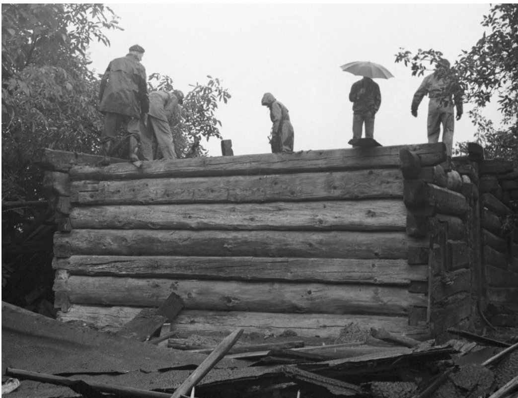
Obr. 5.1.10: Původní umístění prvku 4 před rozebráním objektu.
