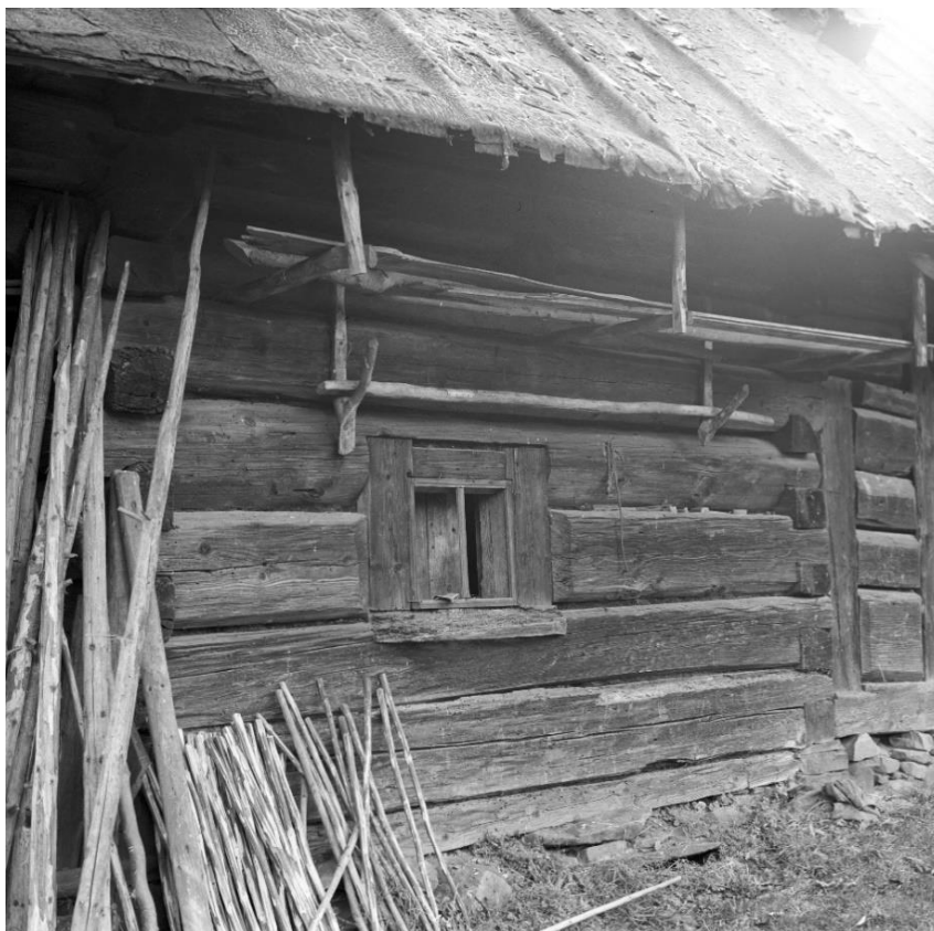
Obr. 5.1.40: Původní umístění prvku 14 před rozebráním objektu.
