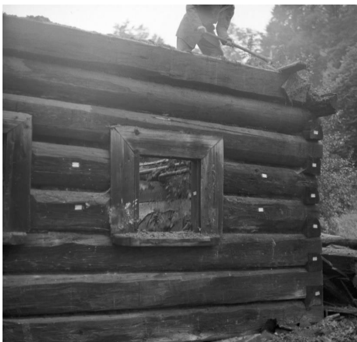
Obr. 5.1.189: Původní umístění prvku 95 před rozebráním objektu.
