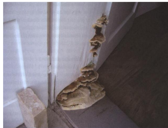
Obr. 3.7.2.1.2 Dřevomorka (Ptáček, 2009). (Ptáček, 2009).
