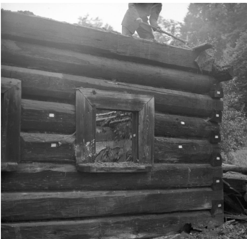
Obr. 5.1.194: Původní umístění prvku 96 před rozebráním objektu.
