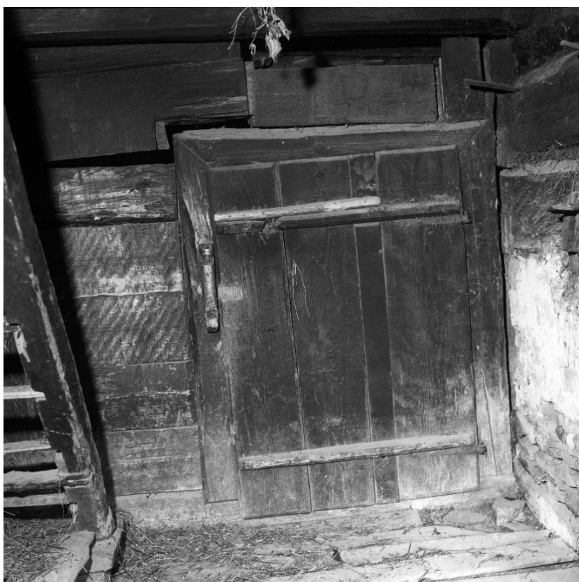
Obr. 5.1.279: Původní umístění prvku 141 před rozebráním objektu.
