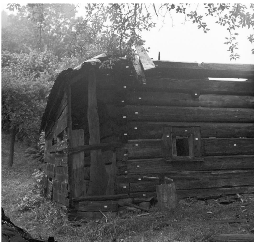
Obr. 5.1.44: Původní umístění prvku 15 před rozebráním objektu.
