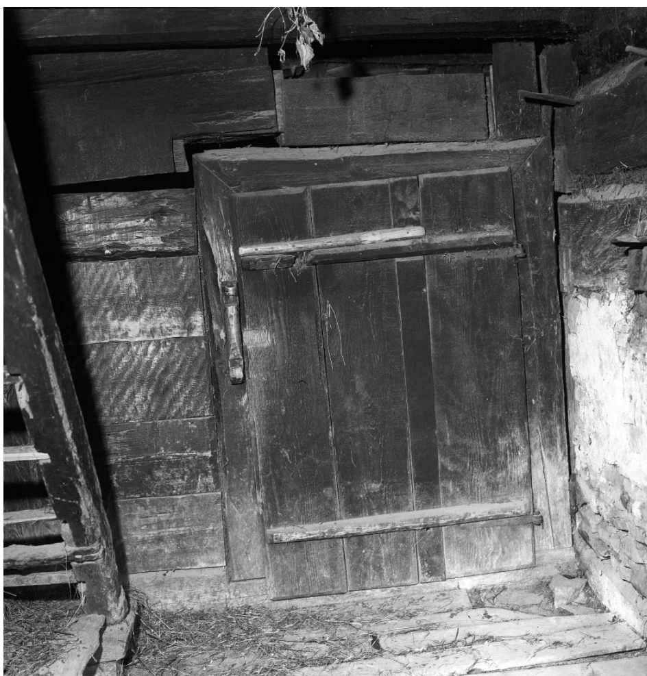
Obr. 5.1.259: Původní umístění prvku 136 před rozebráním objektu.
