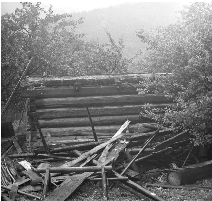
Obr. 5.1.206: Původní umístění prvku 106 před rozebráním objektu.
