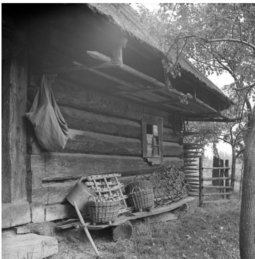
Obr. 5.1.136: Původní umístění prvku 58 před rozebráním objektu.
