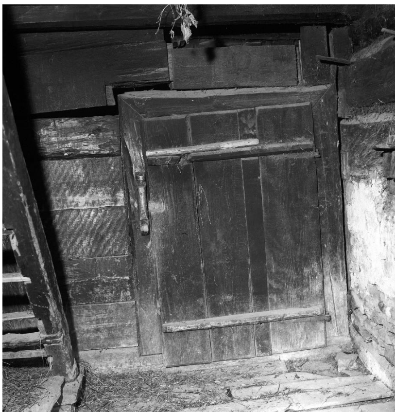
Obr. 5.1.245: Původní umístění prvku 132 před rozebráním objektu.
