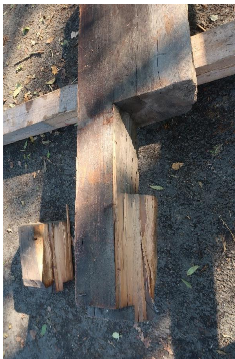
Obr. 3.9.5: Odlomení části prvku.
