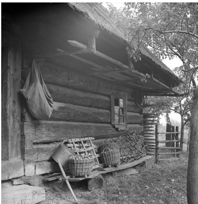
Obr. 5.1.131: Původní umístění prvku 57 před rozebráním objektu.
