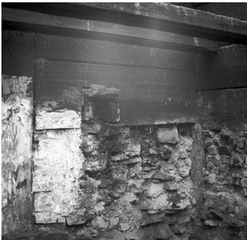
Obr. 5.1.228: Původní umístění prvku 120 B před rozebráním objektu.
