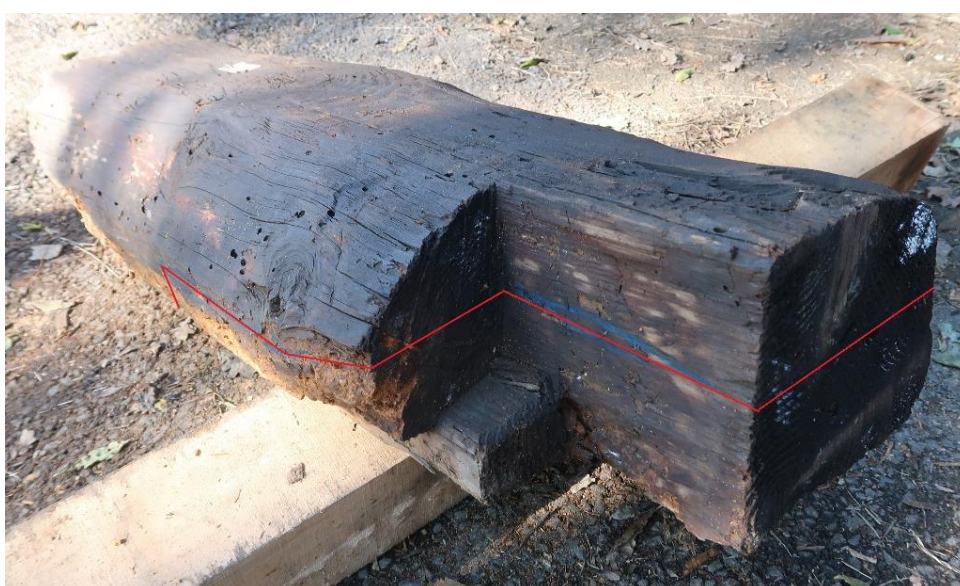
Obr. 5.1.190: Detail označení místa konstrukční sanace – vložka 0,55 m.
