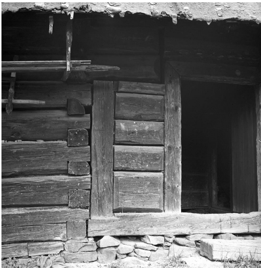
Obr. 5.1.83: Původní umístění prvku 33 před rozebráním objektu.
