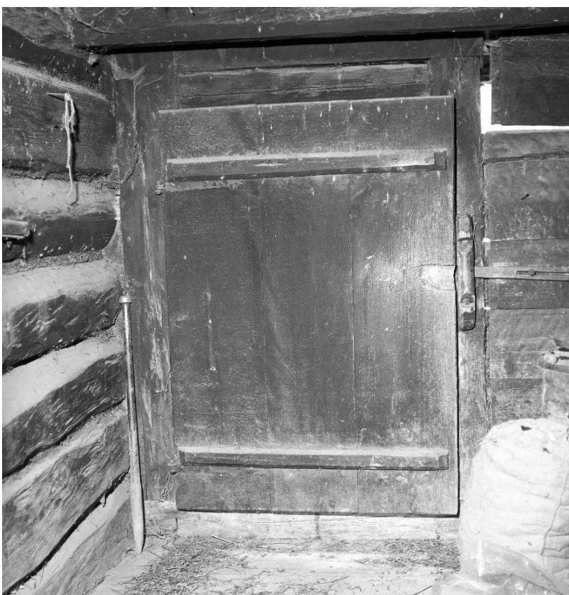
Obr. 5.1.232: Původní umístění prvku 122 před rozebráním objektu.
