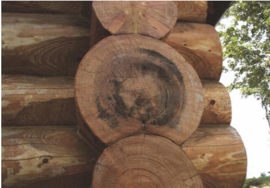
Obr. 3.7.1.1: Dřevo-zbarvující houba pod silnou lazurou (Ptáček, 2009).
