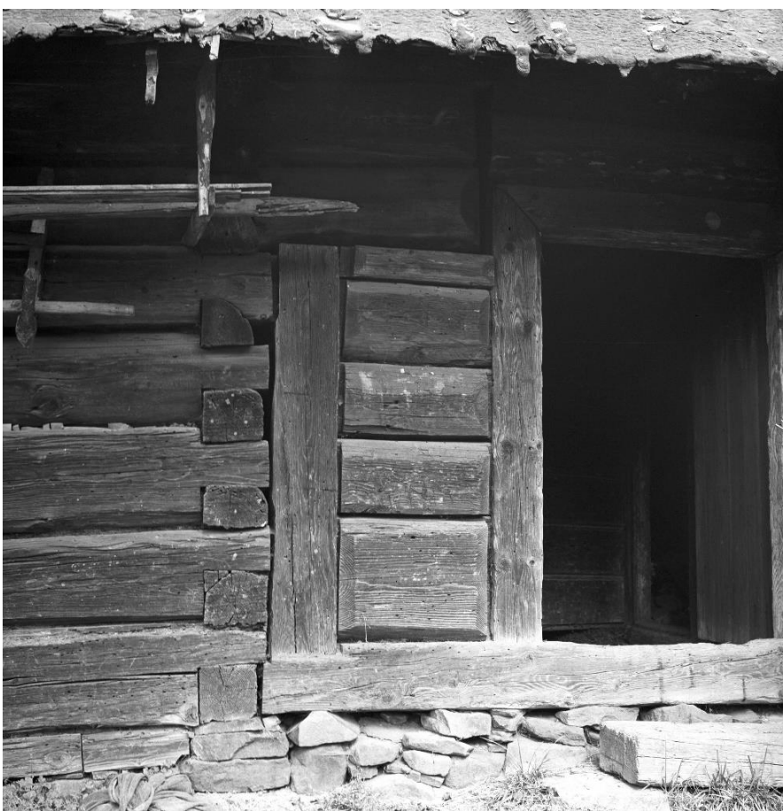
Obr. 5.1.95: Původní umístění prvku 37 před rozebráním objektu.
