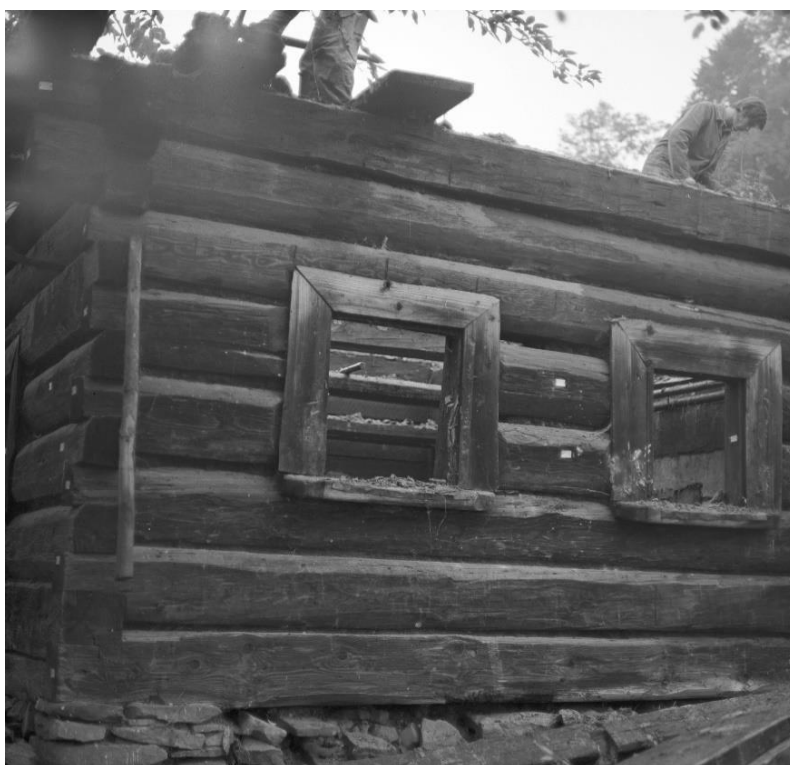
Obr. 5.1.177: Původní umístění prvku 89 před rozebráním objektu.
