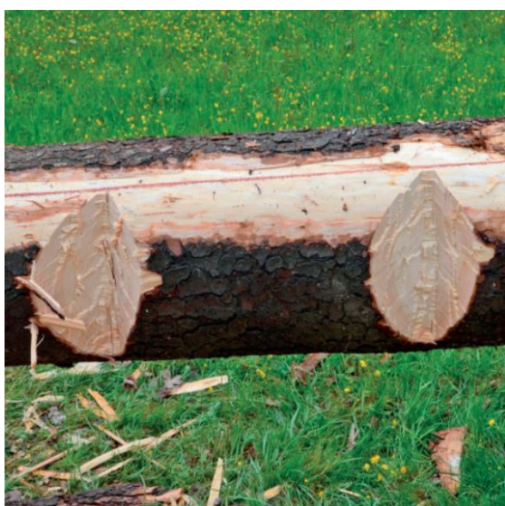
Obr. 3.4.1.2: Vytínané vruby (Kloiber a kol., 2020).
