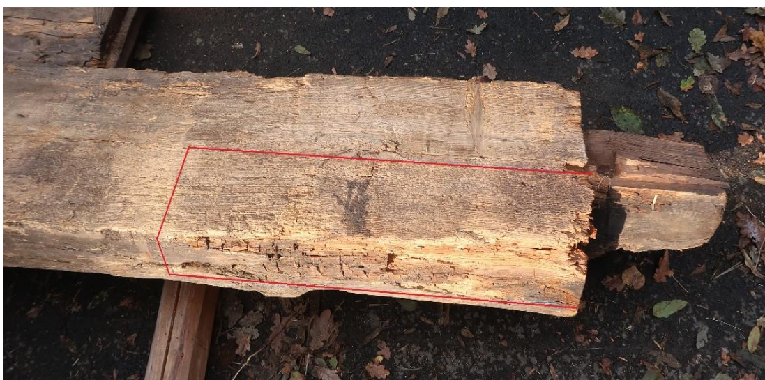
Obr. 5.1.6: Detail označení místa konstrukční sanace – vložka 1,0 m.
