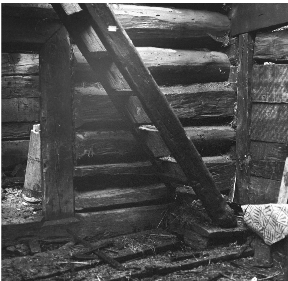
Obr. 5.1.48: Původní umístění prvku 19 před rozebráním objektu.
