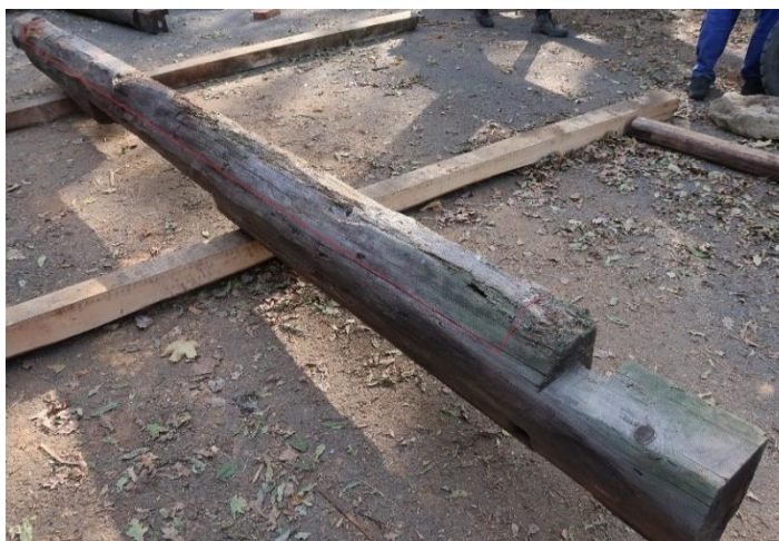
Obr. 5.1.62: Detail označení místa konstrukční sanace – vložka 4,0 m.
