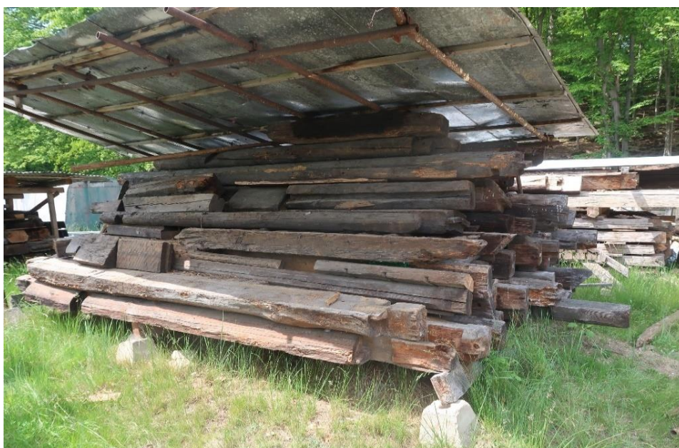
Obr. 4.3.1: Uskladněné prvky pod dočasným přístřeškem.
