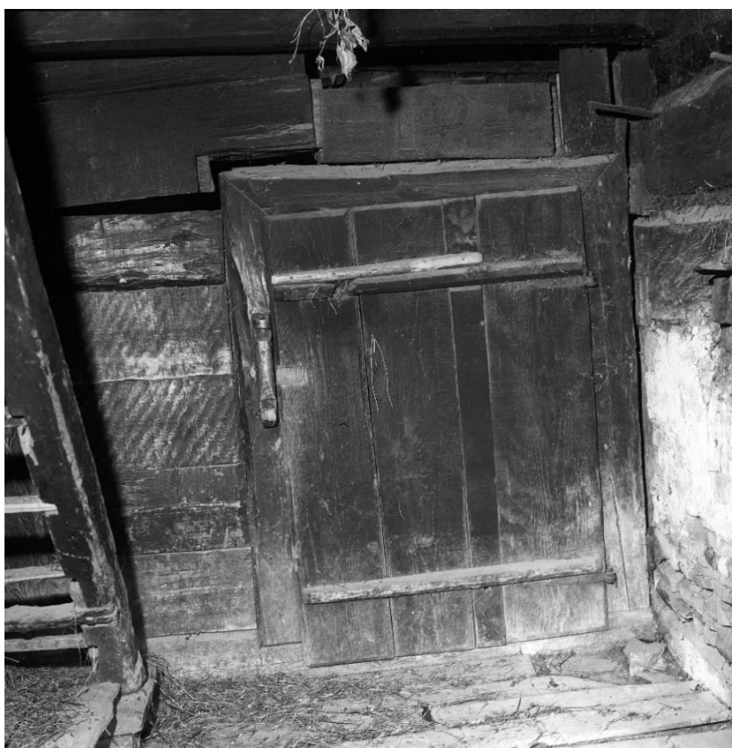
Obr. 5.1.267: Původní umístění prvku 138 před rozebráním objektu.
