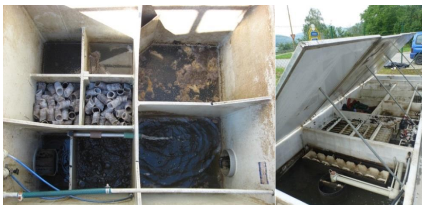
Obr. 4.4a, b. Pohled na jednotlivé sekce anaerobně-aerobních ČOV (a – pro 5 EO, b – pro 200 EO)
