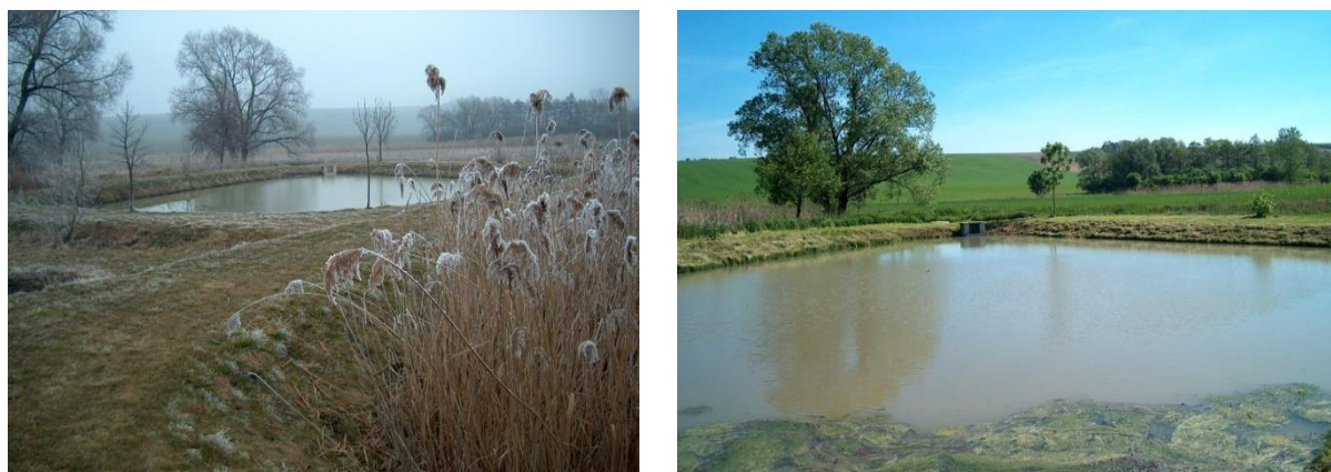
Obr. 3.4a, b. Pohled na dočišťovací nádrž ČOV Dražovice
