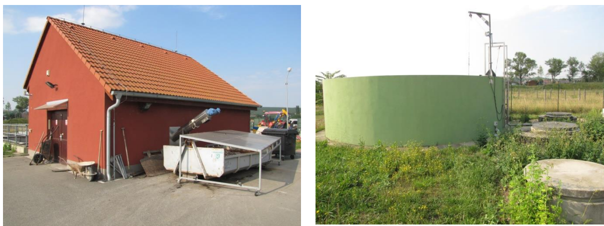
Obr. 3.8a, b. Provozní budova s kalolísem a transportním kontejnerem na kal (a) a pohled na kruhový kalojem (b) ČOV Starovice
