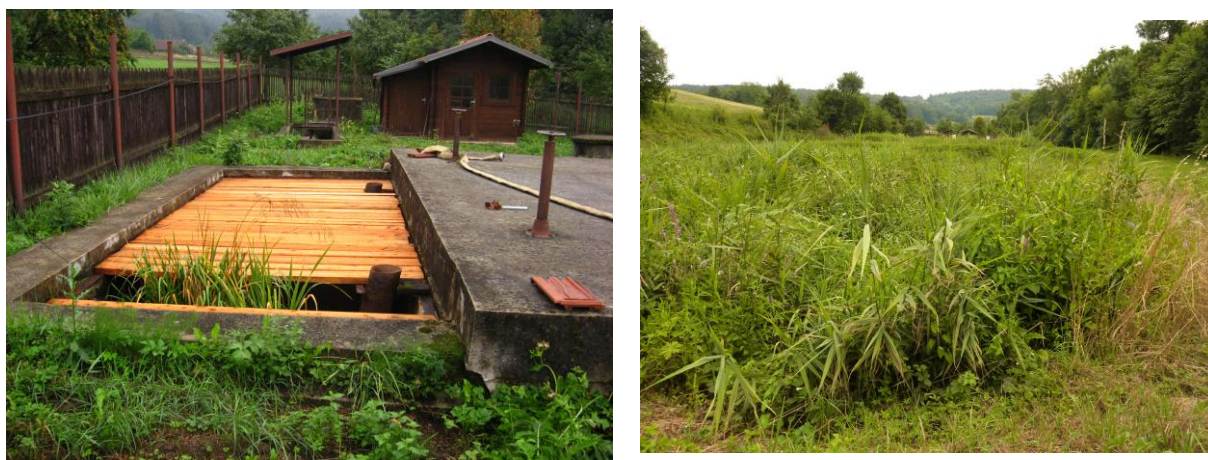
Obr. 3.6.a, b. Pohled na mechanické předčištění a kořenové filtry ČOV Hostětín
