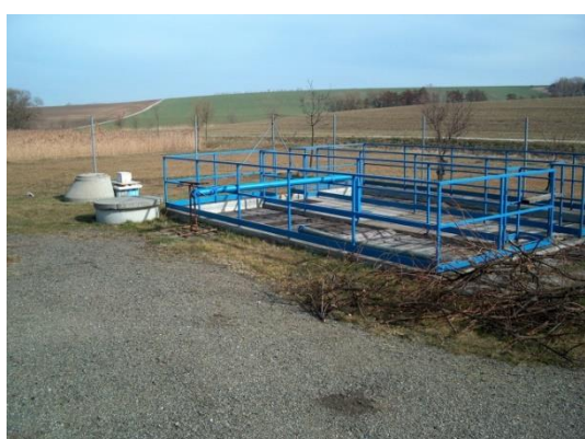
Obr. 3.3a, b, c, d. Kořenová čistírna Dražovice (a – dešťová usazovací nádrž, b – česle a lapák písku, c – štěrbinová usazovací nádrž, d – rozdělovací šachtice na přítoku na kořenové filtry)
