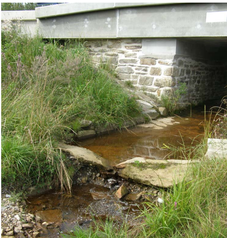
Foto 4. Kaplice nádraží (KAP) – můstek na konci štěrkové cesty podél trati
