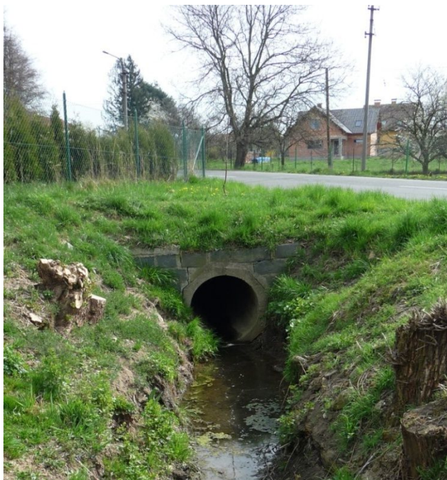
Obr. 33 Foto objektu Propustek 1
