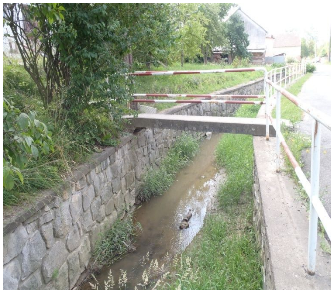
Obr. 29 Foto objektu Most 3A [1]
