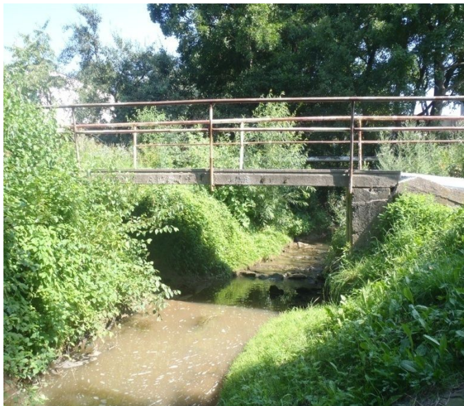
Obr. 19 Foto objektu Most1 [1]
