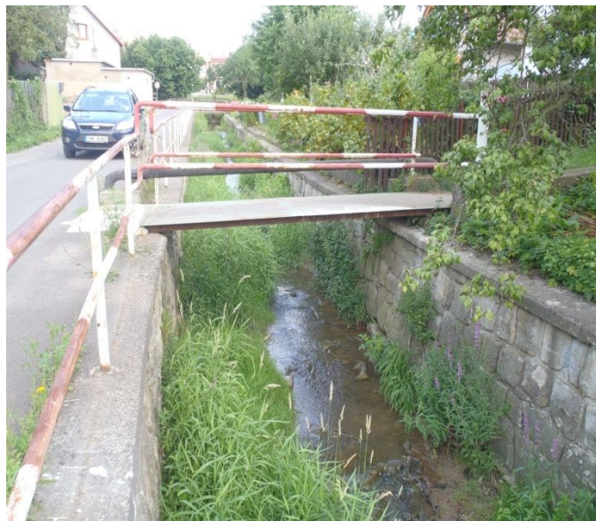
Obr. 27 Foto objektu Most 3 [1]
