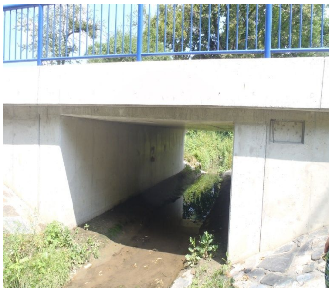
Obr. 31 Foto objektu Most 7 [1]
