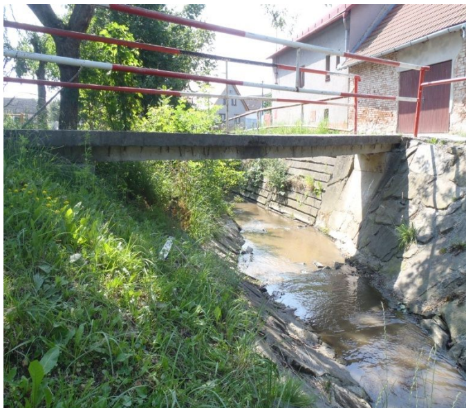
Obr. 21 Foto objektu Most 1A [1]
