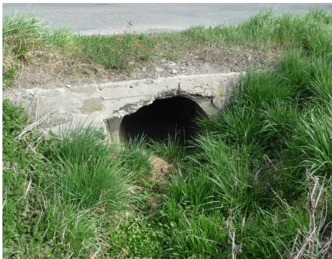
Obr. 34 Foto objektu Propustek 2
