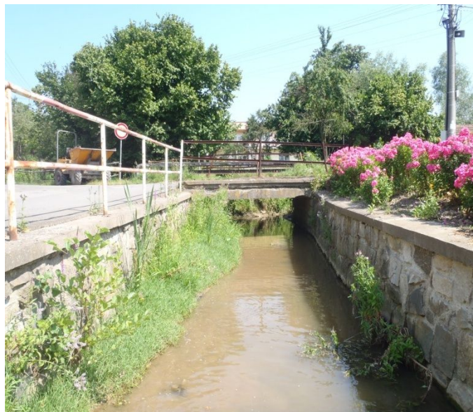
Obr. 25 Foto objektu Most 2 [1]
