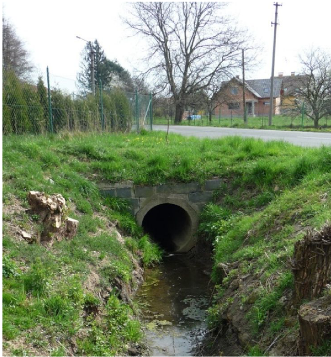
Obr. 33 Foto objektu Propustek 1
