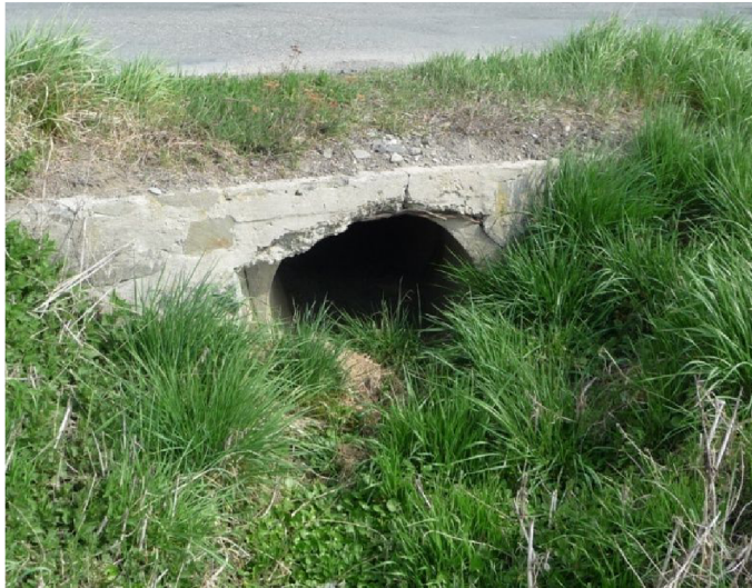
Obr. 34 Foto objektu Propustek 2
