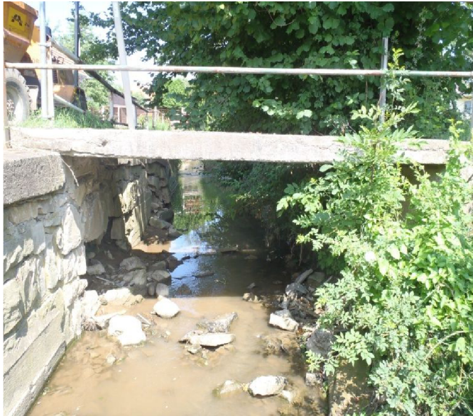
Obr. 23 Foto objektu Most 1B [1]
