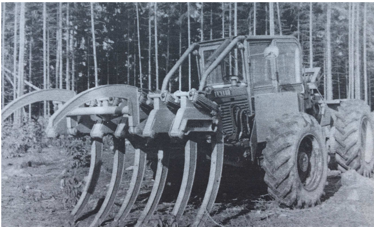
Obrázek 2: Lesnický kolový traktor s vidlicovým drapákem (Kysel, 1990).
