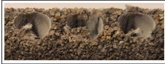
Obr.45 + 46 – „výstupní“ vzhled zhotovených otvorů – výraznější delaminace _ a _ detail
