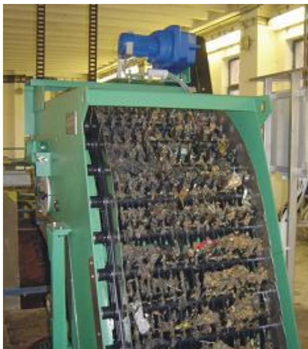
Obrázek č.: 5 Mechanické samočistící česle (FONTANA ©2021)
