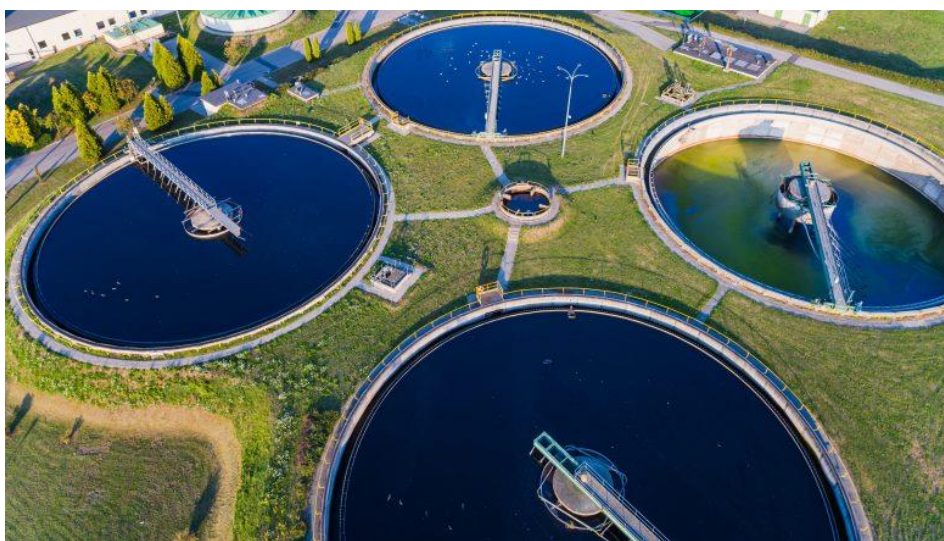
Obrázek č.: 6 Kruhové usazovací nádrže (WASSER ABWASSER TECHNIK, ©2019).
