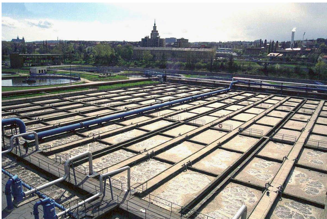
Obrázek č.: 7 Aktivační nádrže (Pražské vodovody a kanalizace, a.s. ©2021).
