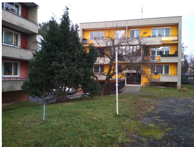
Obr. 3.1: Pohľad na sledovaný objekt z južnej strany
