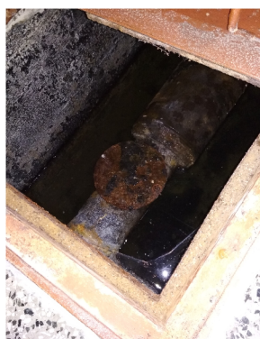
Obr. 3.2: Voda v šachte
