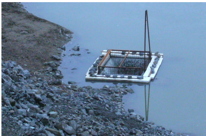
Obr. 6: Vybudovaná spodní výpust' rybníka Jordán (Řežábek, 2013). Foto: Pavel Řežábek.
