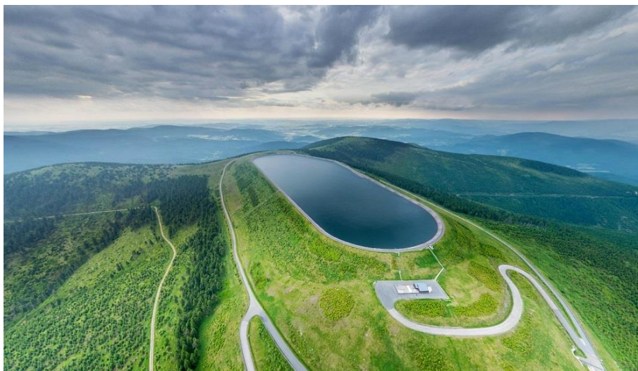
Obrázok 3-2 Prečerpávacía vodná elektrárneň Dlouhé Stráně 59
