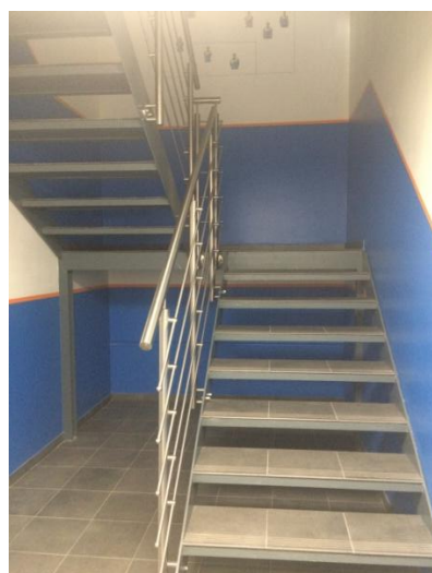
Obrázek 11. Únikové schodiště v zázemí
