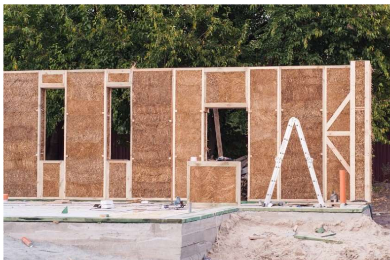
Obr. 4: Příklad slaměné izolace v panelu (Dřevostavitel, 2024)
