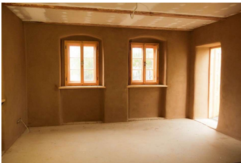
Obr. 18: Příklad skutečného provedení hliněné omítky (Přírodní řemeslníci, 2024)
