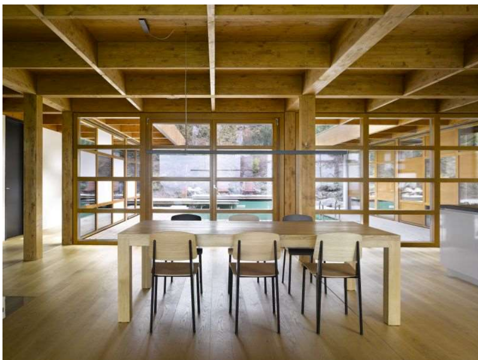
Obr. 10: Příklad těžké skeletové konstrukce z interiéru (Dřevo&stavby, 2024)
