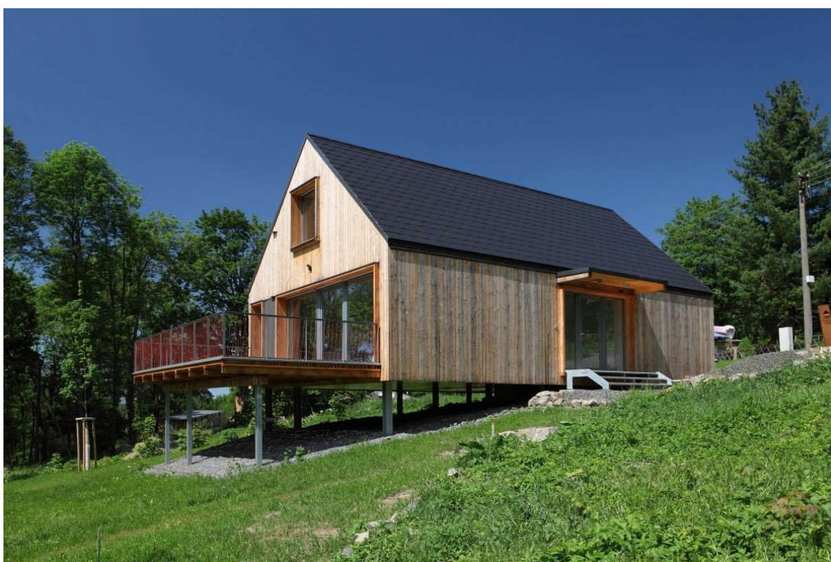
Obr. 6: Vykonzolovaná stavba pomocí zemních vrutů (Dřevostavitel, 2024)
