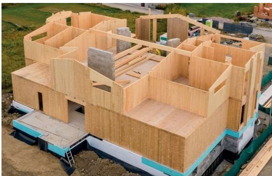
Obr. 11: Stavba z CLT panelů (Jafholz, 2024)
