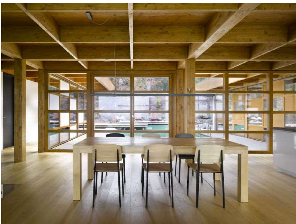
Obr. 10: Příklad těžké skeletové konstrukce z interiéru (Dřevo&stavby, 2024)
