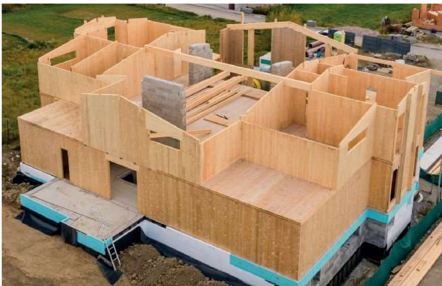
Obr. 11: Stavba z CLT panelů (Jafholz, 2024)
