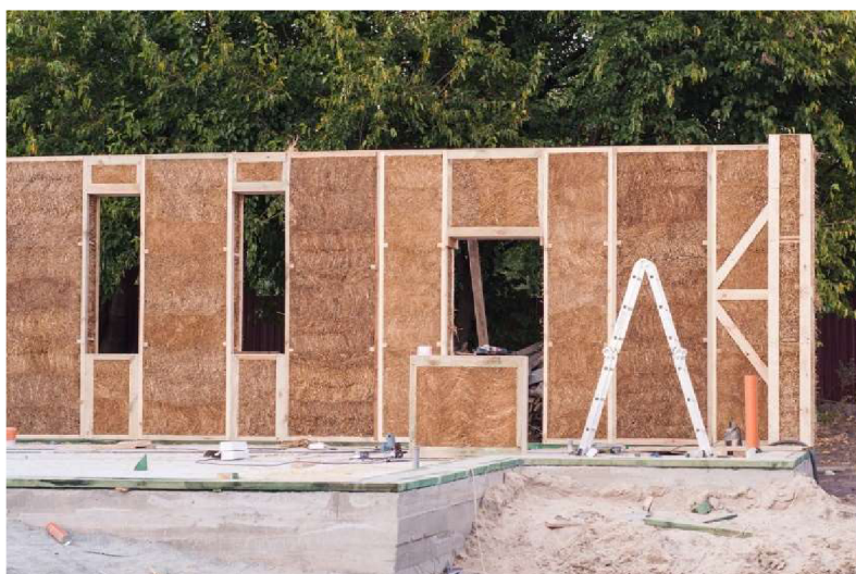
Obr. 4: Příklad slaměné izolace v panelu (Dřevostavitel, 2024)
