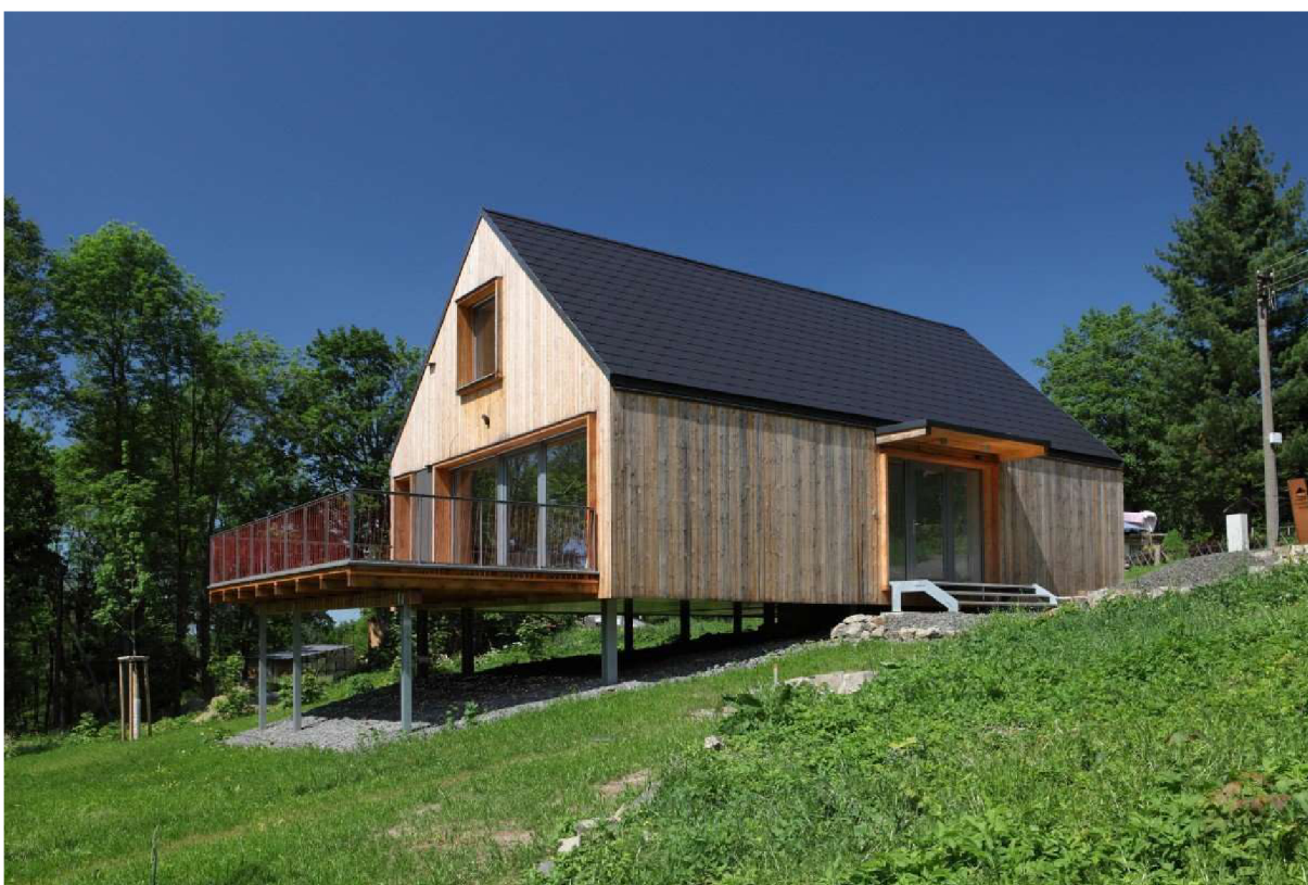
Obr. 6: Vykonzolovaná stavba pomocí zemních vrutů (Dřevostavitel, 2024)
