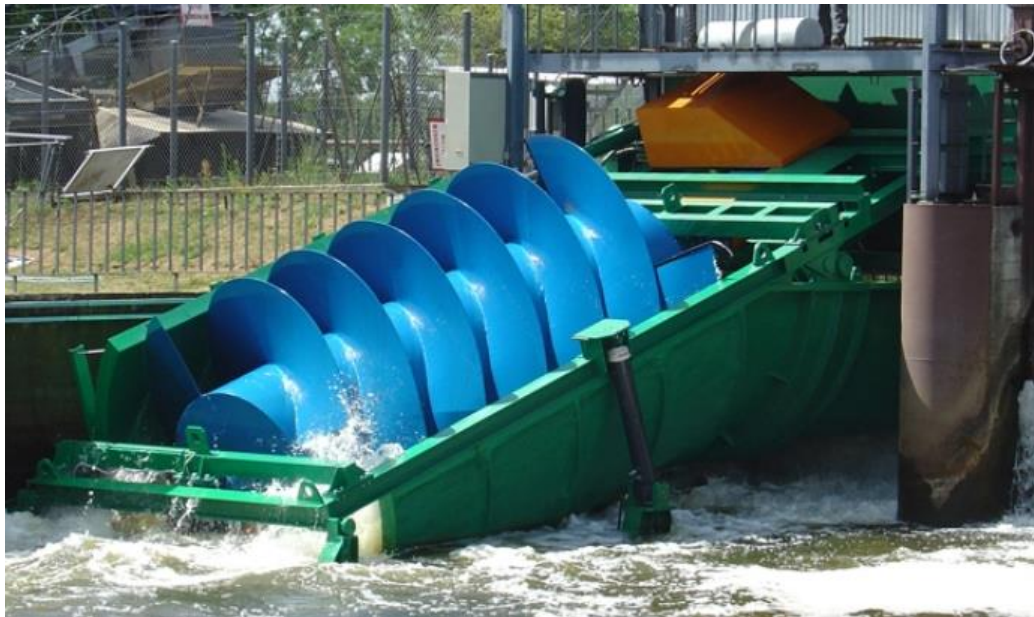
Obr. 6 Archimédův vodní motor [5]
