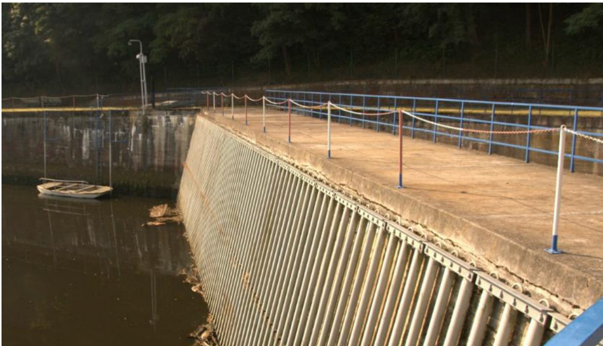
Obr. 9 Hrubé česle vodní elektrárny Štěchovice [3]
