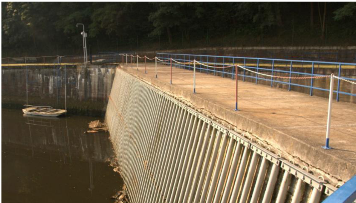
Obr. 9 Hrubé česle vodní elektrárny Štěchovice [3]
