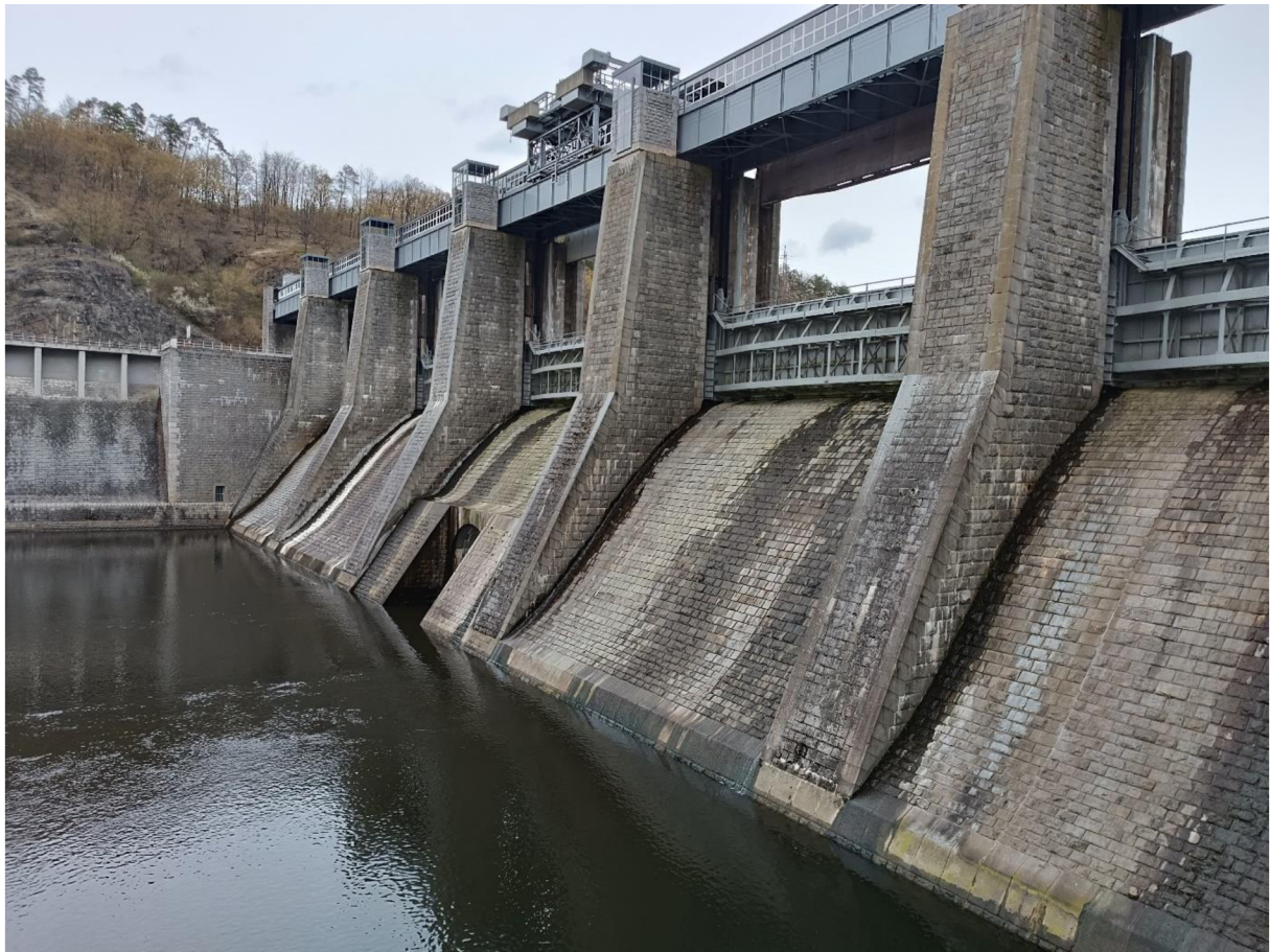
Obr. 11 Betonová hráz vodní elektrárna Štěchovice [vlastní]
