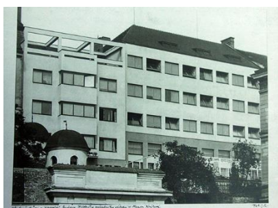
Obr. LXVII–A: „Obytný dům a kancelářská budova místního národního výboru v Hradci Králové“ (Fotoarchiv MVČ); Exteriér Městské spořitelny (Fotoarchiv MVČ)
