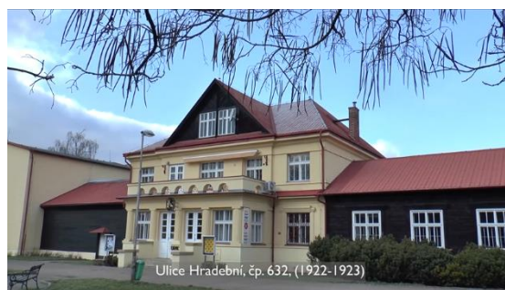
Obr. 42: Ukázka postaveného objektu – je zachycen na dobové fotografii obr. 41
