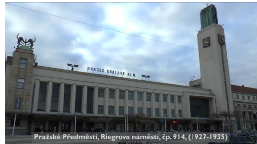
Obr. 40: Ukázka postaveného objektu, jehož kresba je na obr. 39
