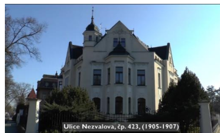
Obr. 38: Ukázka postaveného objektu, jehož návrh je na obr. 37 Zdroj: vlastní tvorba
