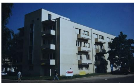
Obr. LXXV–A: „Obytná budova pro lékaře/ nyní transfúzní stanice“ (Fotoarchiv MVČ)
