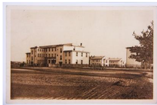
Obr. LXXIV–A: „Pohled na administrativní budovu“ (Hrůza, 2016, s. 59)
