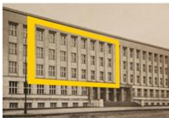
Obr. 69: Lizénové rámce na budově Krajského soudu
