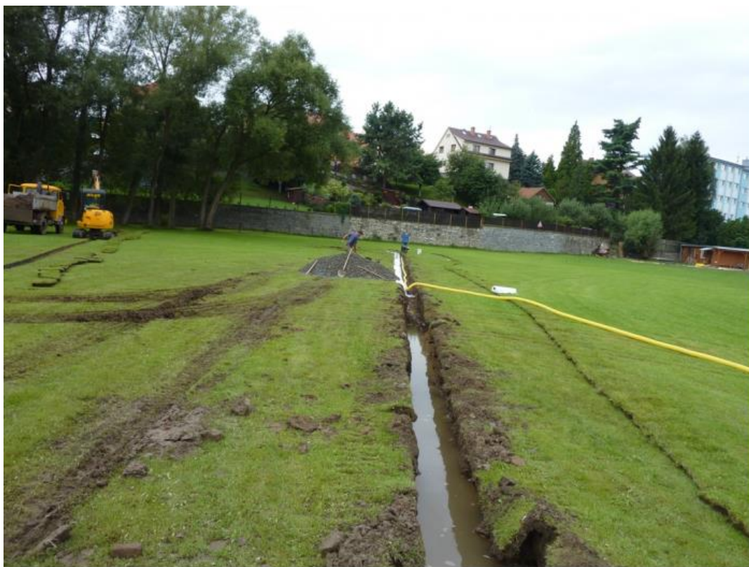
Obr. č. 1: Realizace odvodnění (SK Pegas, 2017)
