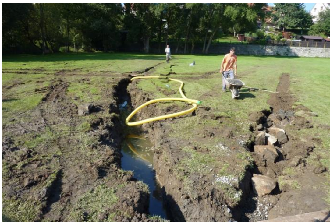
Obr. č. 2: Hladina vody ve výkopu (Sk Pegas, 2017)
