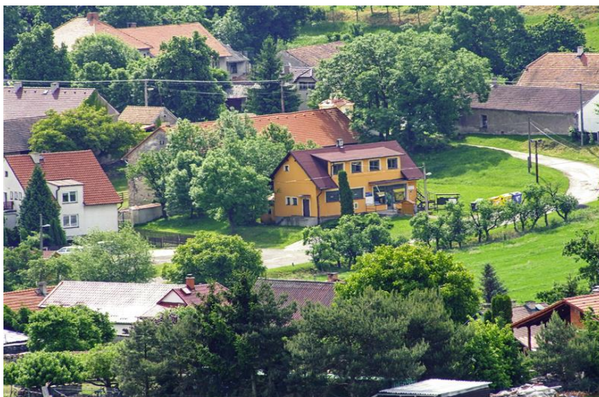
Obrázek 7: Pohled na budovu obecního úřadu
