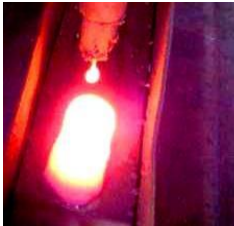
Obr. 10 Nanášení housenky elektrickým obloukem
