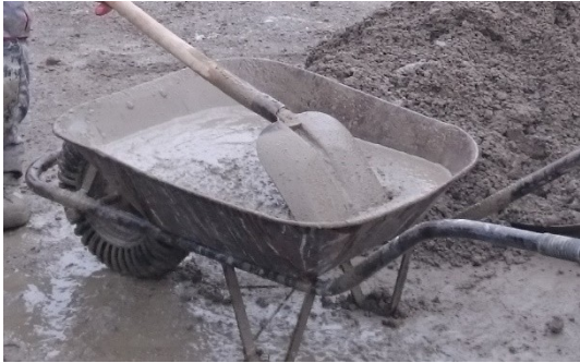
Ruční míchání betonové
