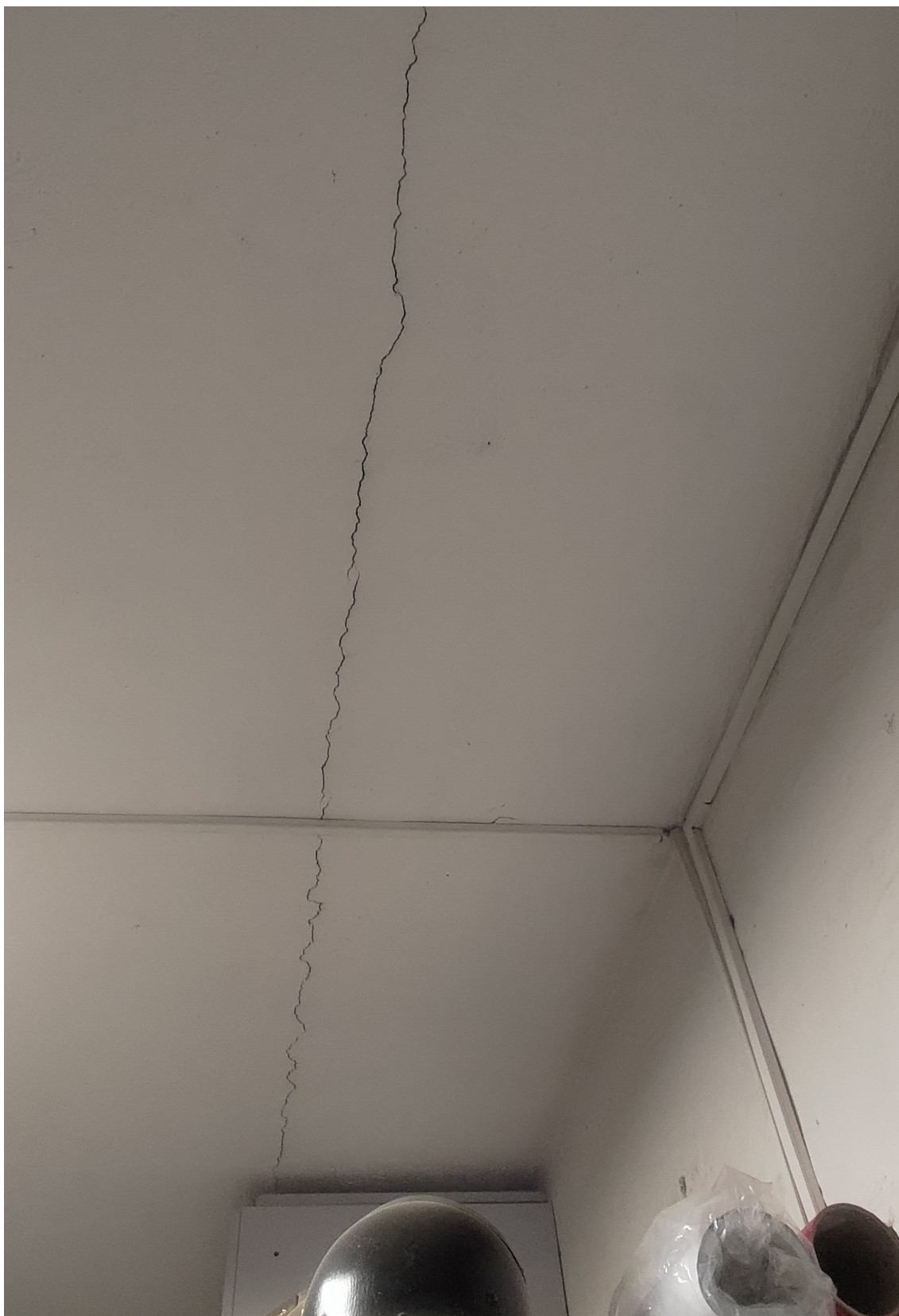
Obr. 4.12: Prokreslená spára mezi stropními panely v klubovně
