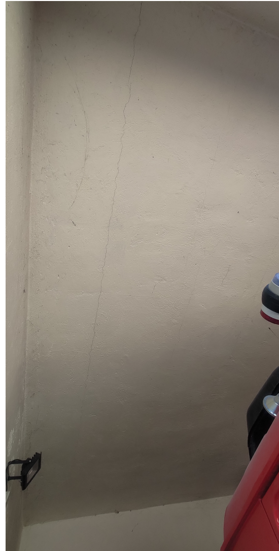
Obr. 4.11: Prokreslená spára podél severní zdi
