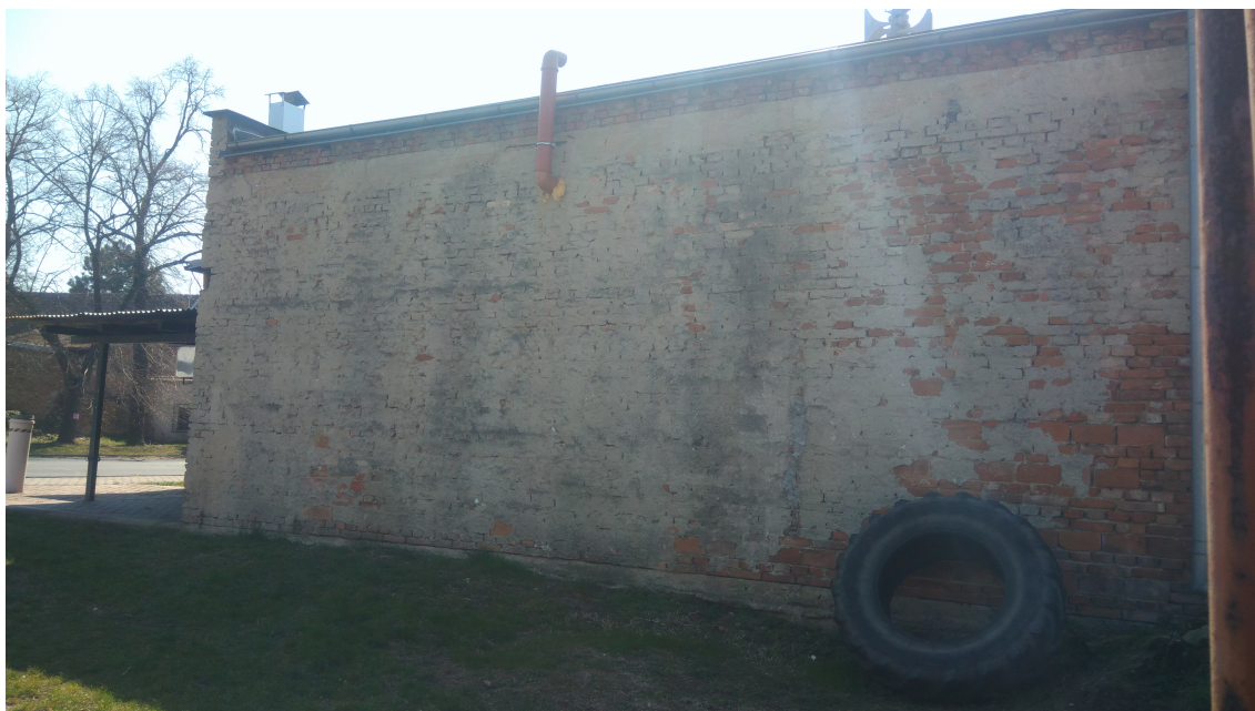
Obr. 4.5: Pohled na severní obvodovou stěnu
