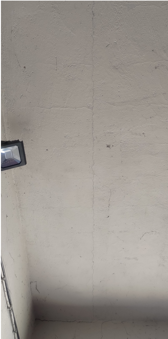
Obr. 4.10: Prokreslená spára podél šatny
