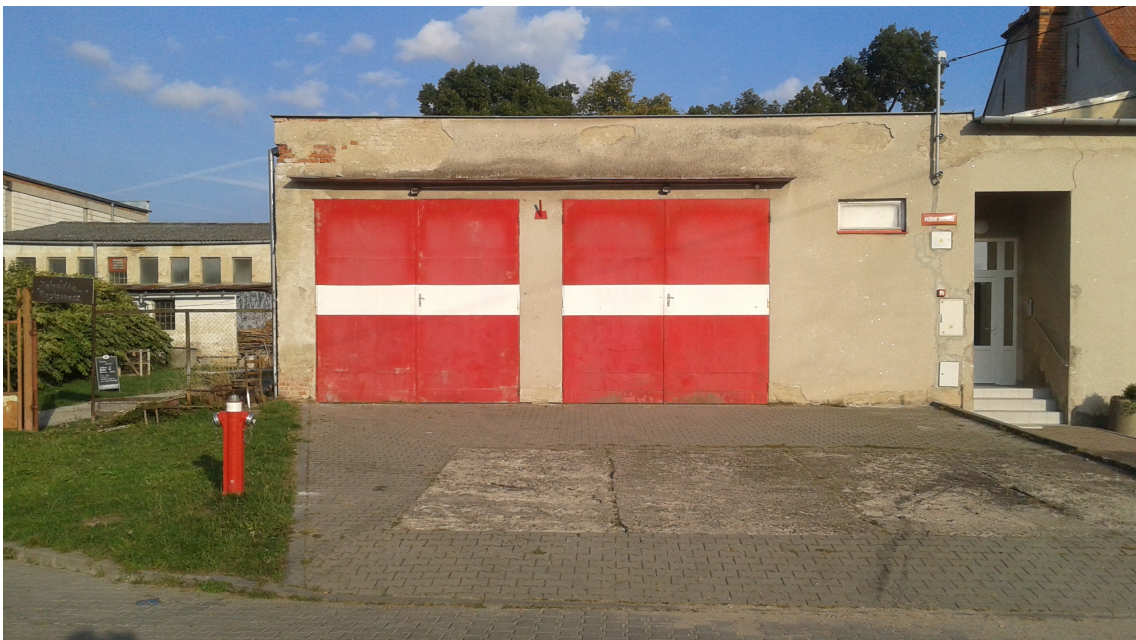
Obr. 4.3: Pohled na požární zbrojnicí před opravou uliční fasády z roku 2015
