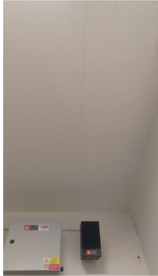
Obr. 4.14: Prokreslená spára mezi stropními panely v šatně
