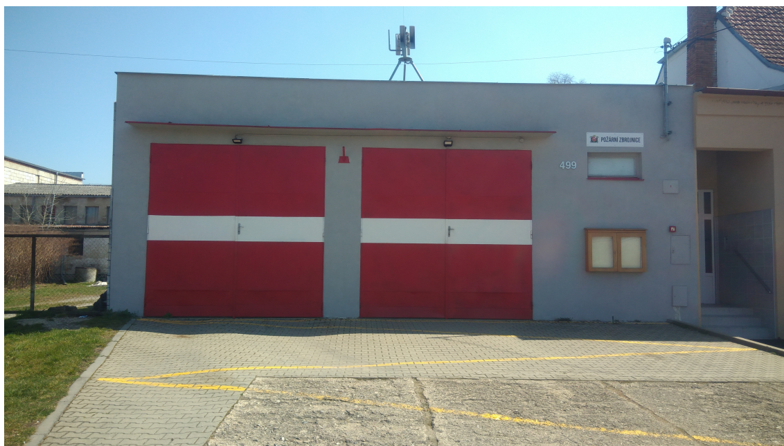
Obr. 4.1: Pohled na zbrojnici
