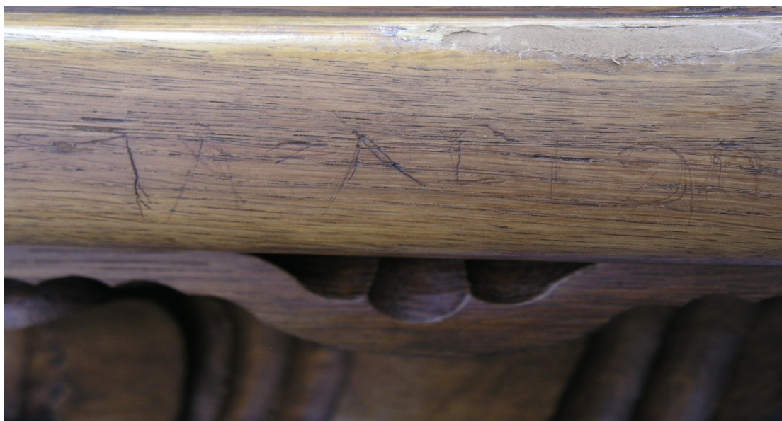
Obr. č. 29 Druhotné nápisy na římsách zábradlí 34
