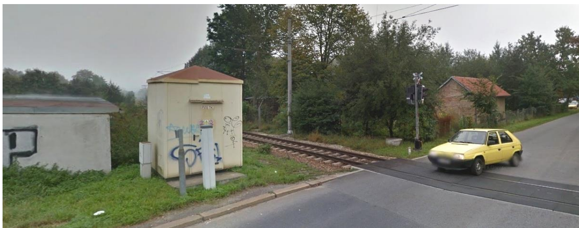
Obr. 35: Špatné rozhledové poměry u železniční zastávky České Budějovice jižní zastávka Zdroj: Google Street View (©2016), vlastní zpracování
