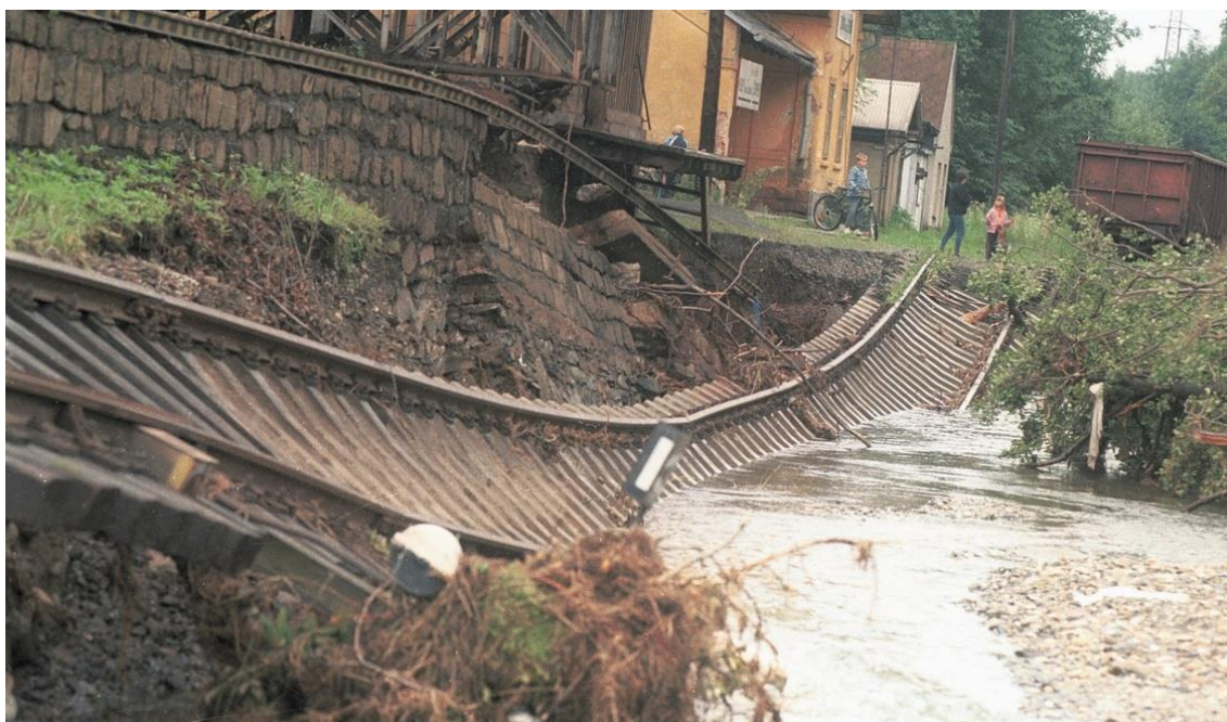
Obr. 22: Trať 293 z Kout nad Desnou do Šumperka zničená povodní v roce 1997
