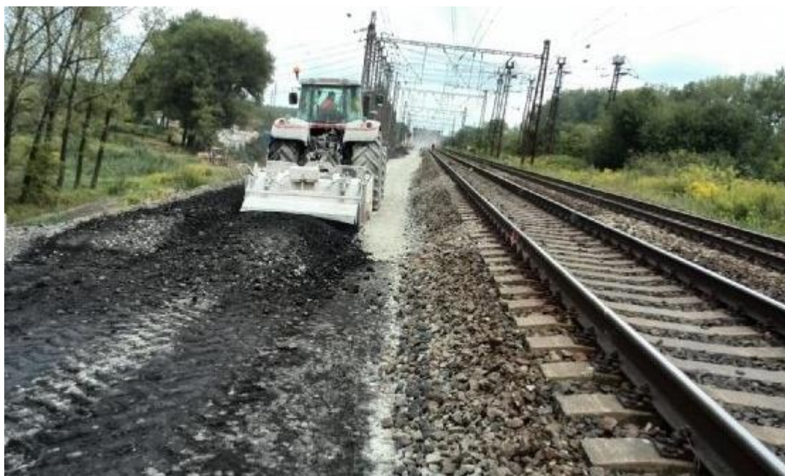
Obr. 34: Modernizace úseku Praha-Běchovice – Úvaly
