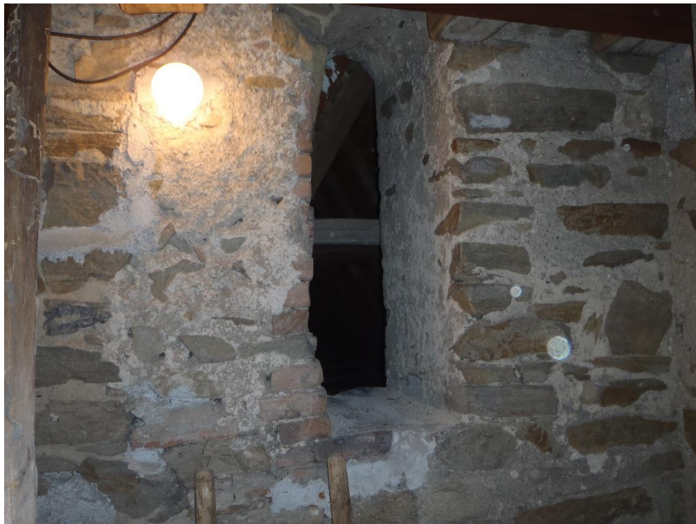
Obrázek 9 Vstup z věže nad klenbu lodi. Foto: archiv autora.
