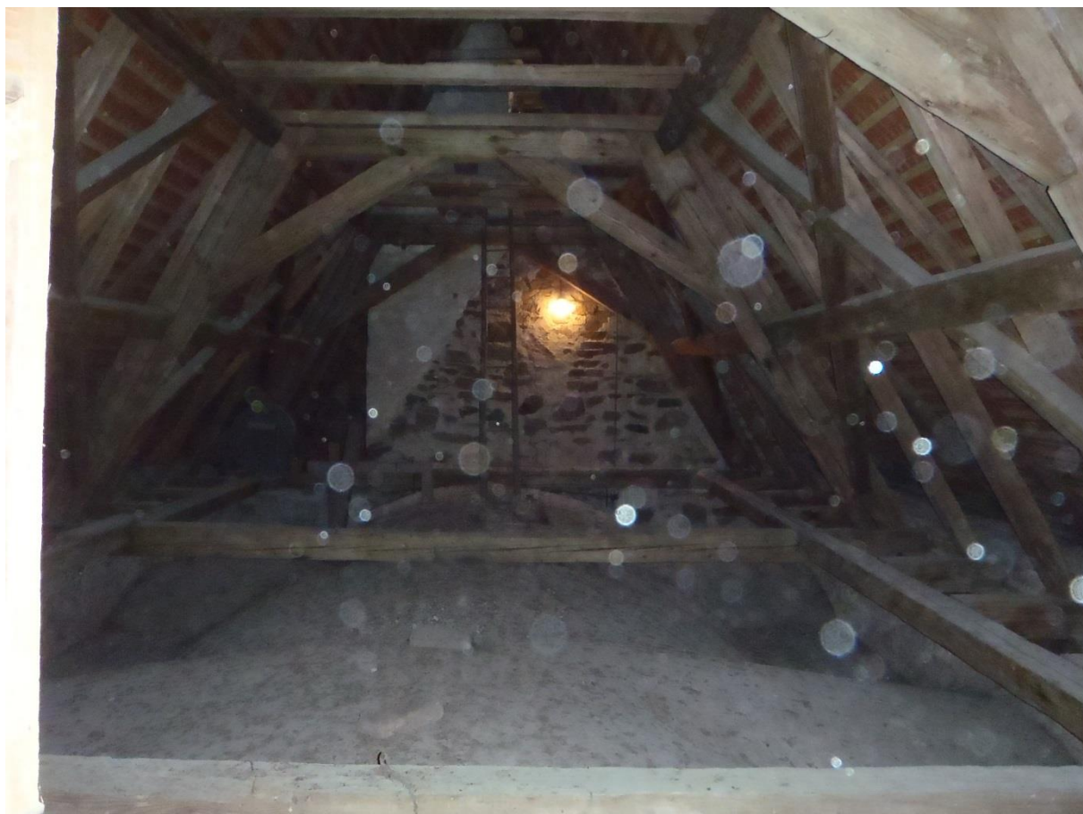
Obrázek 10 Krov nad lodí – jasně viditelné prvky vyspělého hambalkového krovu s ležatou stolicí. Foto: archiv autora.
