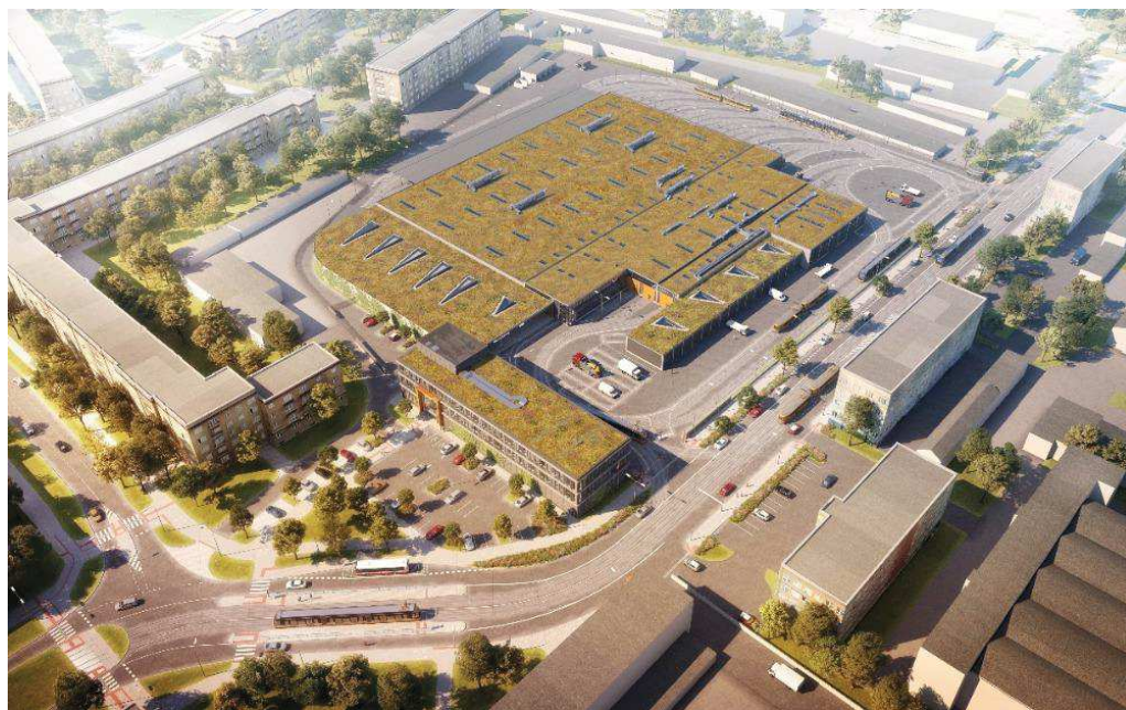
Obrázek 9 - Pohled na vegetační střechu tramvajové vozovny Plzeň 2 – Slovany
