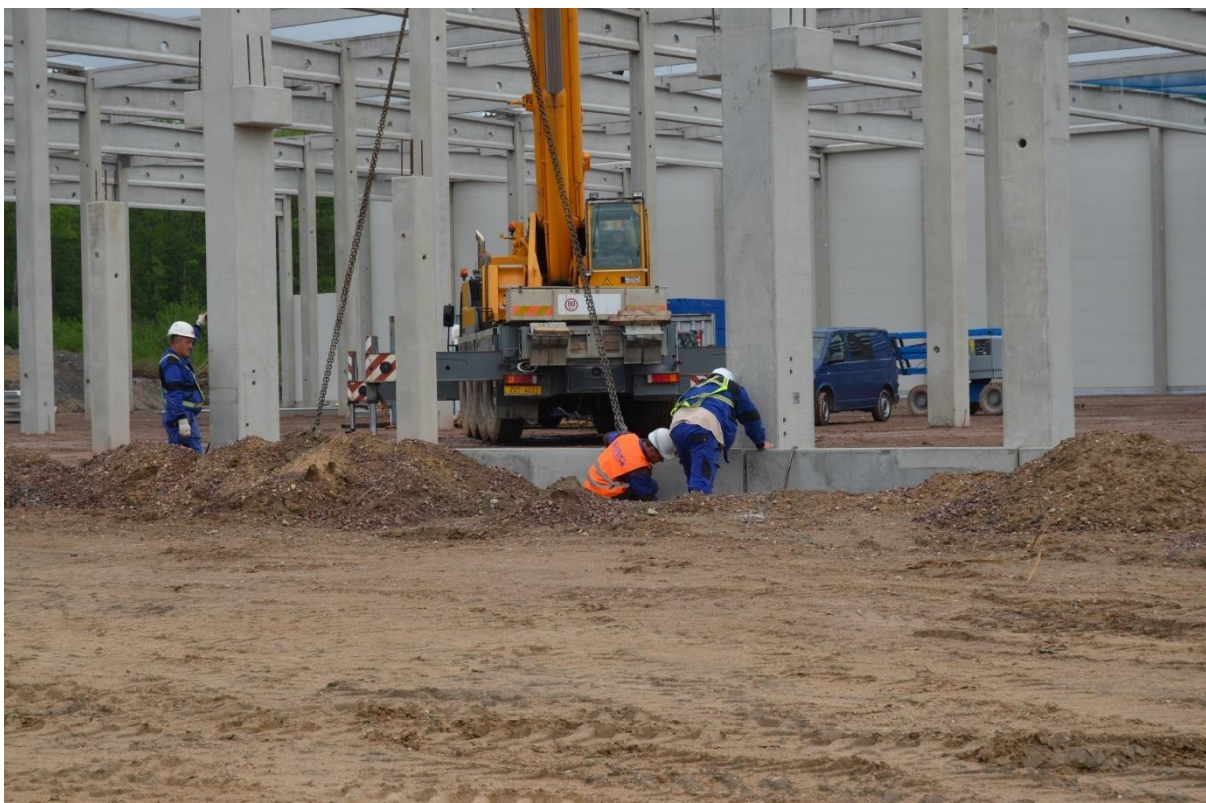
Obrázek 42 Osazení prahu [34]
