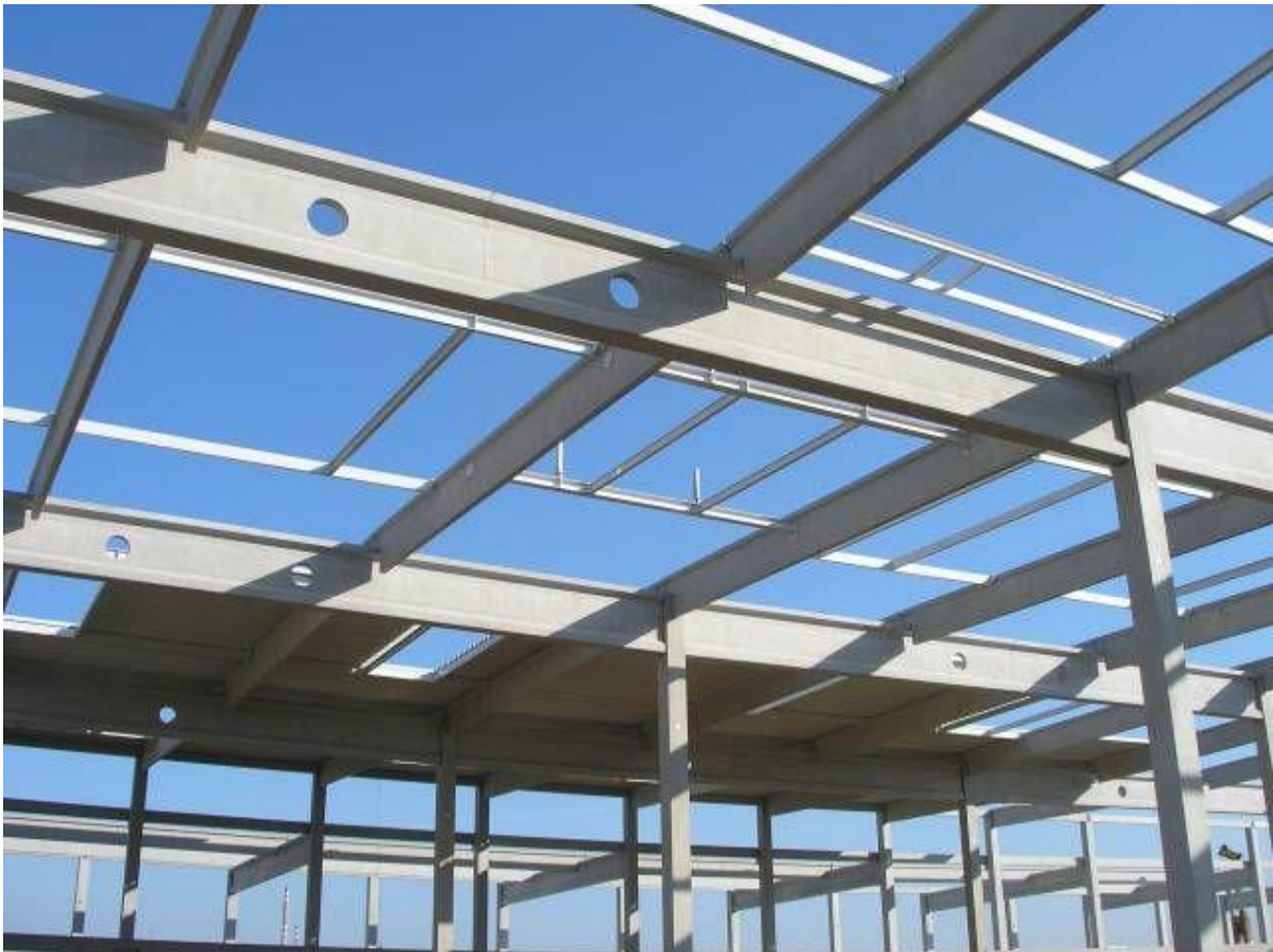
Obrázek 43 Osazení průvlaků [38]
