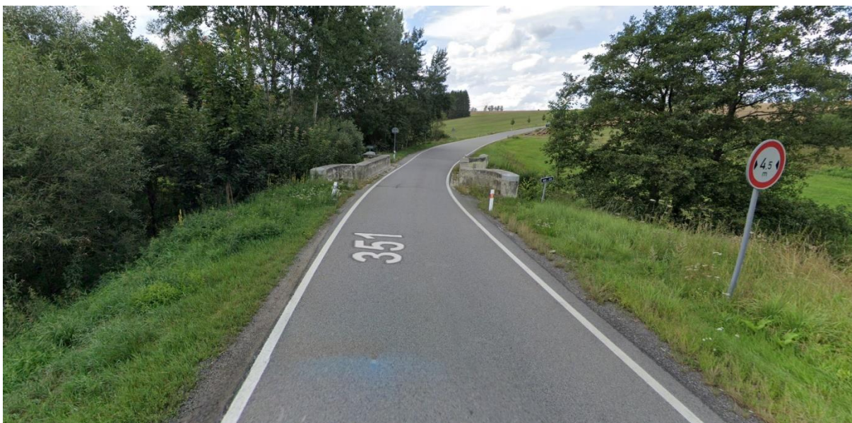
Obrázek 27 most č. 351-011 přes Skryšovský potok (upraveno autorem) [1]
