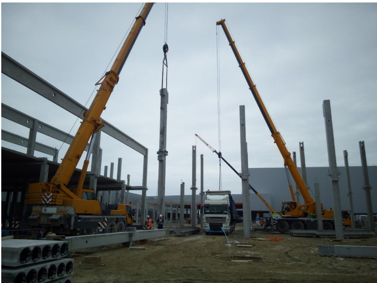
Obrázek 40 Osazení sloupu [29]
