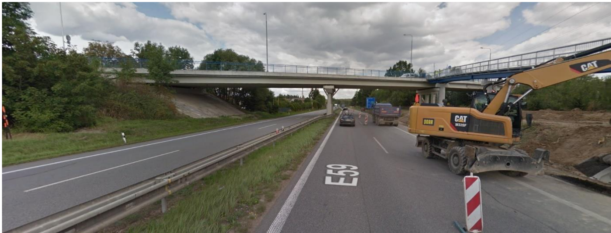
Obrázek 34 podjezd pod mostem 38-067b.2 (upraveno autorem) [1]
