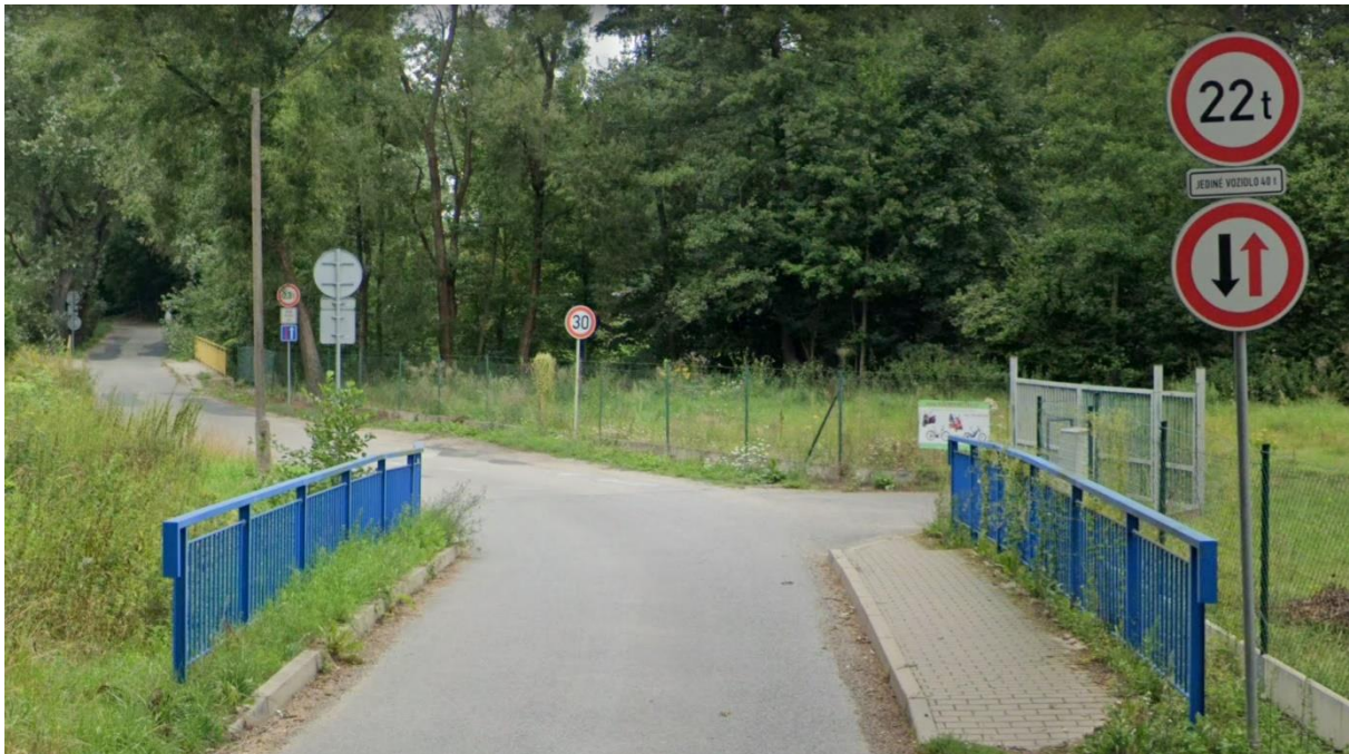
Obrázek 11 most č. HB-4023 v obci Havlíčkův Brod (upraveno autorem) [1]
