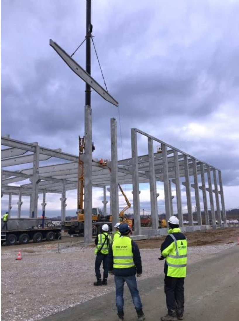
Obrázek 44 Osazení vazníku [42]
