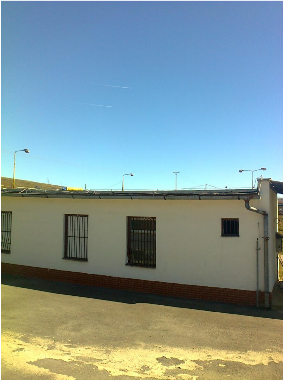
Obrázok č. 5: Termoizolácia strechy prevádzkovej budovy ČOV
