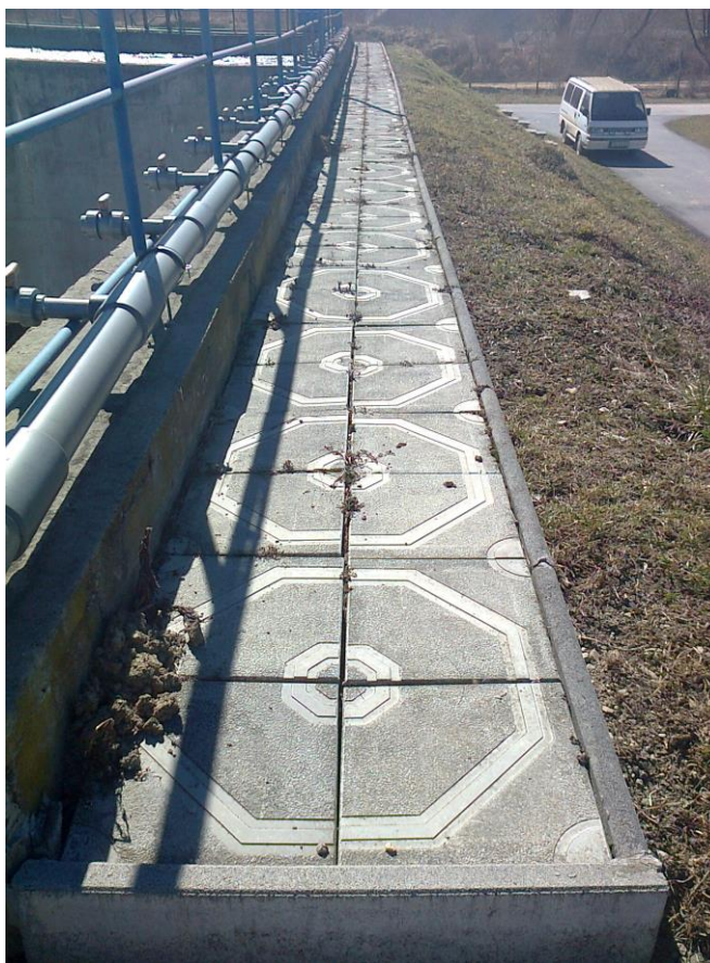
Obrázok č. 2: Uloženie betónových obrubníkov
