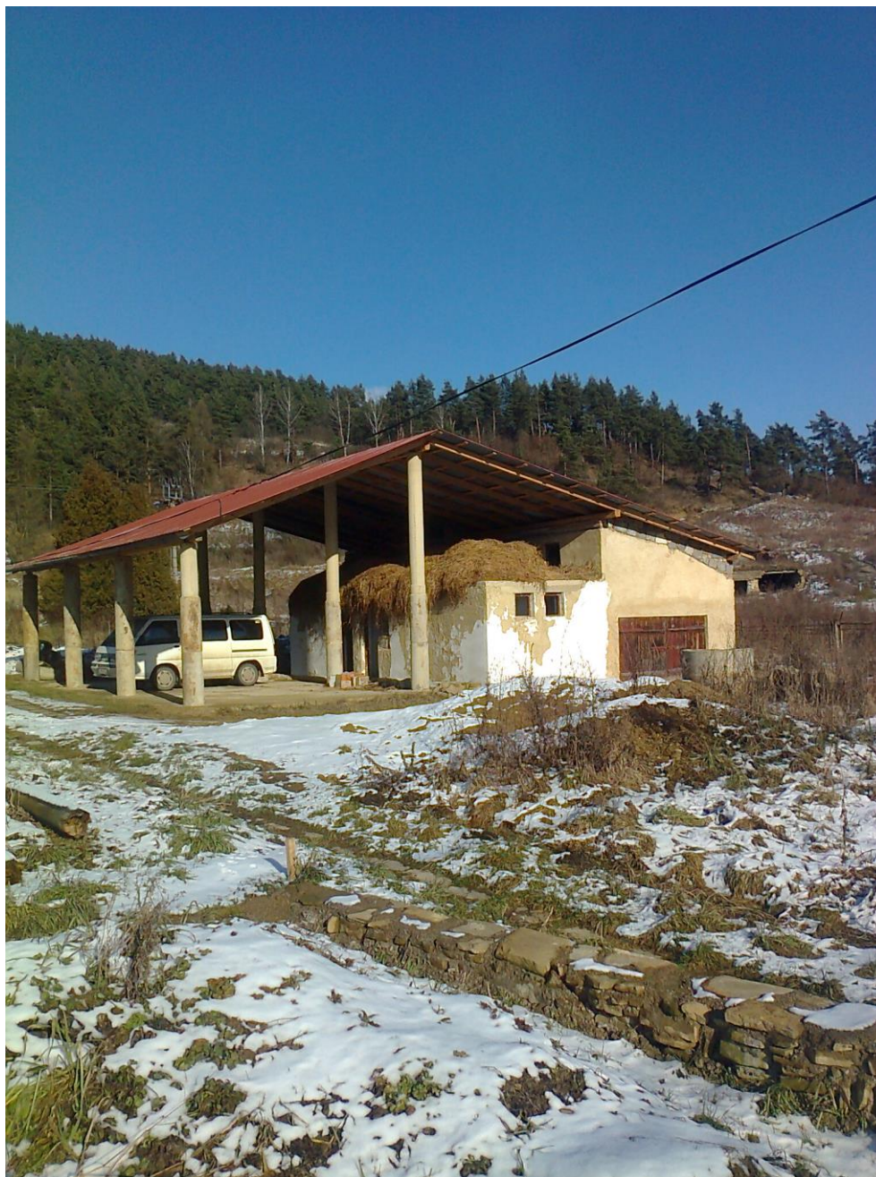
Obrázok č. 8: Prístavba sociálneho zariadenia a prestrešenie betónovej plochy
