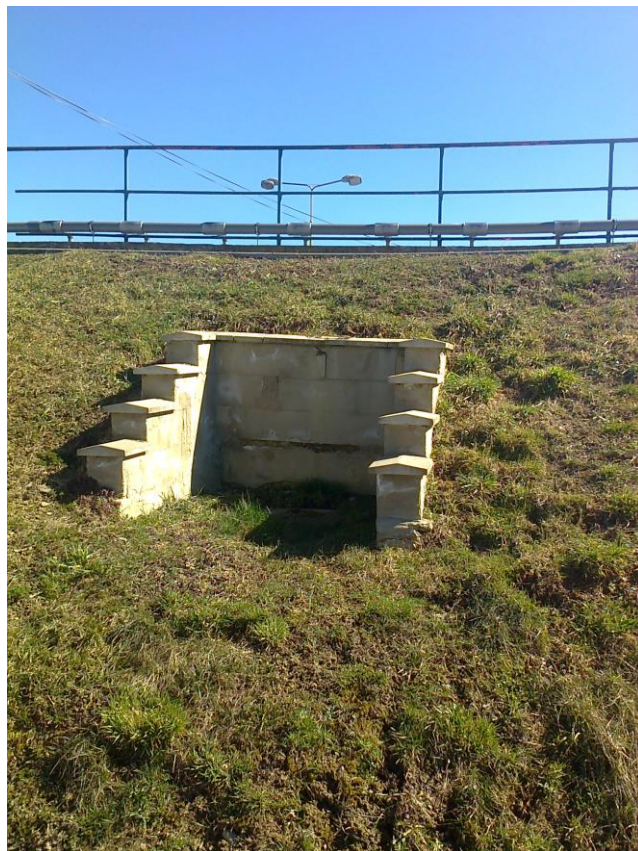
Obrázok č. 6: Obmúrovka kanalizačnej šachty
