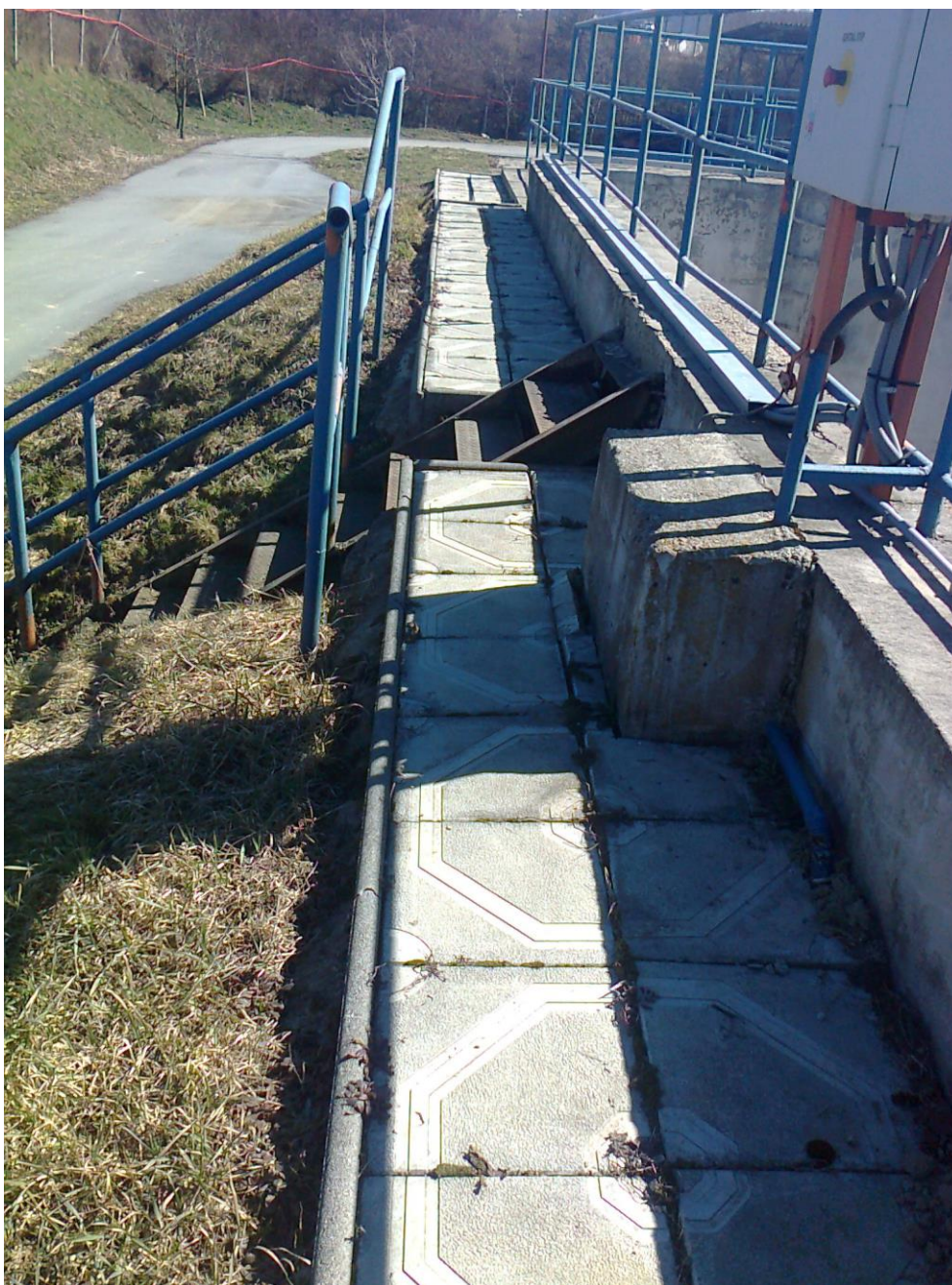
Obrázok č. 3: Uloženie chodníkovej betónovej dlažby
