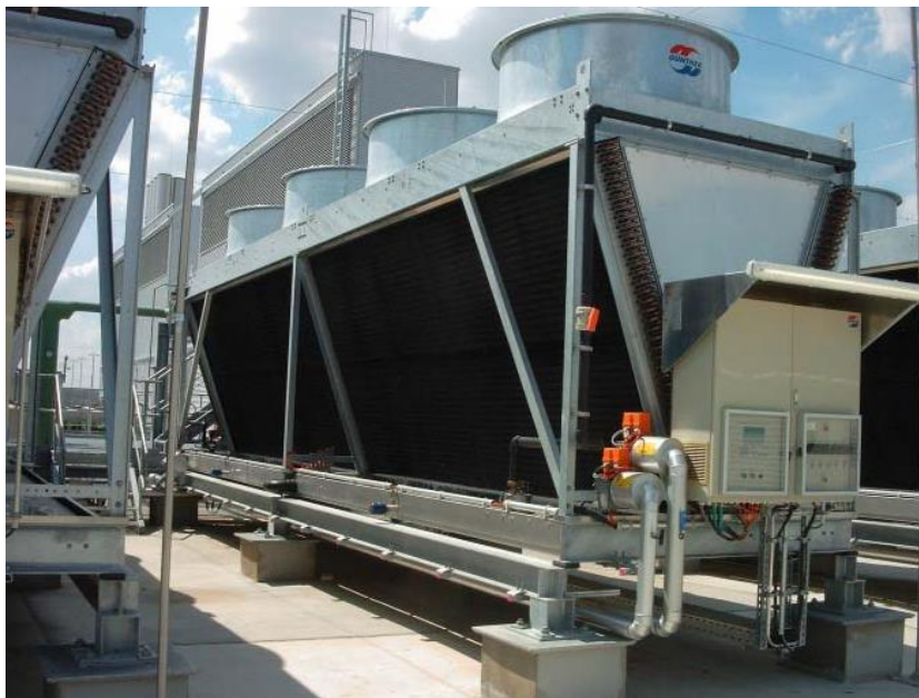
Obr. 4) Hybridní chladič a kondenzátor [11]
