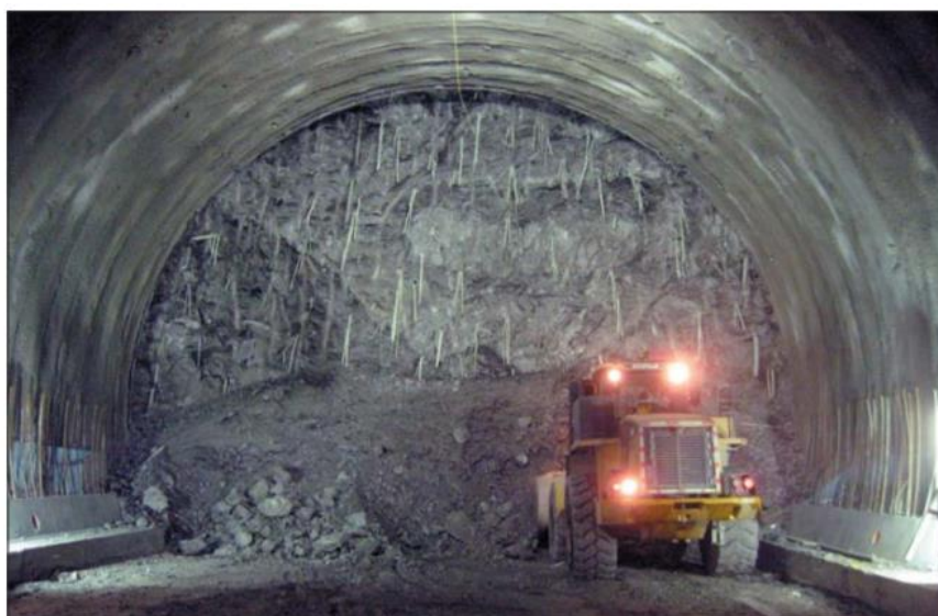
Obr. 5.8 Sklolaminátové horizontální kotvy [6]
