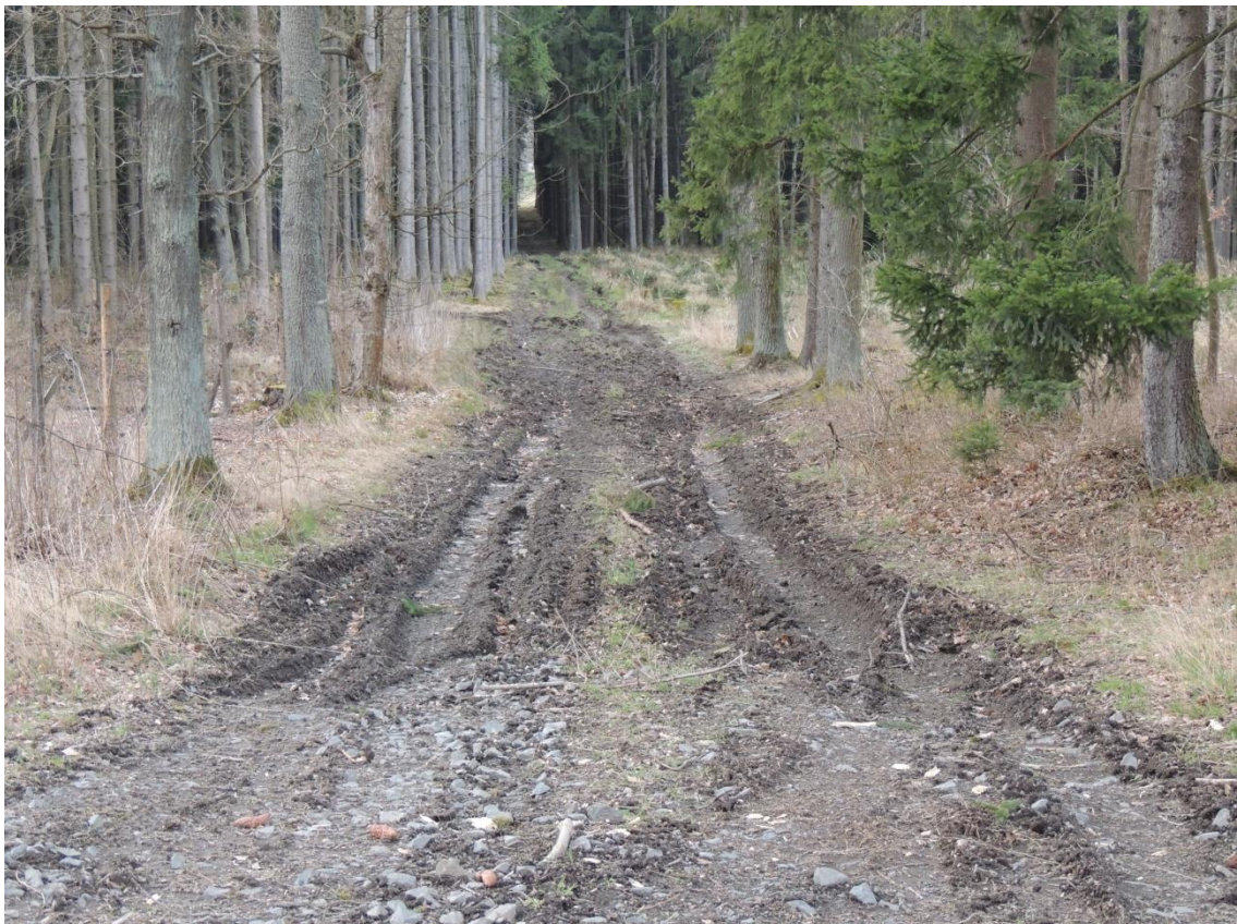
Obr.34 Pohled na lesní cestu těsně před rekonstrukcí část cesty 114
