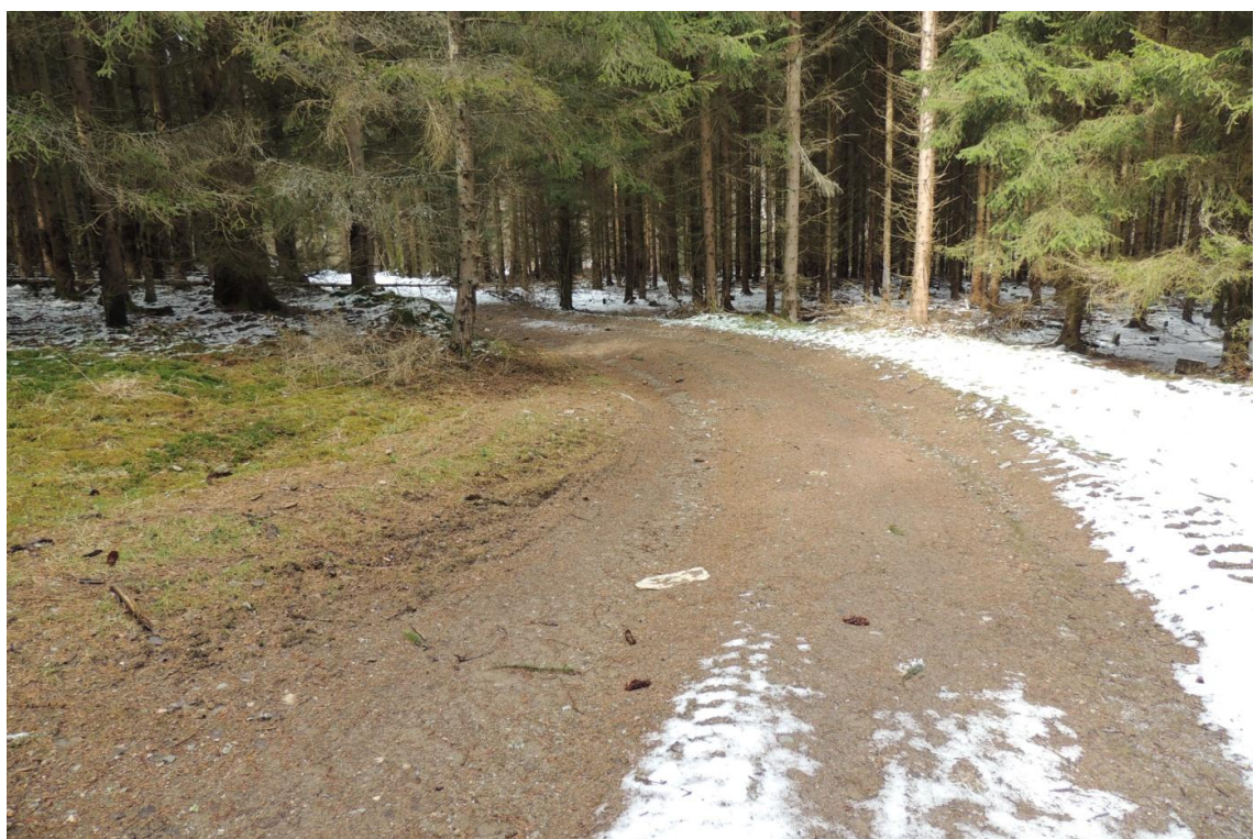
Obr.11 Pohled na lesní cestu Švejcova pila těsně před rekonstrukcí
