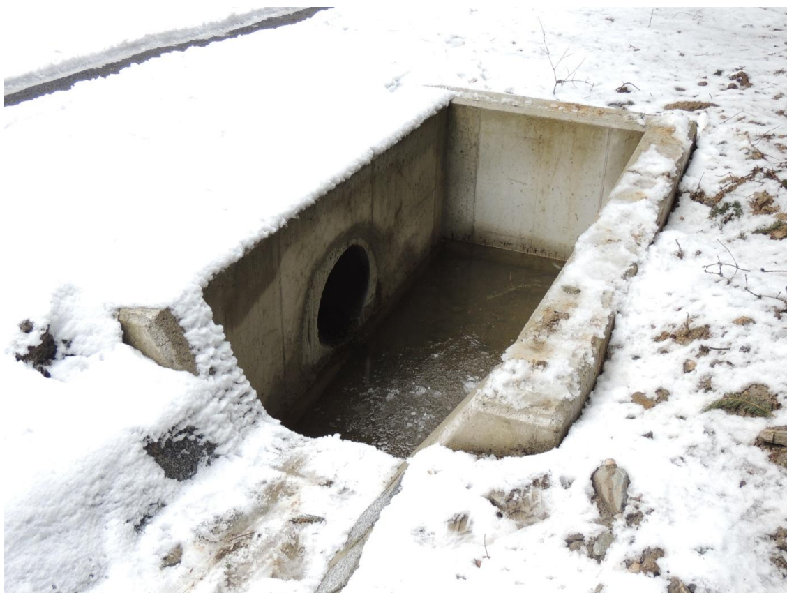
Obr.15 Pohled na propustek u lesní cesty Hraničář
