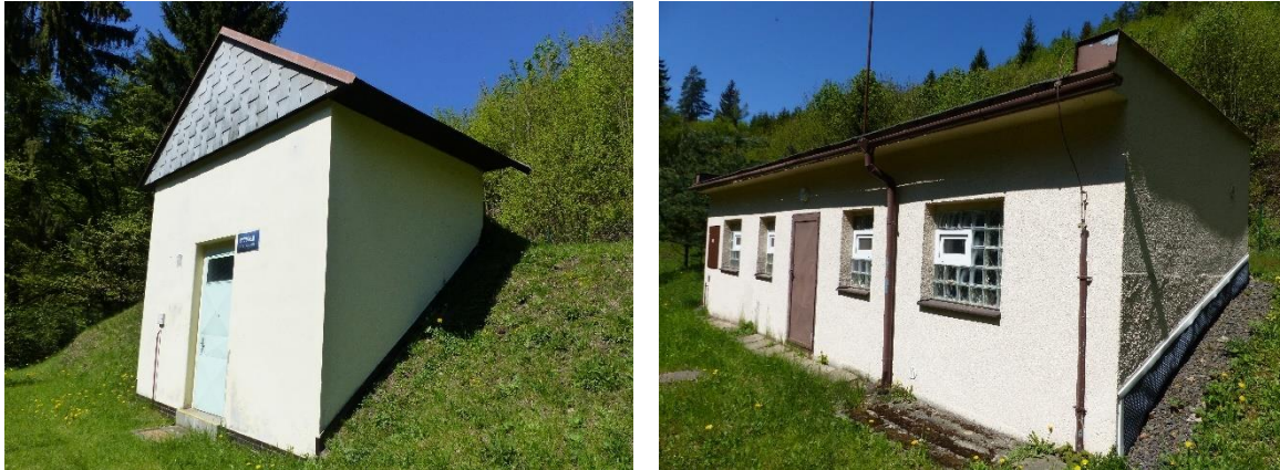
Obr. 3.14 Vodojemy Albrechtice a) akumulace 2 \times 250 \text{ m}^3 (vlevo); b) akumulace 2 \times 390 \text{ m}^3 (vpravo) [15]
