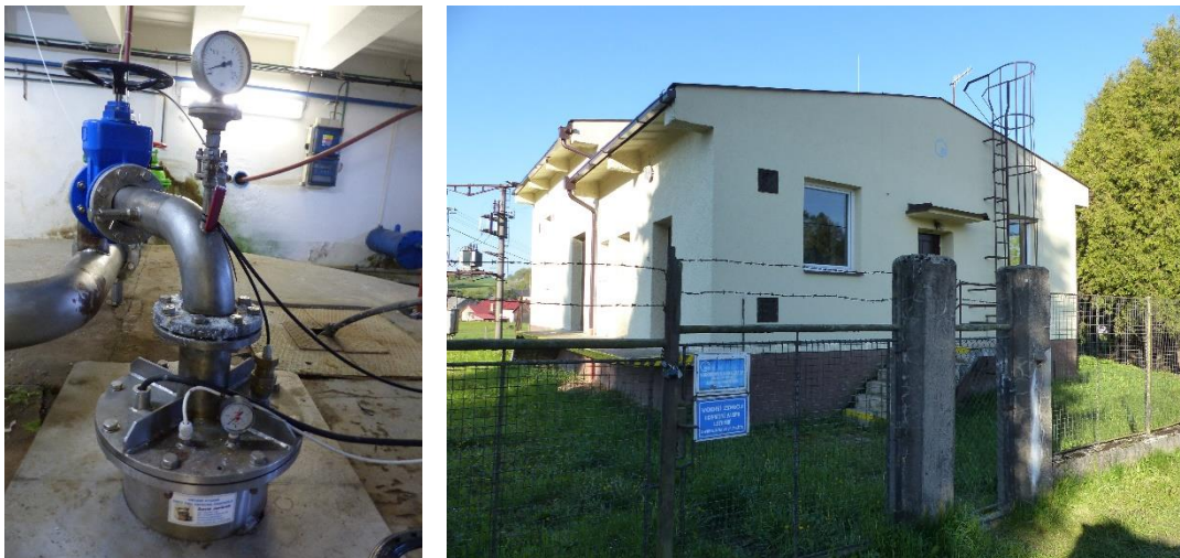
Obr. 3.6 a) Vrt V-2 (vlevo); b) stavba ČS u vrtu V-2 (vpravo) [15]
