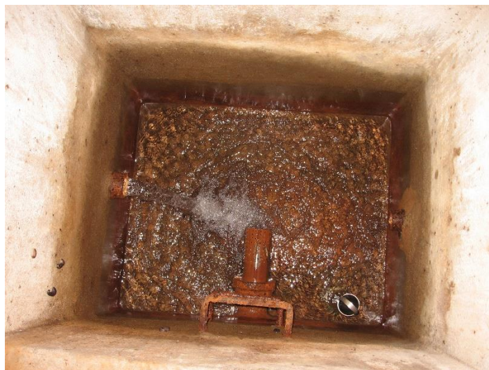
Obr. 3.9 Sběrná jímka v Albrechticích [15]
