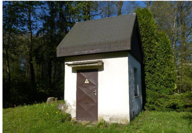
Obr. 3.7 Stavba nad V-3 [15]
