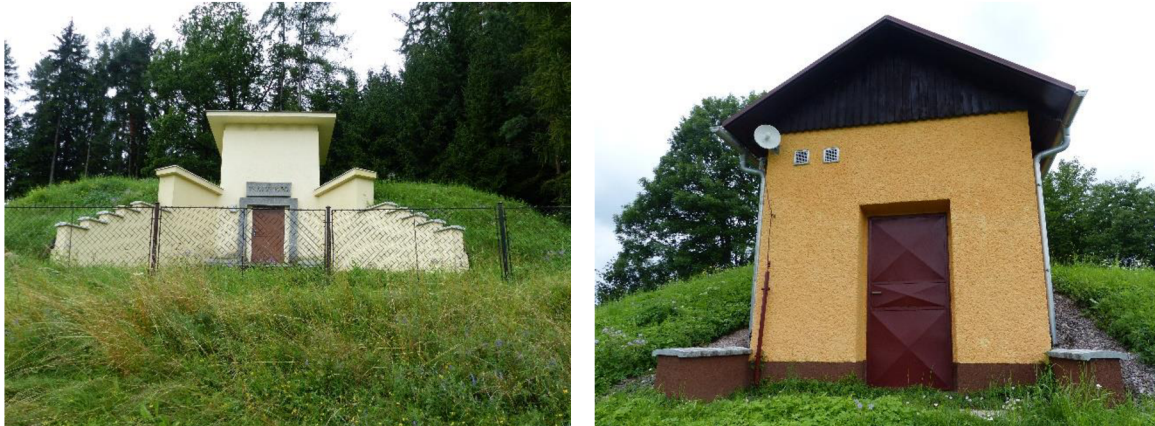
Obr. 3.4 a) Vodojem Ovčín (vlevo); b) vodojem Písečná (vpravo) [15]
