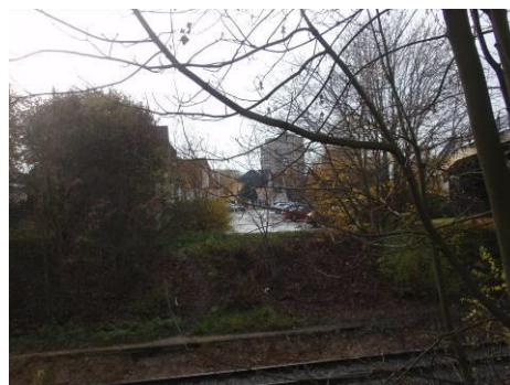
Obrázek č. 113: Opěrná zed' (Tech, 2020)
