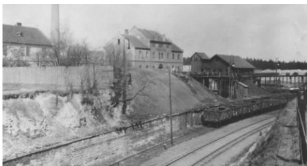
Obrázek č. 109: Opěrná zeď (Anonym)
