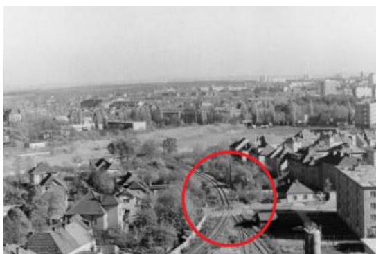
Obrázek č. 169: Ul. U vodojemu (Anonym)
