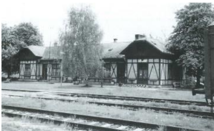
Obrázek č. 75: Výpravní budova Kl. Dubí (Krejčířik, 2005)
