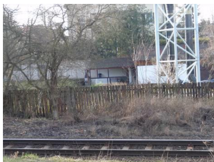
Obrázek č. 110: Opěrná zeď (Tech, 2020)
