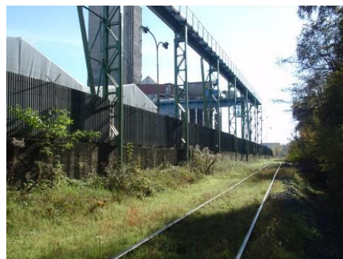
Obrázek č. 39: Areál Kablo Kladno, NKT (Techmanová 2020)
