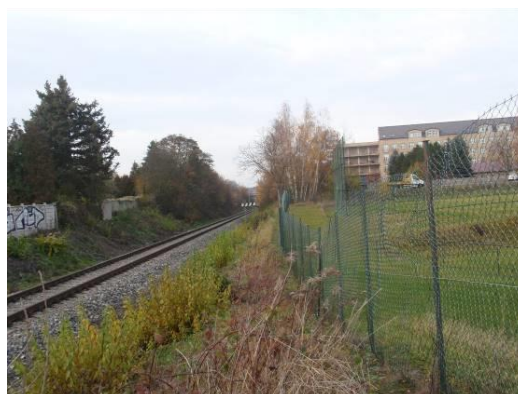
Obrázek č. 117: Bývalý přejezd (Tech, 2020)
