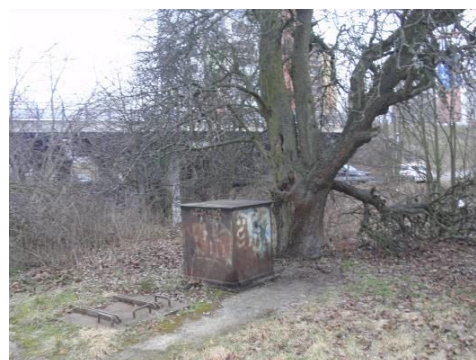
Obrázek č. 115: Bývalý přejezd (Tech, 2020)
