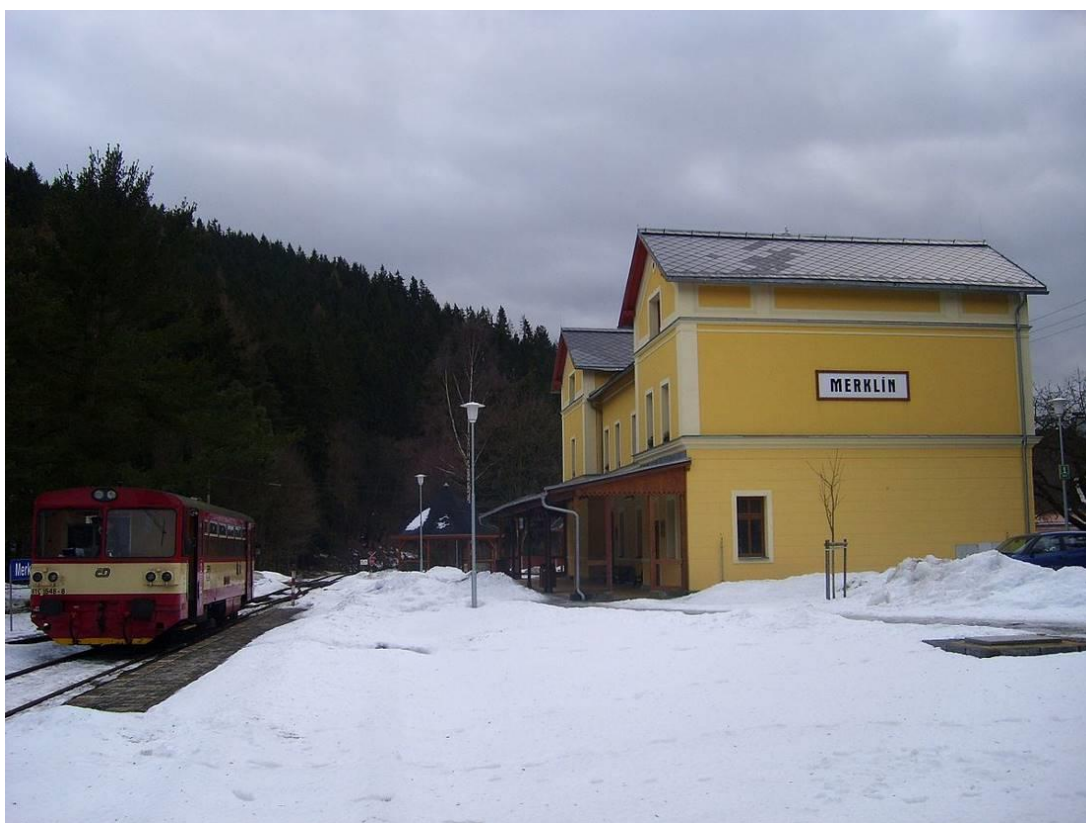
Obrázek č. 12: Výpravní budova železniční stanice Merklín u Karlových Varů (Wikipedie)
