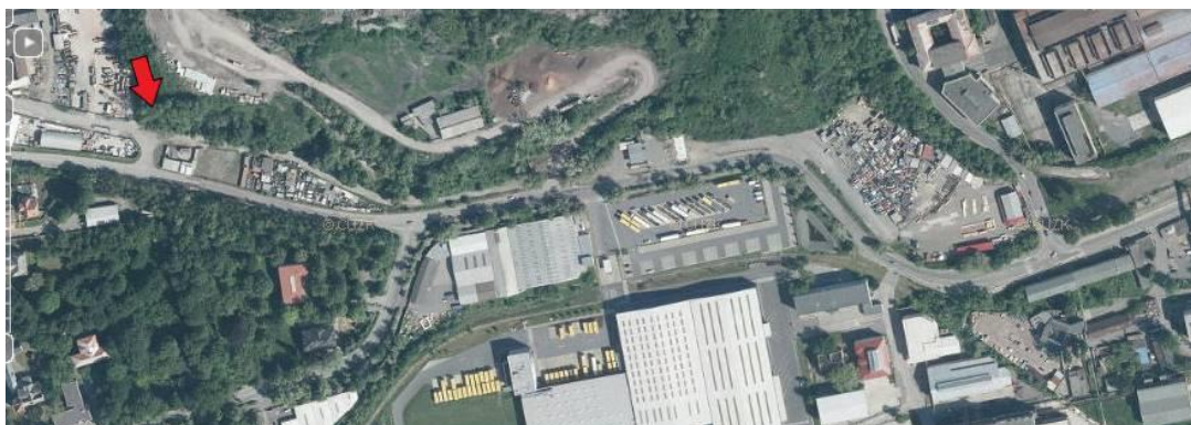
Obrázek č. 120: Zrušená vlečka Průhon Staré Kladno k silničnímu přejezdu (Geoportál)
