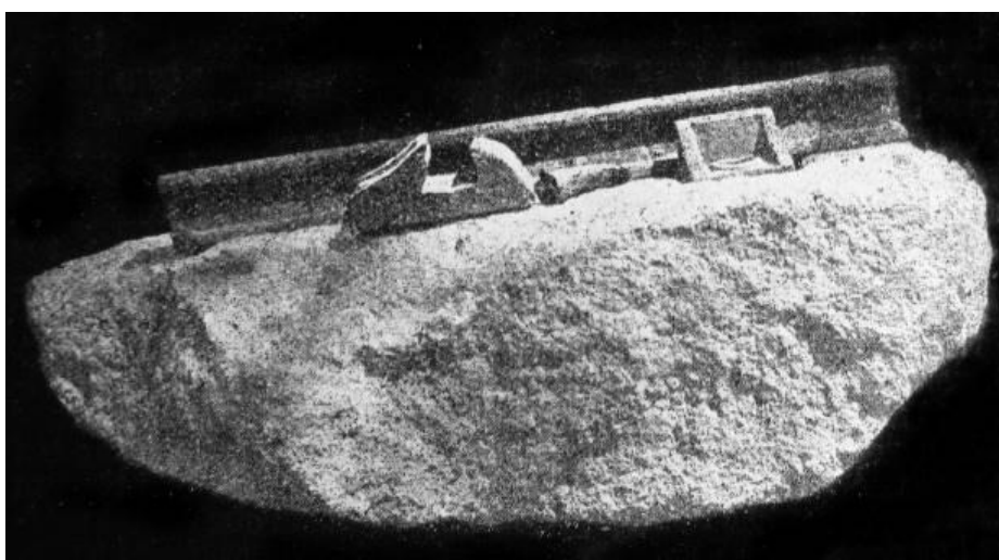
Obrázek č. 54: Zlomek širokopatní kolejnice s kamenným podkladem a stolička z Pražskolánské koněspřežky (Nechleba, 1919)
