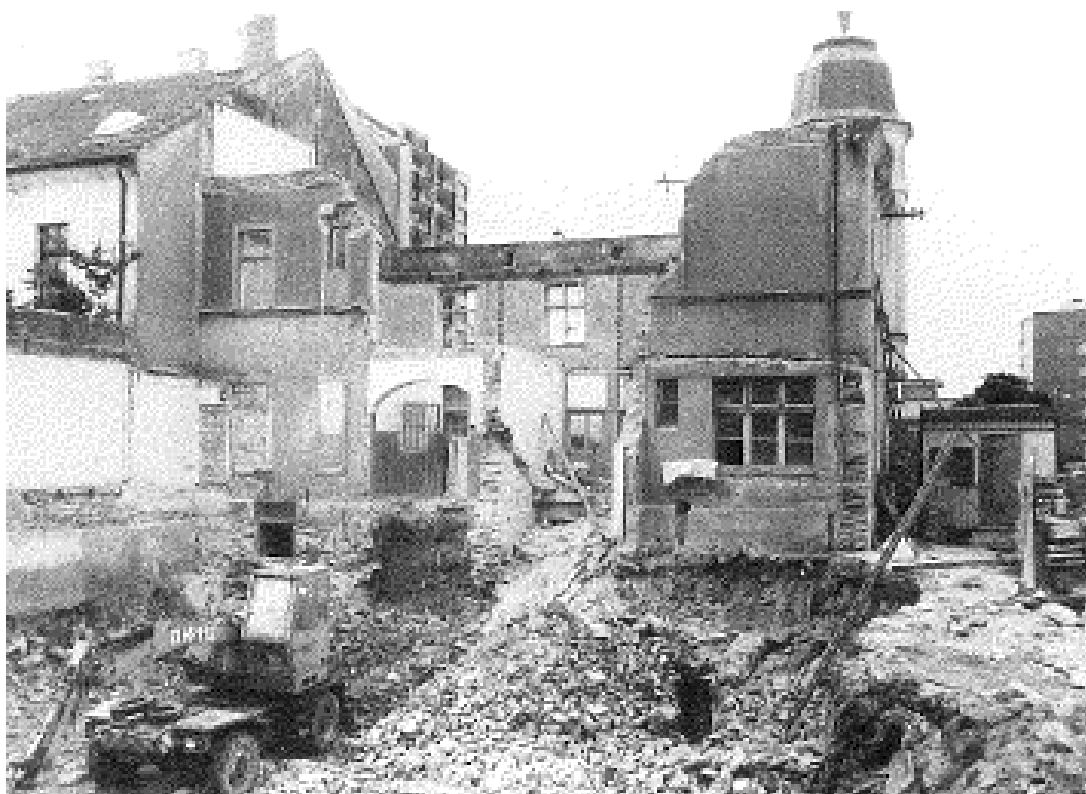
Obrázek č. 23: Asanace domu na ČS. Armády, Nové Kladno (Kaše 1970)
