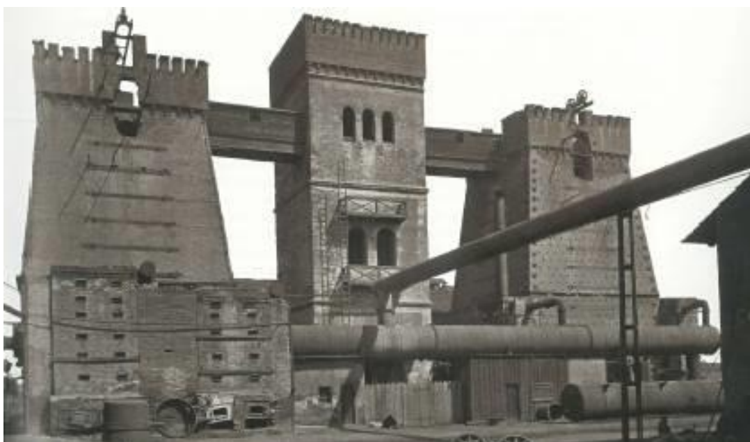
Obrázek č. 44: První dvě kladenské vysoké pece belgického typu (J.Eckert,NTM)
