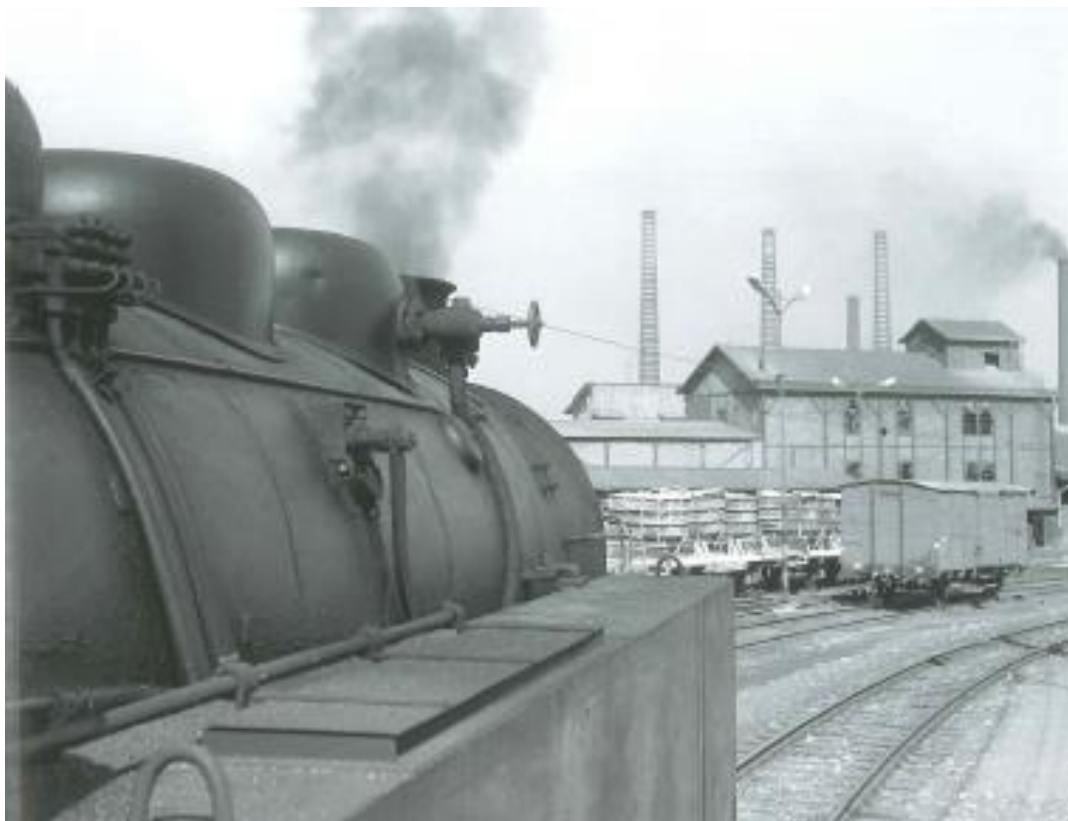
Obrázek č. 153: Vjezd do stanice Kladno-Prádlo (Zeithammer, 2017)
