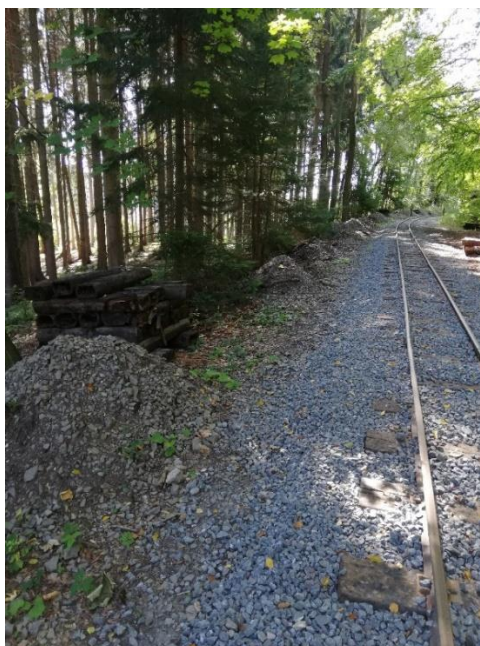
Obrázek 38: Hřebeč - úzkorozchodná železnice (Foto: Petra Škeříková)
