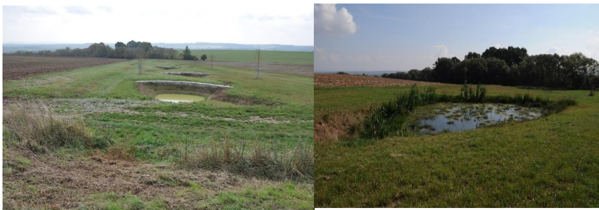
obr. č. 29 Příklad kaskády tůní a umělých mokřadů pro odbourávání pesticidů z drenážních a povrchových vod, Plzeňsko (foto P. Fučík)
