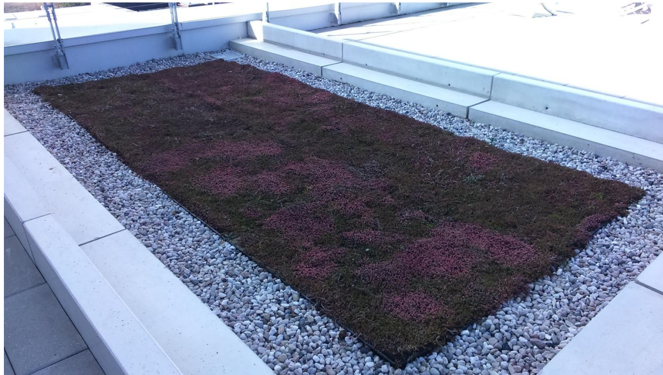
Příloha č. 10: Extenzivní výsadba rozchodníků 6. N. P. (foto autor)
