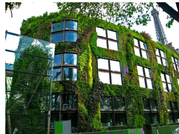
Obrázek 19: Stěna typu Mur Végétal na stěně muzea du Quai Branly v Paříži (zdroj: https://www.murvegetalpatrickblanc.com/realisations/paris-ile-de-france/musee-du-quai-branly )
