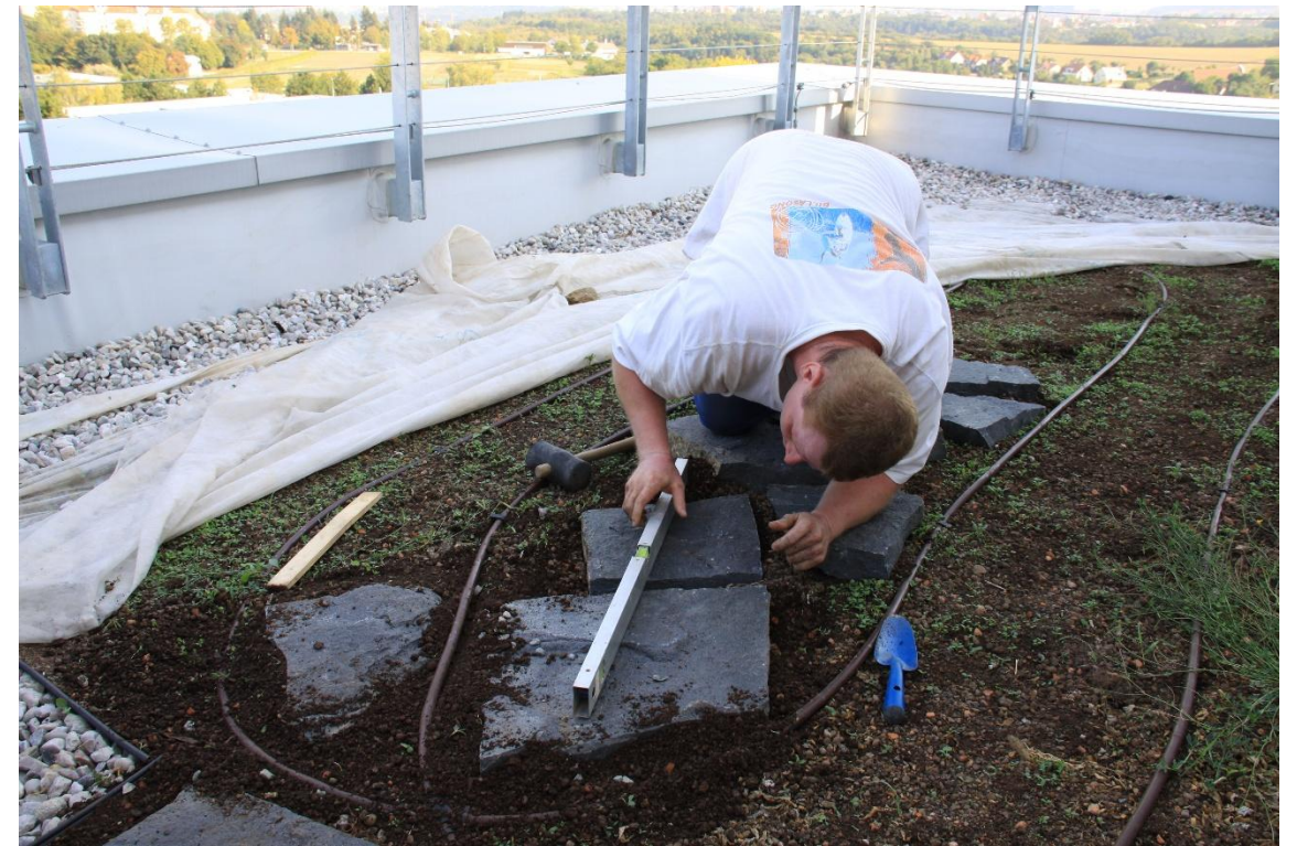
Příloha č. 8: Pokládání nášlapných kamenů (foto Ing. Alena Fedurcová)
