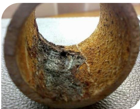
Obr. 1.3: Koroze ocelového potrubí [6]
