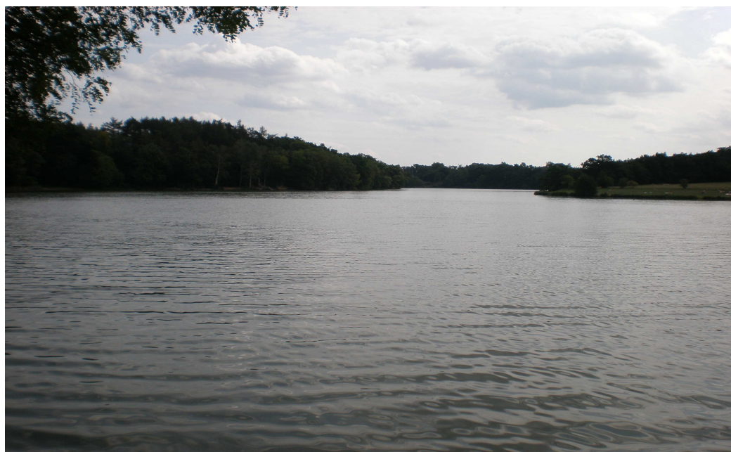
Obr. č.: 15 Pohled na napuštěnou nádrž (3.9. 2008)
