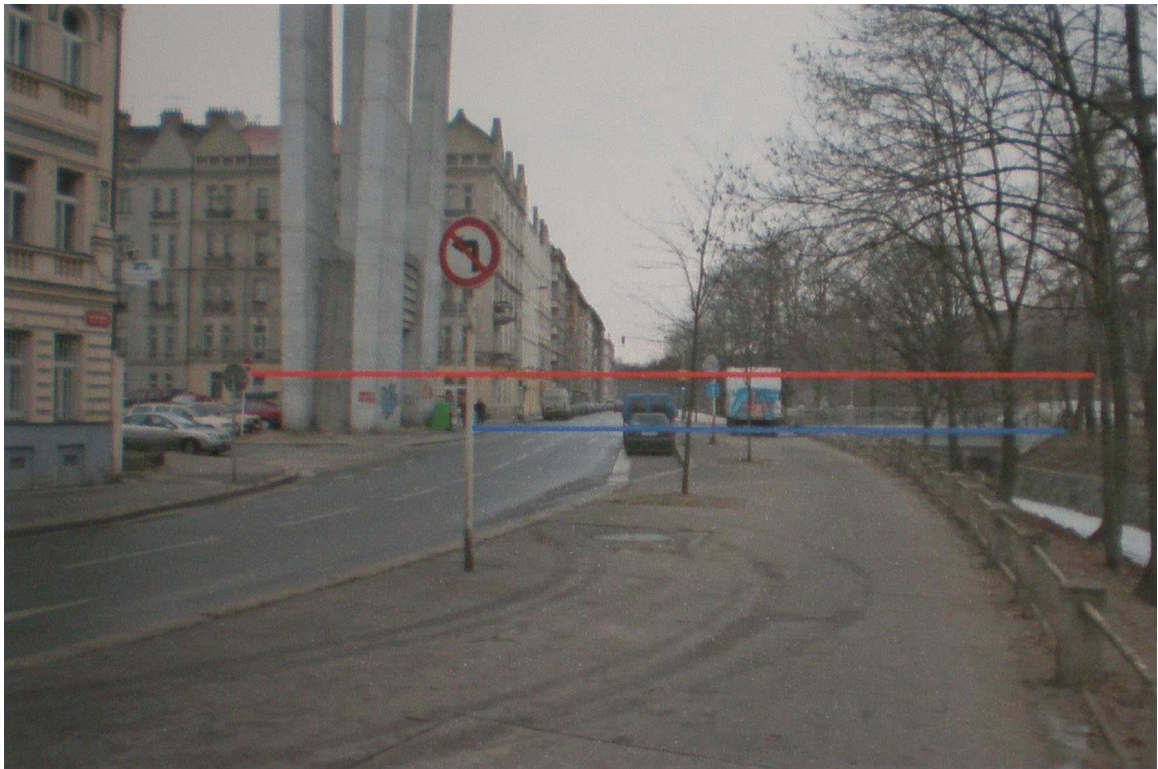
Obr. č.: 10 Ukázka zatopeného území při zvláštní povodni
