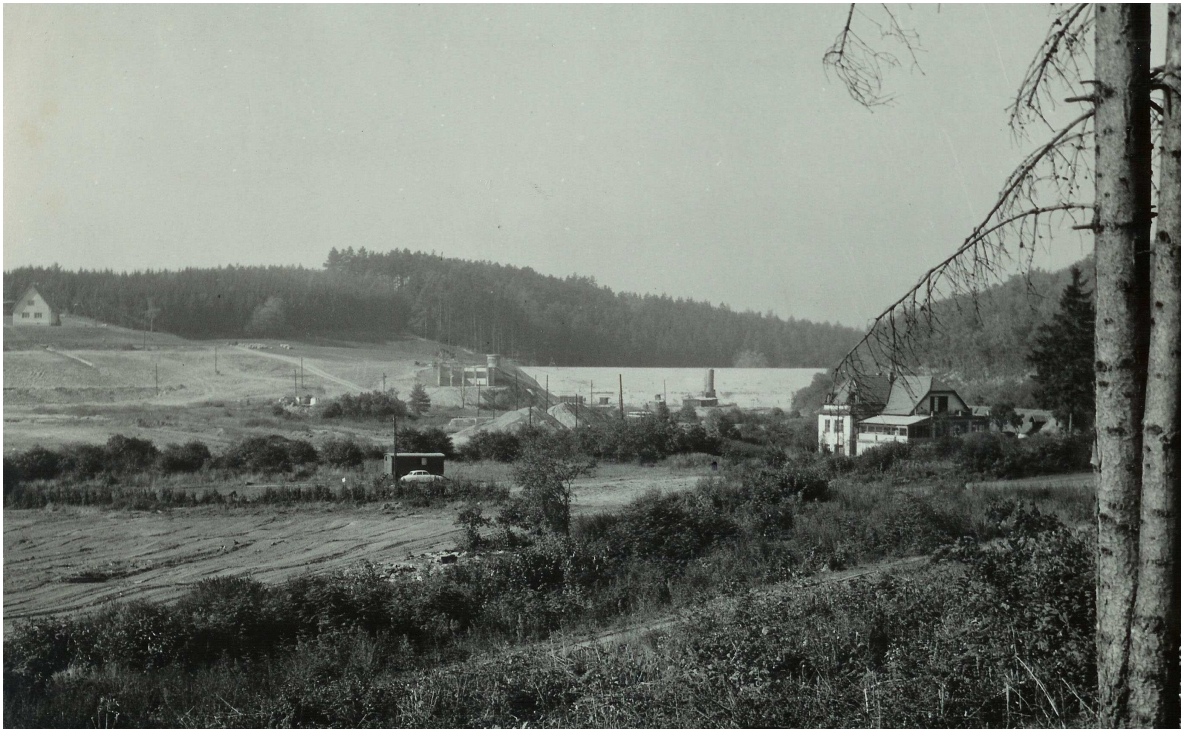
Obr. č.: 7 Výstavba nádrže, pohled od východu směrem na dnešní hráz
