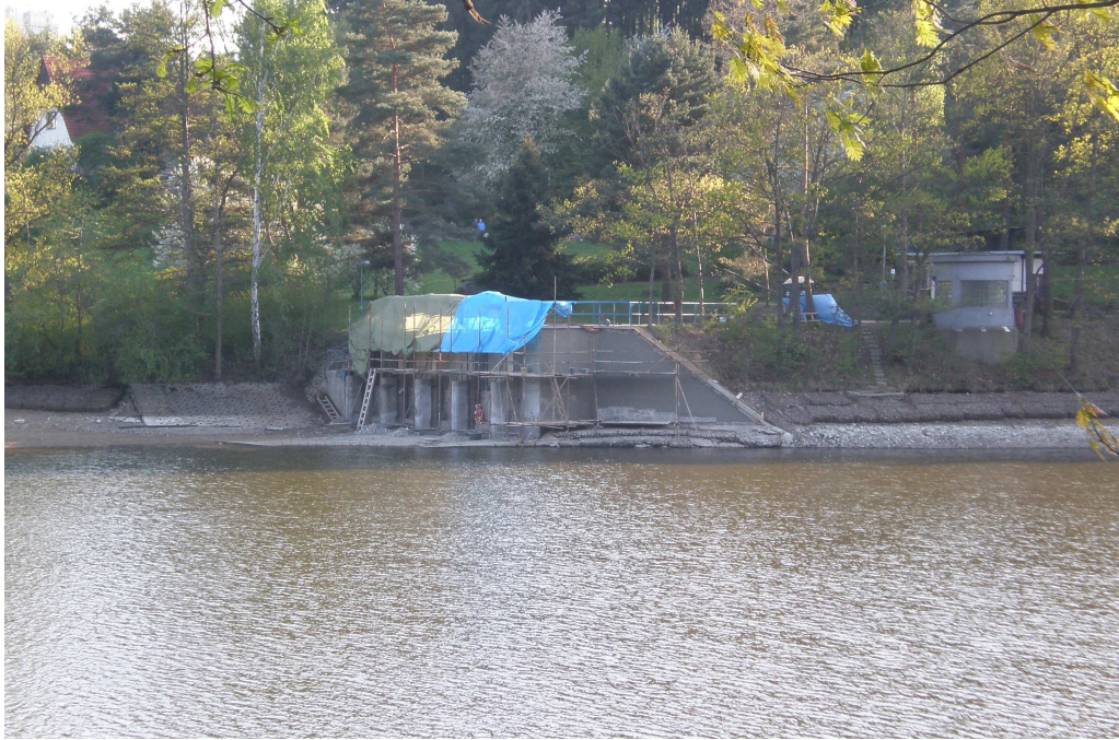
Obr. č.: 12 Sanace betonů bezpečnostního přelivu, snížená hladina (19.4. 2009)
