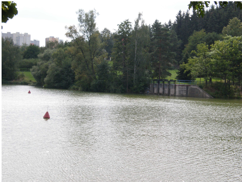
Obr. č.: 13 Pohled na bezpečnostní přelivy při napuštěné nádrži (3.9. 2008)
