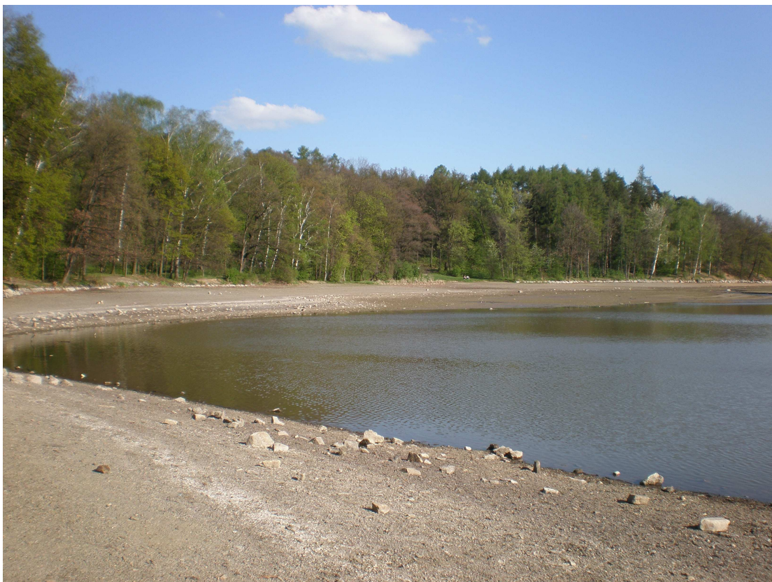
Obr. č.: 14 Snížená hladina nádrže z důvodů údržby bezpečnostních přelivů (19.4. 2009)
