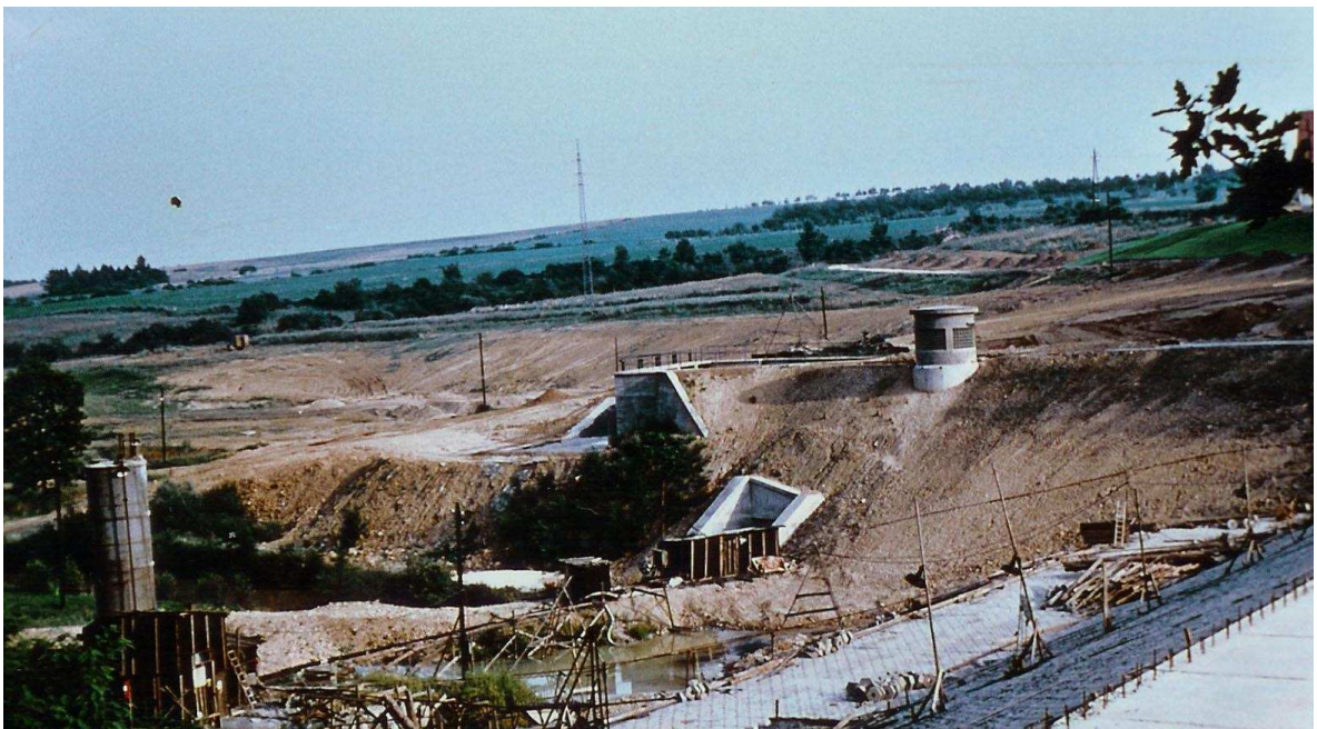
Obr. č.: 8 Výstavba nádrže, pohled z pravé strany hráze směrem na nádrž
