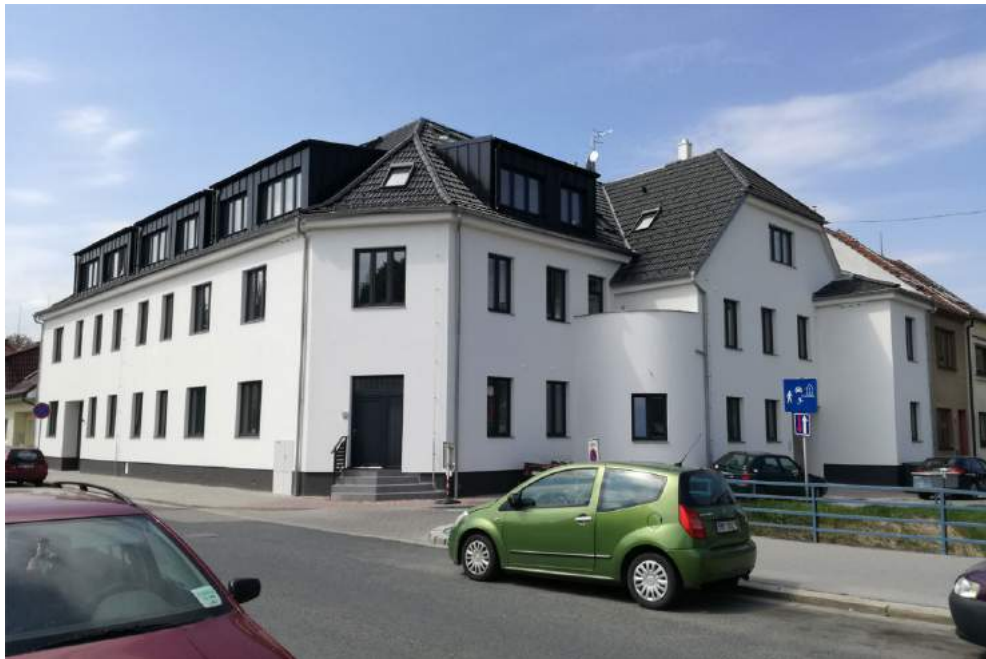
Obr. č. 52: Srovnání původní a aktuální podoby budovy rezidence Točná [37]
