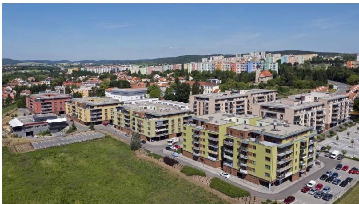
Obr. č. 50: Zcela dokončené bytové domy na ulici u Leskavy [35]
