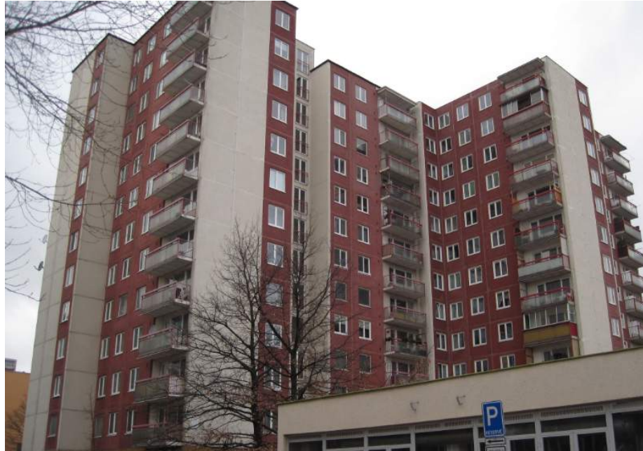
Obr. č. 28: Ukázka členitosti panelového domu typu B 70 [32]
