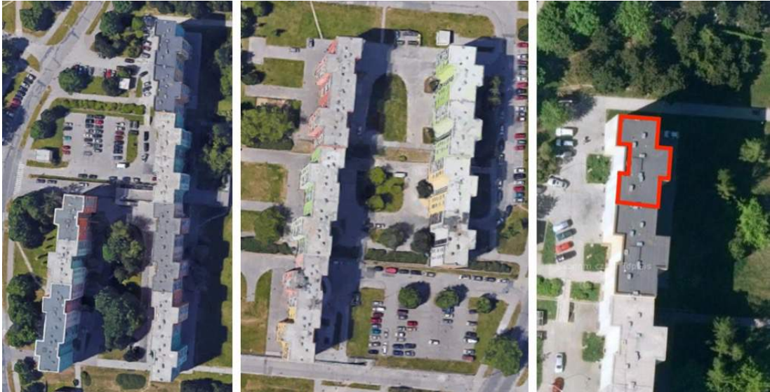
Obr. č. 35: Půdorysné typy a z nich poskládané bloky – Mikuláškovo nám. [29] + vlastní úprava
