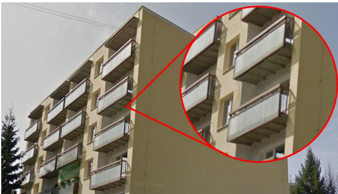
Obr. č. 37: Typické žebrování podhledu lodžii u typu B70 [29] + vlastní úprava
