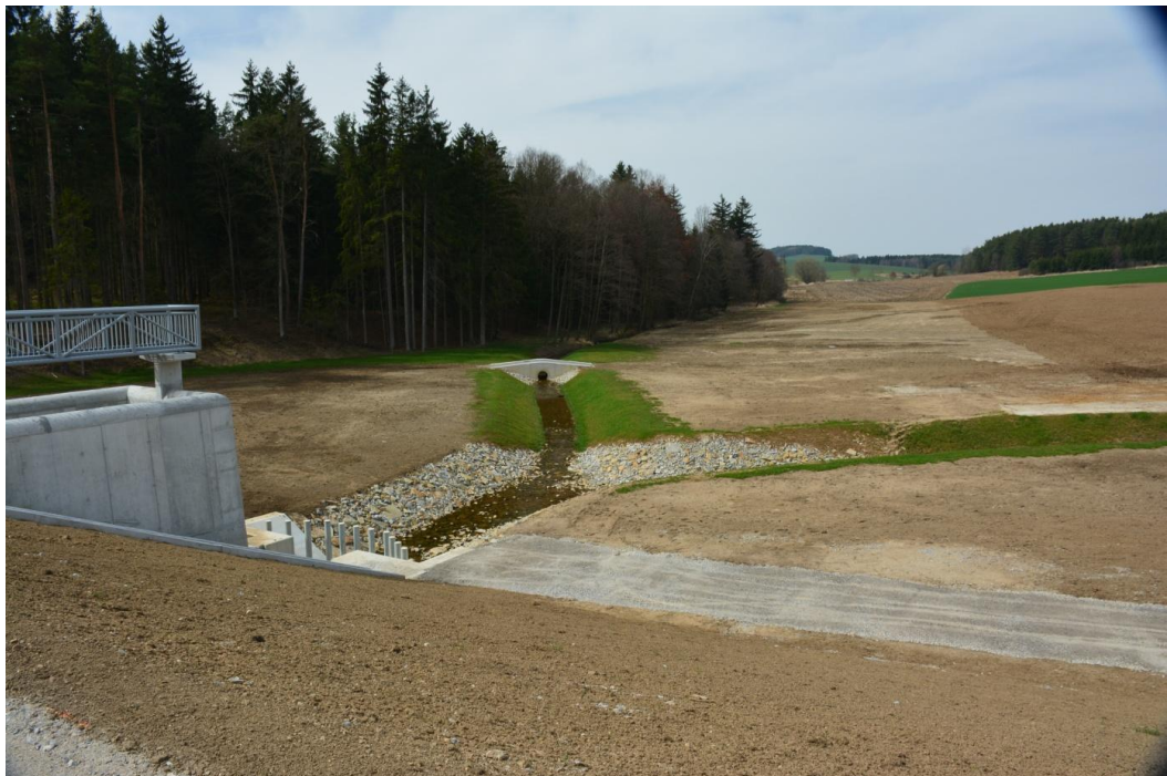
Obr. 19 Poldr na Bílském potoce, pohled na retenční prostor, vlevo lze vidět bezpečnostní přeliv (foto:Podlaha V.)
