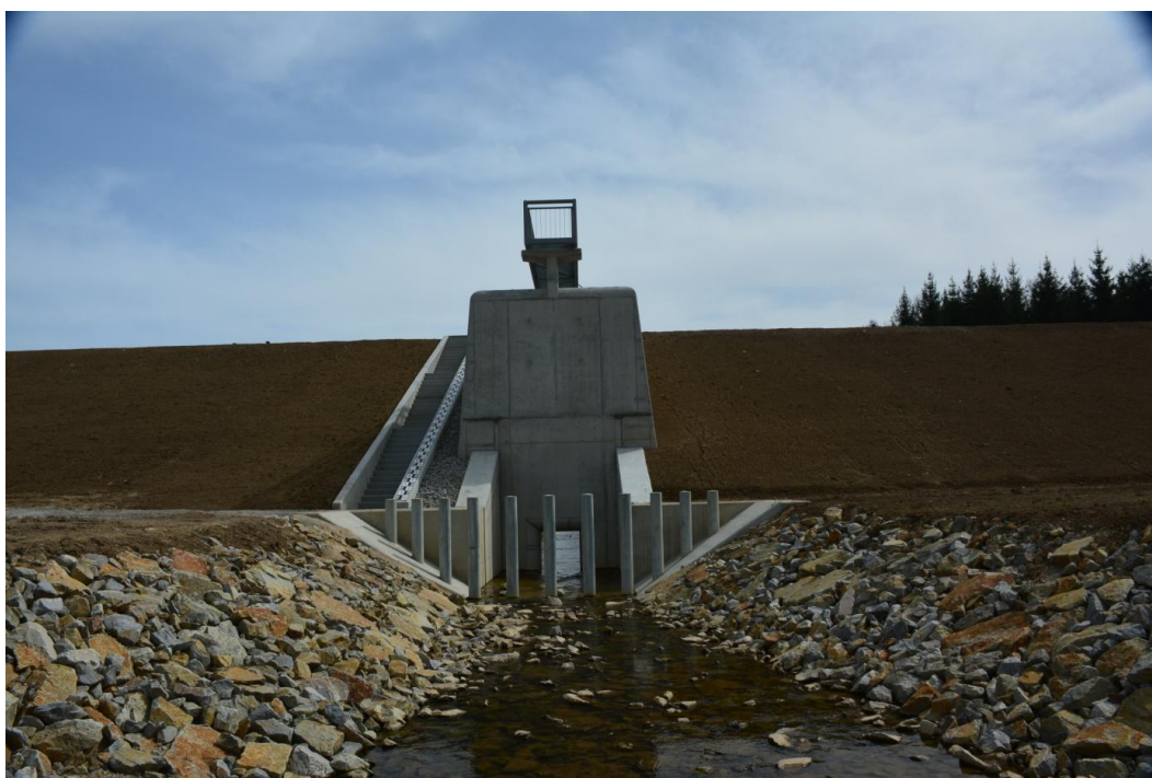
Obr. 20 Poldr na Bílském potoce, pohled na sružený objekt, dole patrný výtokový otvor. (foto:Podlaha V.)
