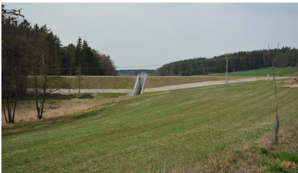
Obr. 18 Poldr na Bílském potoce, pohled na vzdušný svah hráze, (foto: Podlaha V.)
