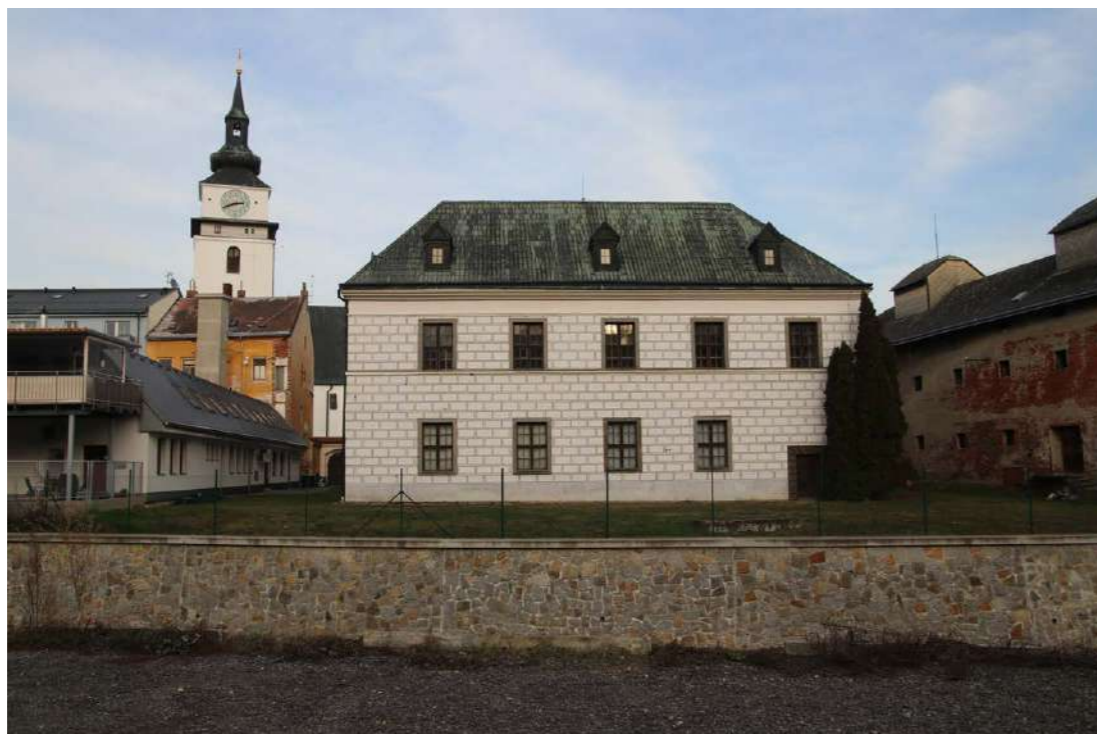
bývalé Lutheránské gymnázium a protipovodňová stěna z přírodního kamene
