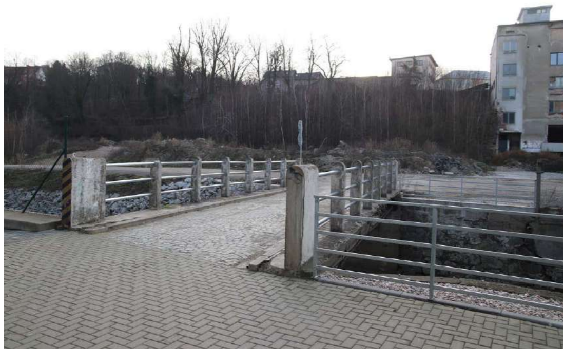
lávka za budovou Nový Svit propojující řešené území s centrem města
