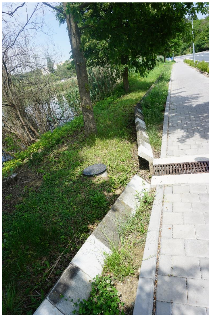
Obr. 7 Betonové zábrany mezi rybníkem a pozemní komunikací
